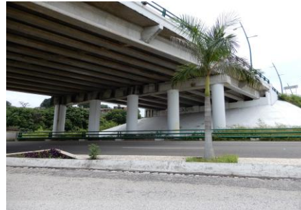
Figura 41 Vista de la Pila No. 3 (Inspección realizada por SERVER Ingeniería, 2017)
