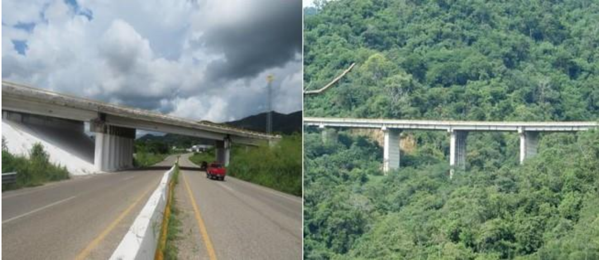
Figura 39 Tipología de puentes carreteros del estado de Chiapas que fueron contemplados en la investigación. (SERVER Ingeniería S.A. de C.V.)
