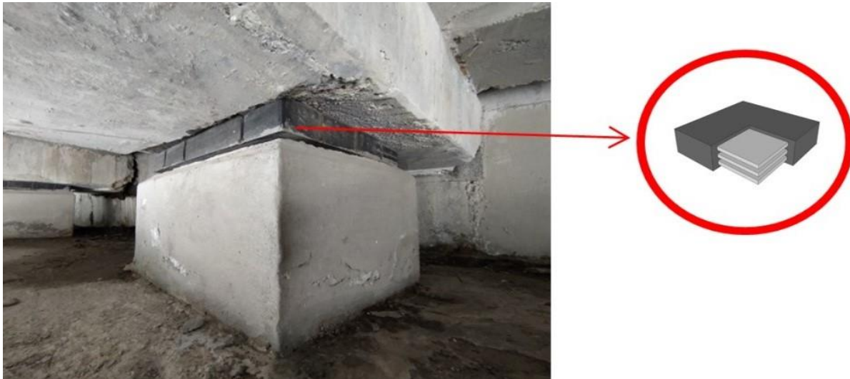
Figura 32 Dispositivos de apoyo de neopreno integral con placas de acero A-36 en su interior. (Autoría propia).
