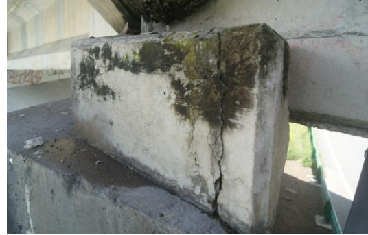
Figura 56. Otro detalle de la fractura en cara lateral del tope sísmico de la Pila No. 3.
