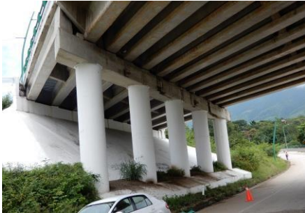
Figura 40 Vista de la Pila No. 2 (Inspección realizada por SERVER Ingeniería, 2017)
