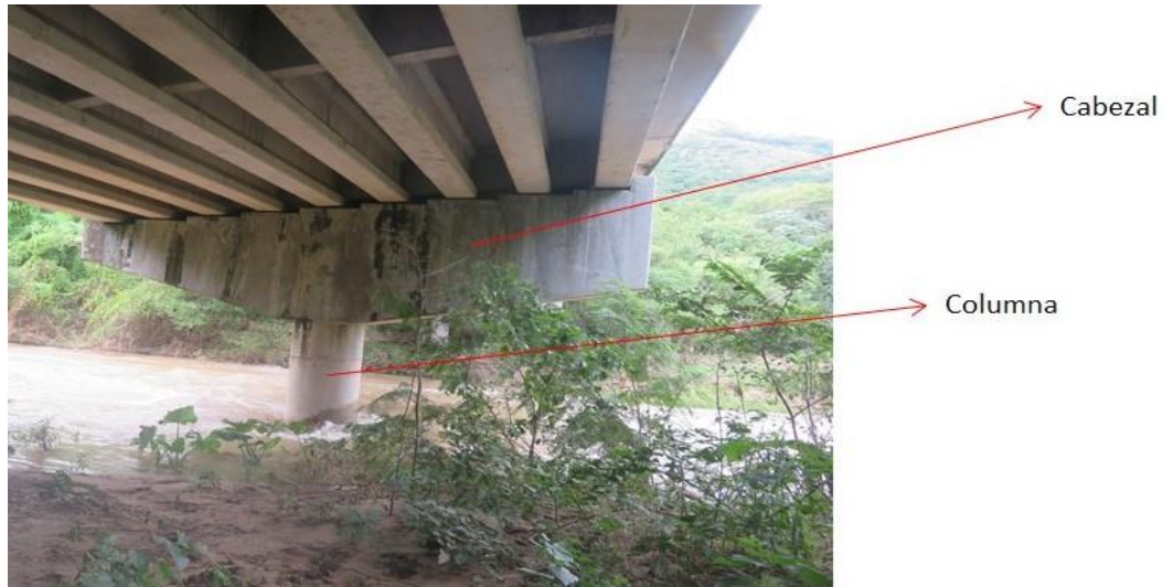
Figura 29 Elementos de una pila tipo columna. (Autoría propia).
