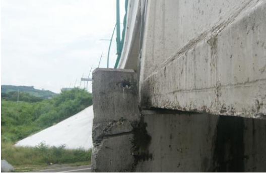
Figura 51. Tope sísmico sobre Pila No. 2, lado izquierdo.
