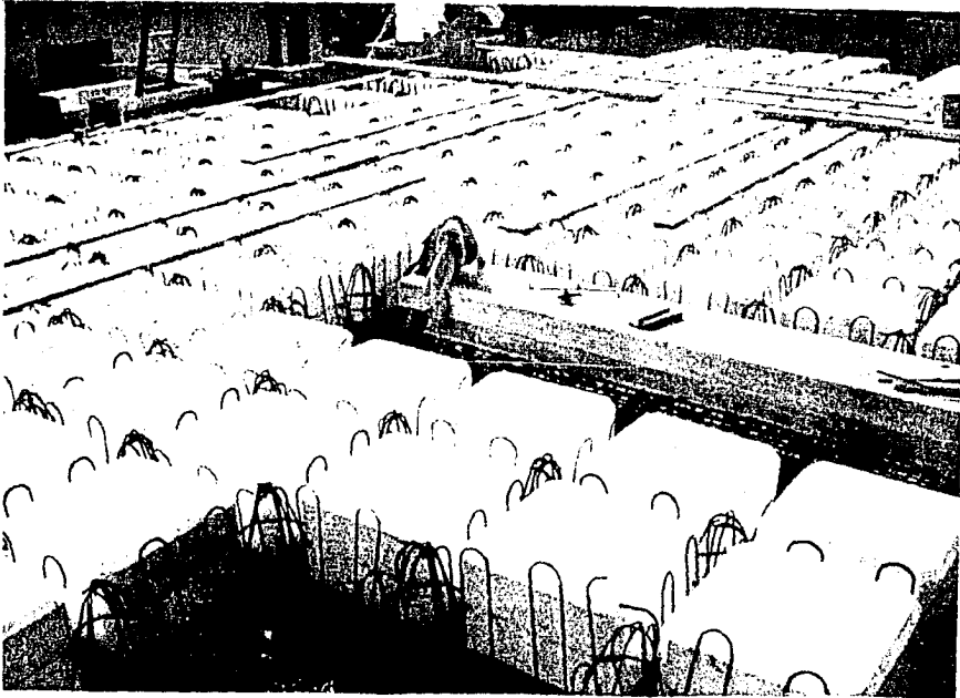
Cajas perdidas para losas reticulares.
