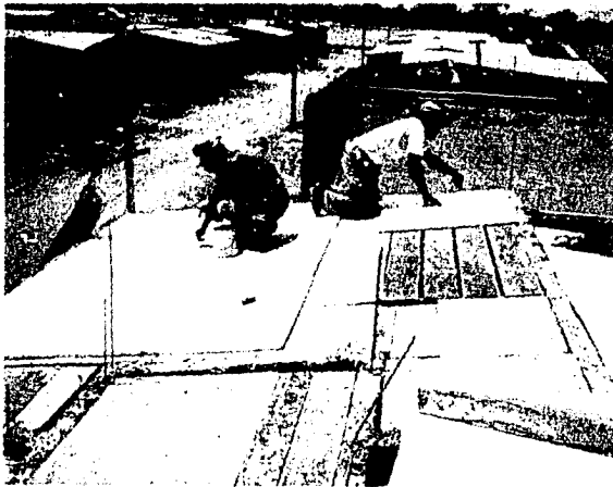
Armado tendido sobre el poliestireno expandido.
