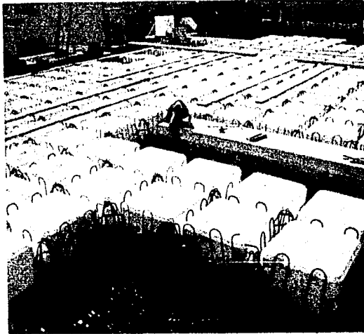
Cajas perdidas para losas reticulares
