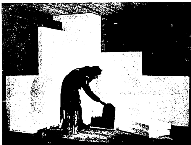
Aplicación de adhesivo en frío
