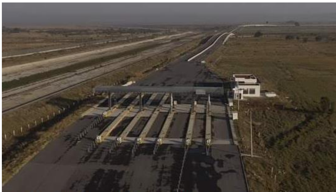
Cimientos del NAICM, foto panorámica, EL Economista, 2020.
