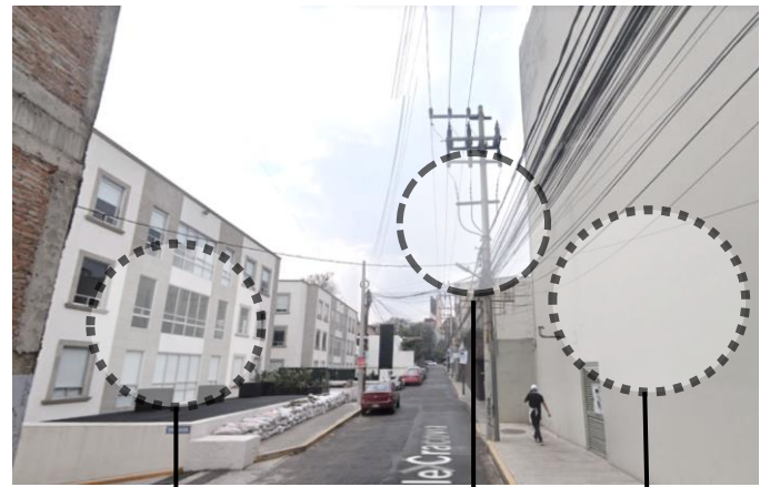
Imagen 17 y 18. Fachada del predio frontal. Fuente: Google maps
