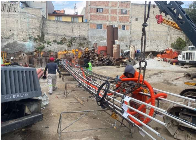
Figura C.9 Izaje de armadura de acero de refuerzo.
