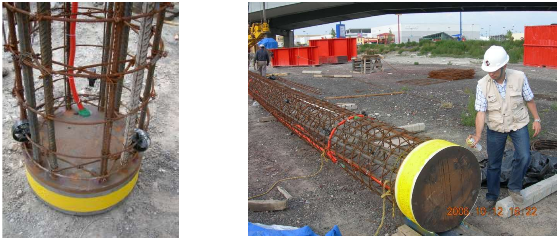
Figura 2.14 Celda de carga en la punta de la pila, Ibarra et al. (2008).
