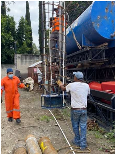
Figura C.9 Izaje de armadura de acero de refuerzo.
