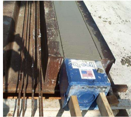
Fabricación del pilote con celda Osterberg
