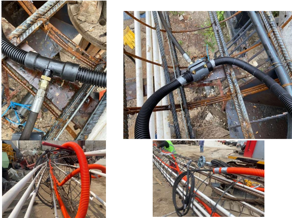
Figura C.6 Componentes hidráulicos en pila de prueba.
