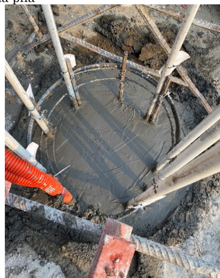
d) Acabado final de pila
