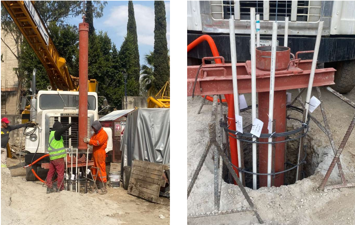
Figura C.11 Tubería tremie para la colocación de concreto de pila de prueba.
