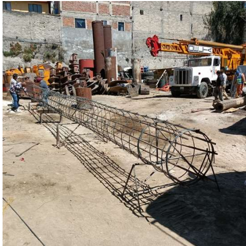
Figura C.2 Armado de la pila de prueba.
