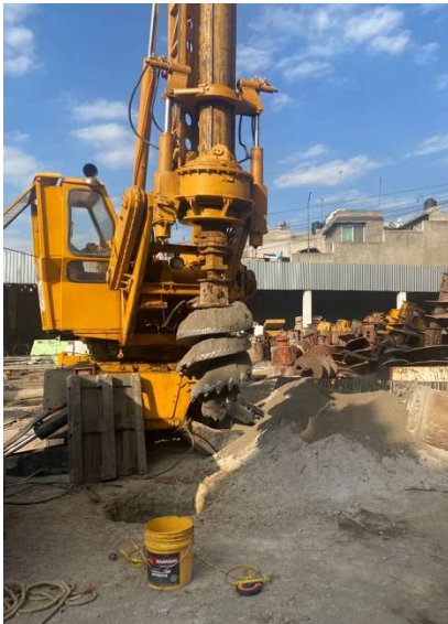
a) Perforación con broca
