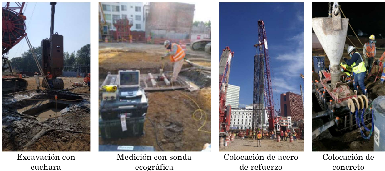
Figura 3.33 Aspectos durante la construcción de los barrettes .
