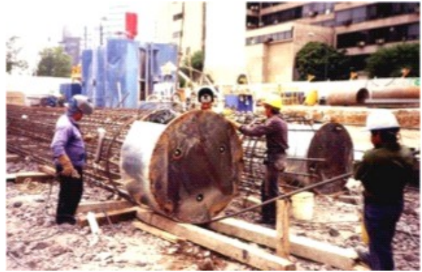
Figura 3.16 Carga contra desplazamiento, obtenida en la primera carga por punta de la pila PB, Schmitter (2016); (der.) aspecto de celda Osterberg, cortesía E León.
