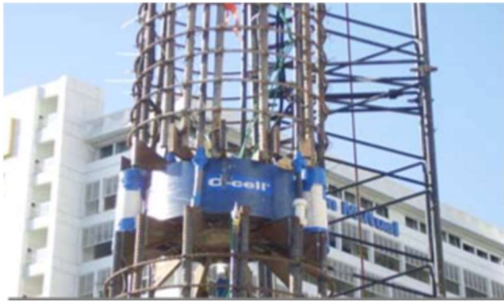
Figura 3.4 Arreglos de celda Osterberg en pilas de hélice continua (www.fugro-loadtest.com).
