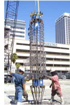
Figura 3.4 Arreglos de celda Osterberg en pilas de hélice continua (www.fugro-loadtest.com).
