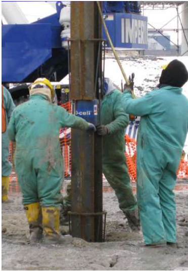
Figura 3.6 Celda de carga en pilote metálico de sección H.
