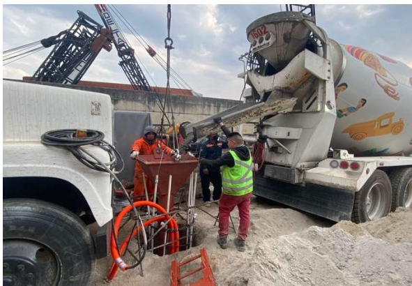
a) Vaciado de concreto desde camión revolvedora.
