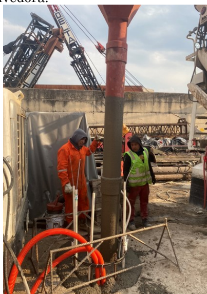
c) Retiro de tubería tremie
