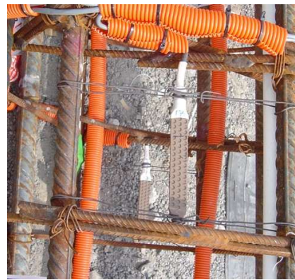
Deformímetro ahogado en concreto
