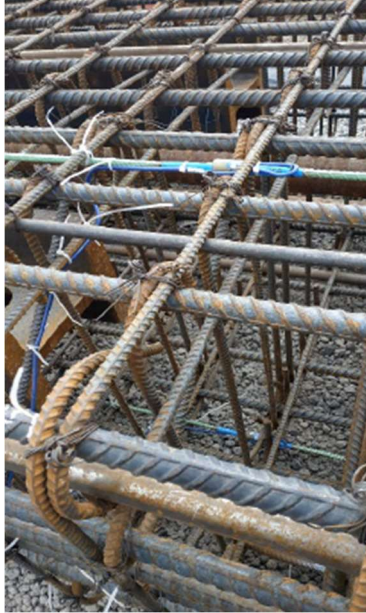
Sister bars adosados al acero
