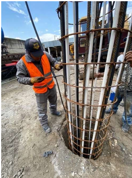
Figura C.10 Colocación de acero de refuerzo en perforación.
