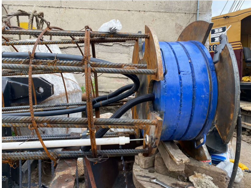
Figura C.4 Acoplamiento de instrumentos para las placas inferior y superior.
