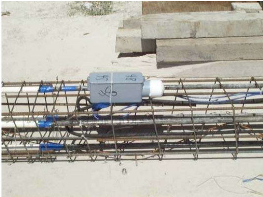
Instrumentación del pilote
