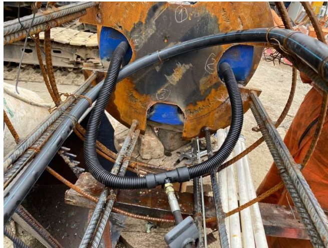
Figura C.3 Instalación de celda bidireccional en pila de prueba.
