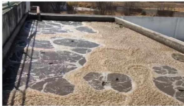
*Figura 5 Reactor aerobio con espumas marrones y aireación no uniforme*
