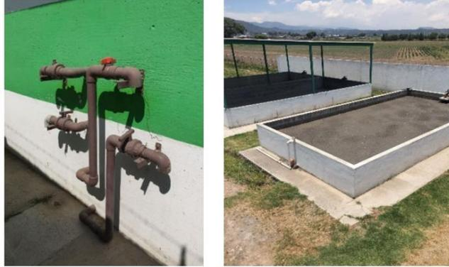
*Figura 4 Llaves para el muestreo de lodos del reactor anaerobio usadas para purga de lodos y lechos de secado*
