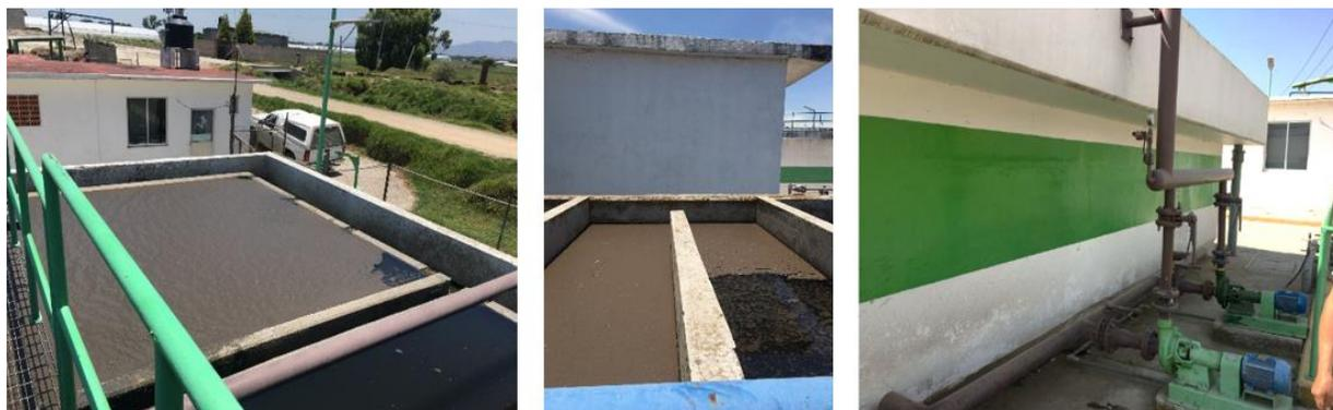
*Figura 3 a y b) Sólidos flotantes en sedimentadores y tanque de desinfección c) tuberías de purga de lodos
