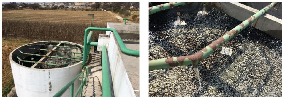
*Figura 8 a) Filtro percolador b) Aspersión y medio de soporte no uniforme del filtro percolador*
