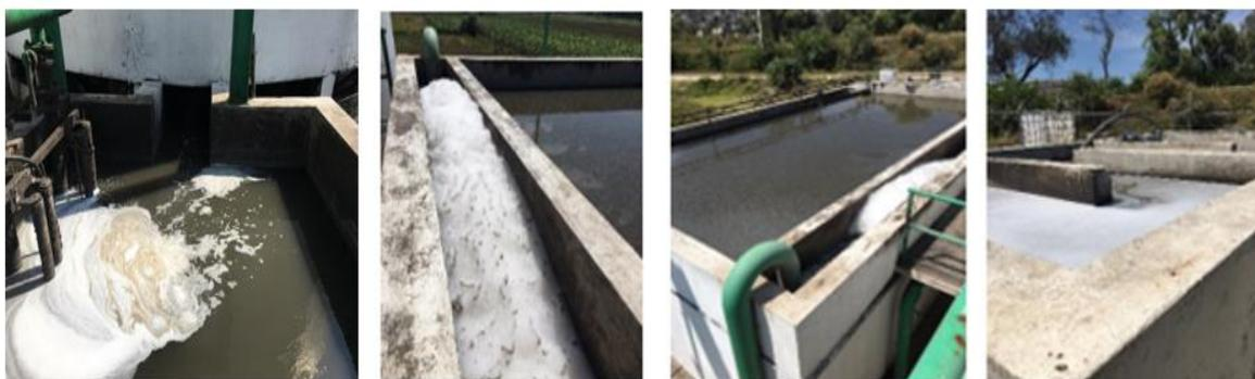
*Figura 7 a) espumas en cárcamo de filtro percolador y b) espumas y sólidos en tanques sedimentadores c) espumas y sólidos en tanques de desinfección.*
