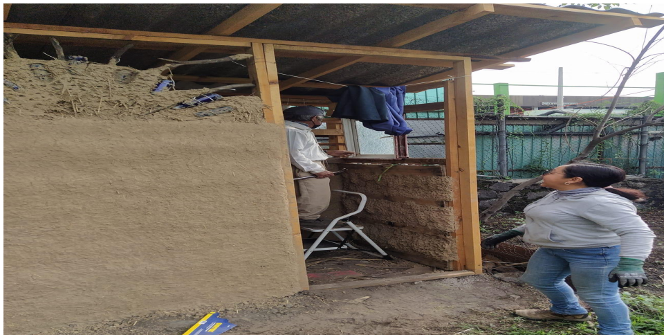
Foto 23 "Bioconstrucción de baño seco terminado de los acabados, y la colocación de la puerta para la entrada al baño "
