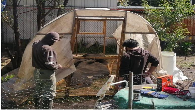
Foto 24 --Últimos detalles del invernadero, colocación del plástico para recubrir la estructura. Equipamiento para germinar plantulas y hacer crecer árboles frutales ”
