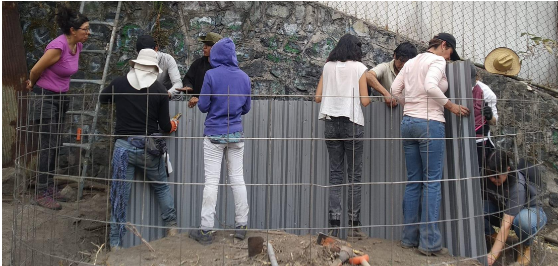
Foto 22 "Taller de bioconstrucción cisterna zamorana con aportaciones solidarias para los materiales; equipamiento utilizado para captar agua pluvial; imagen del trabajo de la colocación de mallaelectrosoldada y láminas que dan forma a la cisterna."
