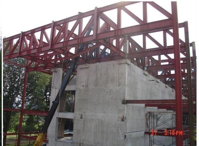
**Se solda las piezas de armadura y se fijan a placas en tapa de muros y se empieza a colocar vigas para los entresijos de la sala de lectura.**
