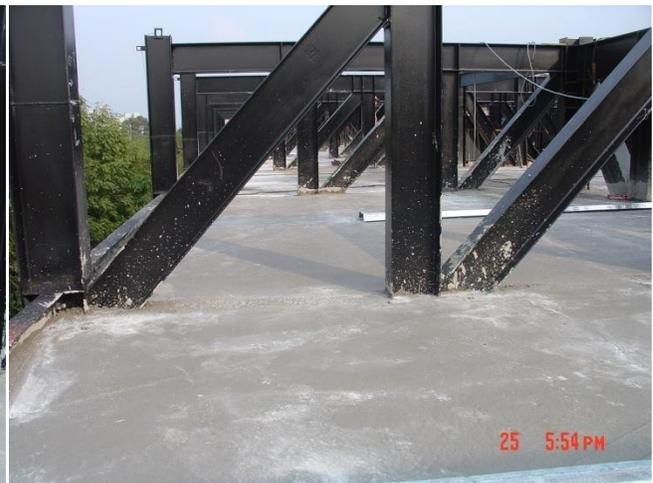
**Colado de losa tapa de Biblioteca. Se rellenó con tezontle y una capa de concreto, se niveló con una pendiente del 8,6 y 4% para poder pasar entre toda la estructura.**
