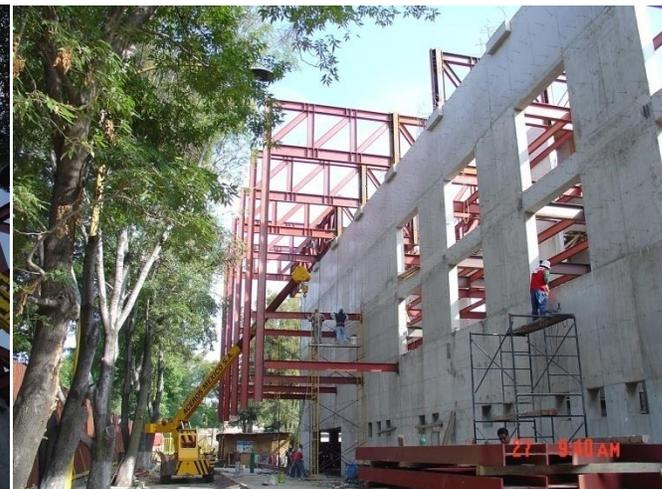
**Se están soldando las vigas de tensores vigas jois y las vigas de entresos a placas de muros que se ahogaron en el concreto.**
