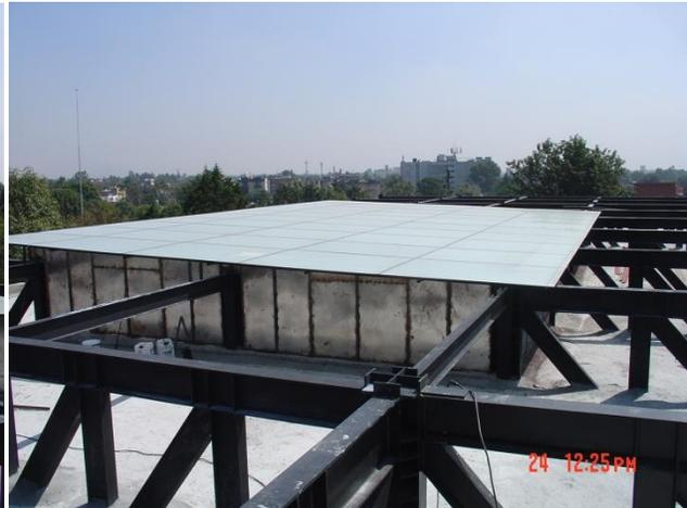
**Se colocó domo de cristal pulido, con película y encima de la estructura, para la zona central, abarca lectura de hemeroteca, escaleras, elevador, montacargas y una parte de circulación en acervo, con pendiente y modulado para poder hacer limpieza.**
