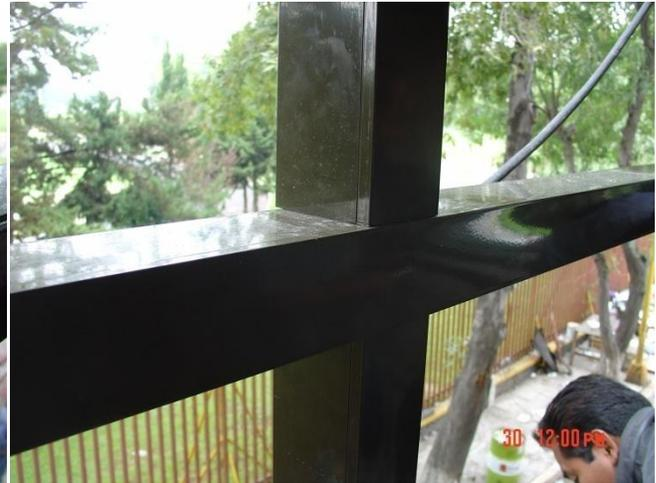
**Montaje de canaletas de aluminio, ángulo y tapa bolsa, para recibir cristal de 9 mm. Y las persianas de aluminio duranodick.**
