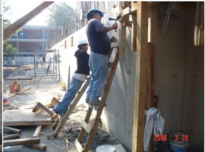
Loa muros son de concreto aparente, en la cimbra se está utilizando triplay de 9mm de pino de primera, amarrado con moños de alambón,
