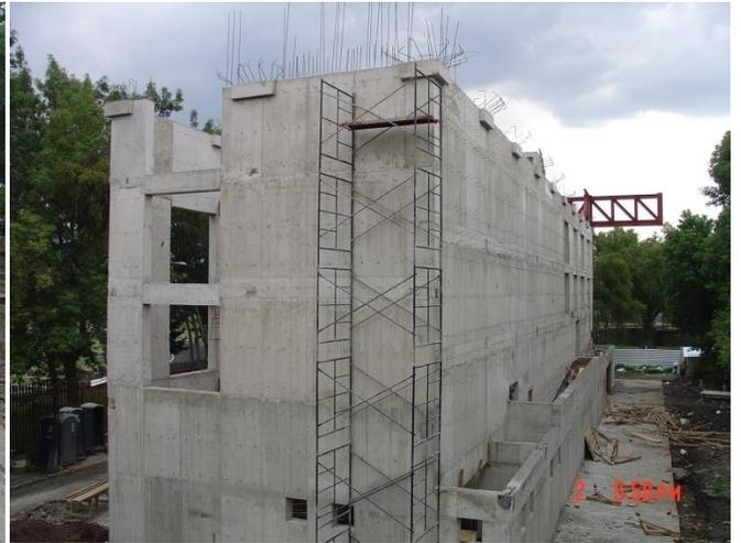
**Se empezó a descimbrar los muros de concreto de 50 cms de ancho, y se empieza a colocar vigas de acero Jois, en cumbre de muros.**
