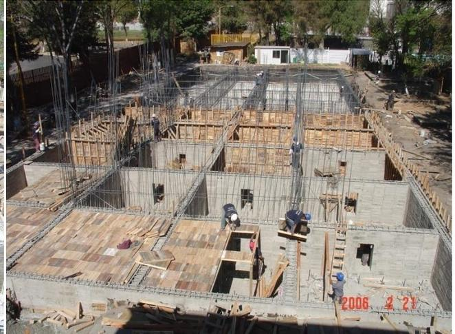
**Se colaron los muros de la cimentación compensada, y se empieza a cimbrar para la losa tapa**
