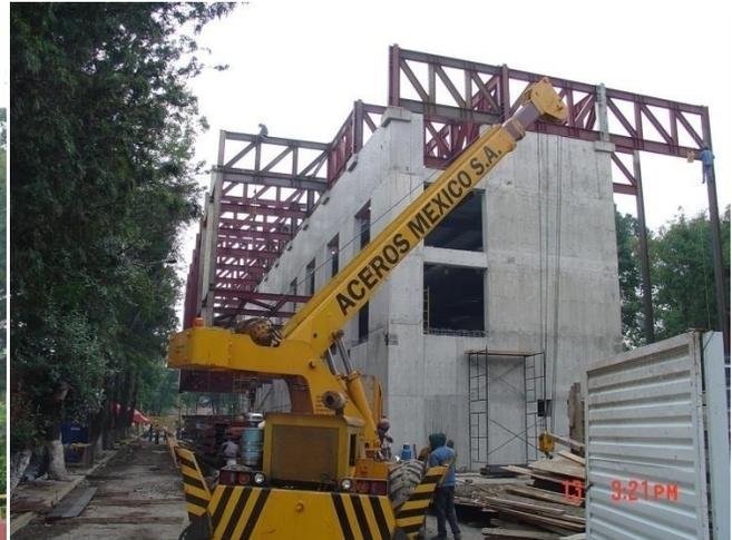
**Soldando tirantes para sostener entresijos de área de lectura, y terminando ultimo eje de colocar las vigas jois.**
