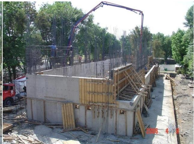
**Armado, cimbrado y colado de muros de rampa y muros del 2° nivel de Acervo**
