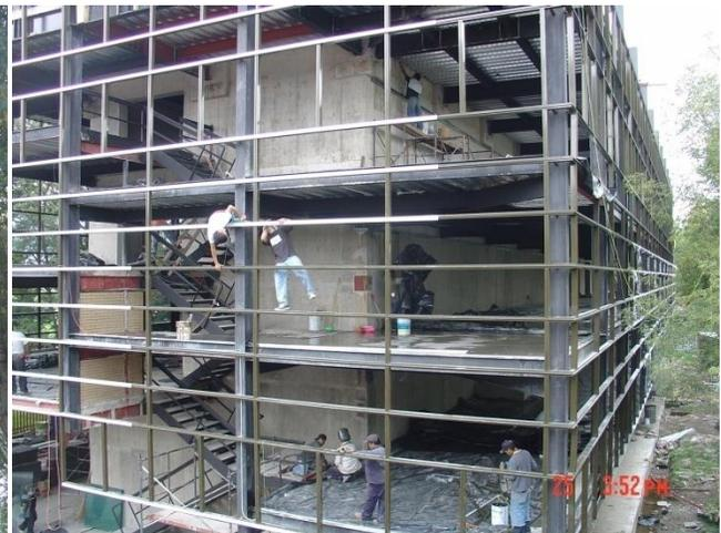
**Se está colando losa de acero y colocando la cancelería de aluminio para recibir cristales de 9 mm. en fachadas y con tabletas de ventilación en aluminio.**
