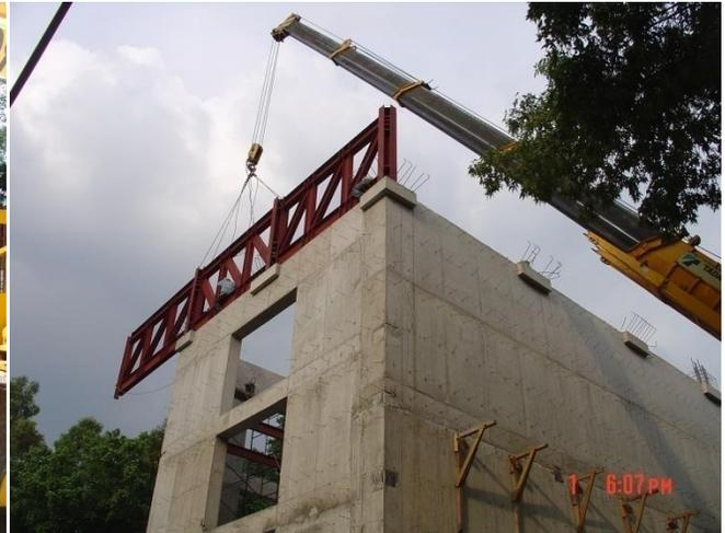
**Legaron las armaduras para sostener los entresijos de salas de lectura a base de tensores de vigas "I". Se utilizó una grúa de 120 toneladas. Por lo largo de brazo y hacer la maniobra con precaución.**
