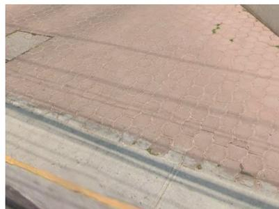
Imagen 12. Banqueta de adoquín rojo hexagonal.
