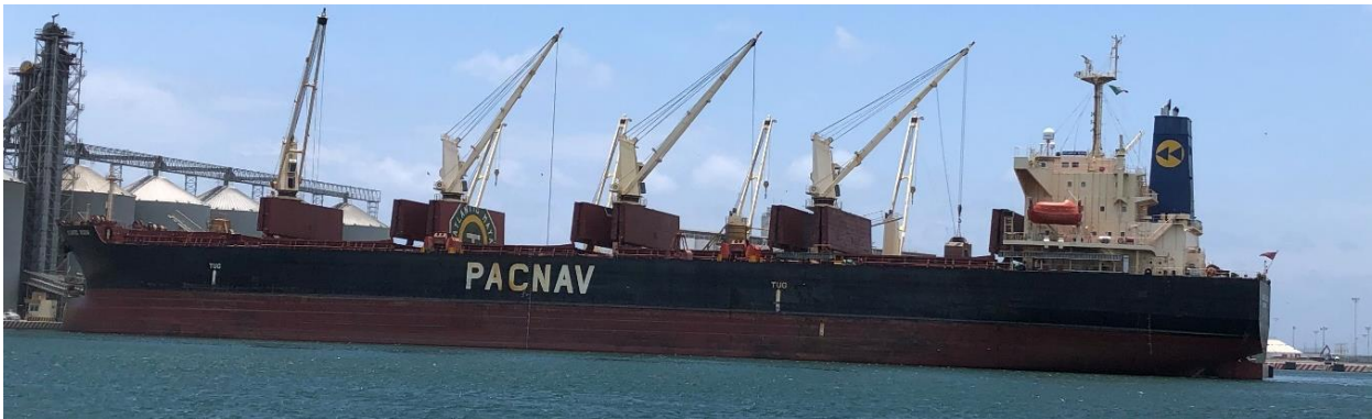
Figura 2. Buque granelero, atracado en el muelle 5 del puerto de Veracruz
