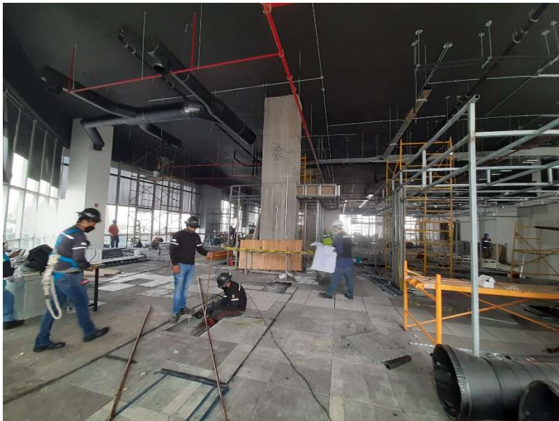
Ilustración 44 - Semana 4: Instalación de ductos de aire acondicionado, continúa tendido de canalizaciones en piso y muros, inicio de colocación de tablaroca a una cara. (2020)
