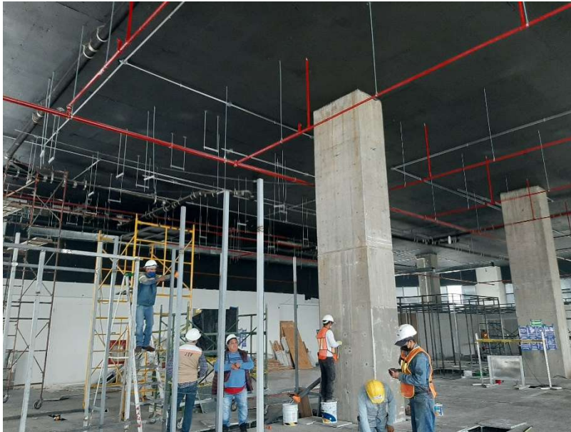
Ilustración 43 - Semana 3: Inicio de instalación de estructura metálica para soporte de muros, canalizaciones en losa. (2020)
