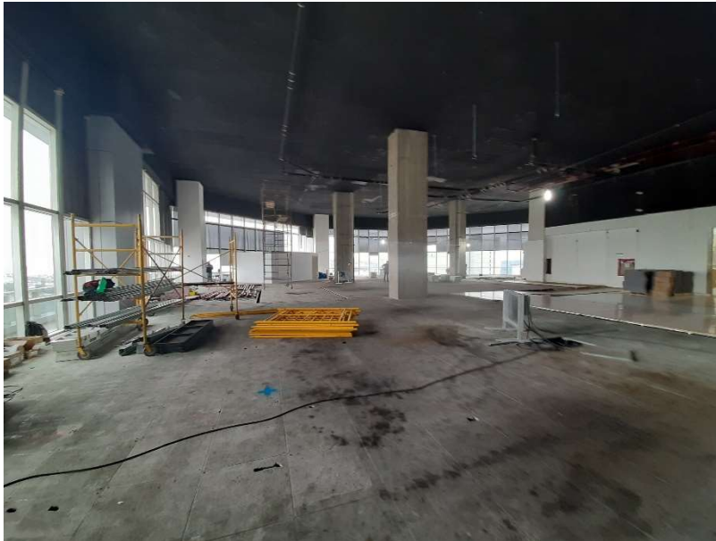
Ilustración 41 - Semana 1: Recepción del espacio e inicio de trabajos preliminares, instalación de tableros de obra, limpieza, construcción de oficina de obra, llegada de materiales. (2020)
