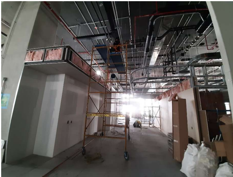
Ilustración 48 - Semana 8: Continúa cierre de muros y faldones. (2020)
