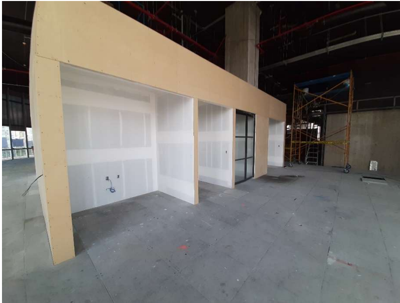
Ilustración 47 - Semana 7: Cierre de muros terminado, inicia pintura, canalizaciones finalizadas, inicio de cableados, inicio de fabricación de cancelerías. (2020)
