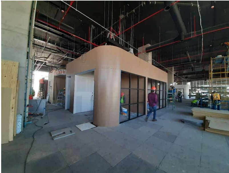
Ilustración 49 - Semana 9: Inicia instalación de cancelerías y forro de caras exteriores de muros con laminado. (2020)
