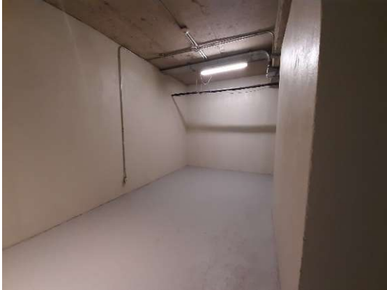
Ilustración 3 - Estado en el que se recibe bodega complementaria (2020)
