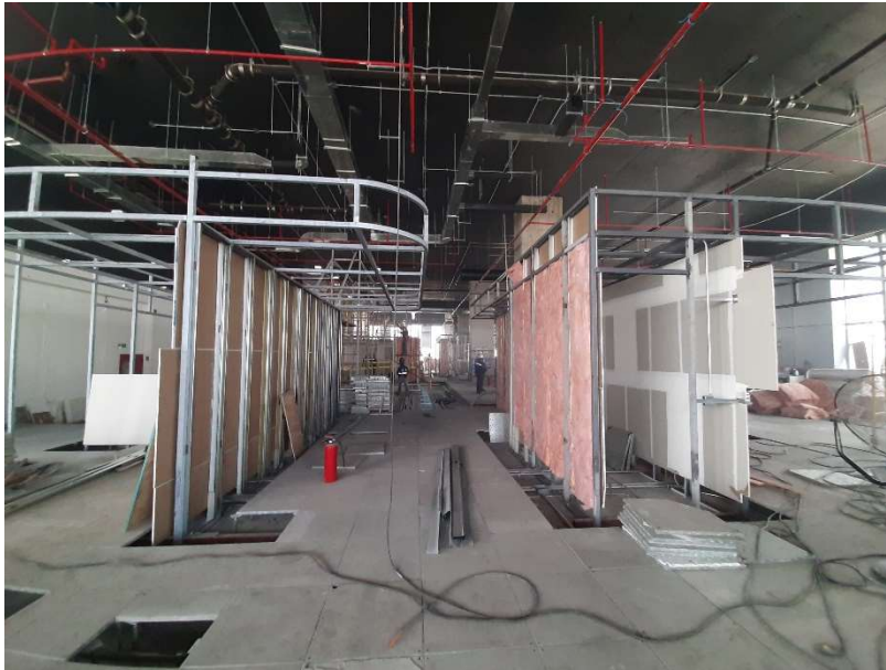
Ilustración 45 - Semana 5: Instalación de fibra en muros, inicio de canalizaciones en muros, continúan canalizaciones en piso y losa. (2020)
