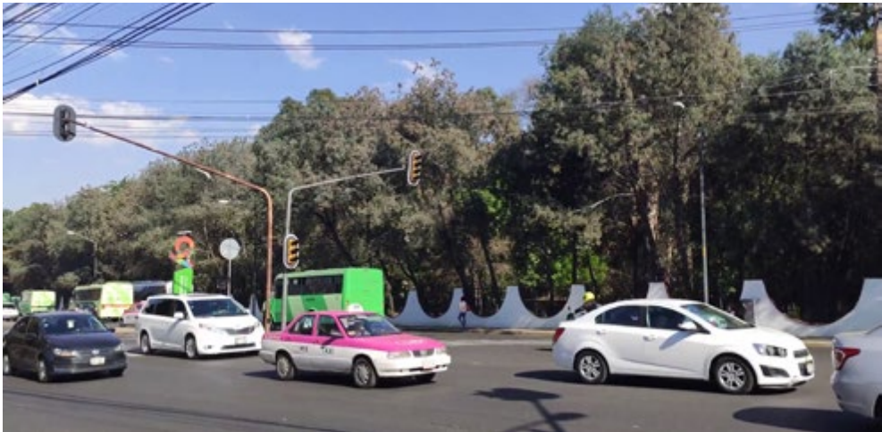
fig. 4.12 Muro perimetral de los Viveros de Coyoacán. Elaboración propia, 2020.
