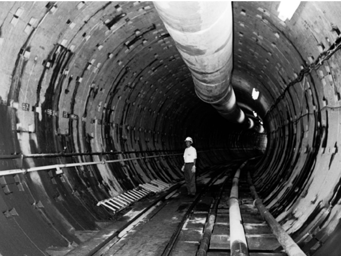
◀ fig. 2.19 Túnel del Drenaje Profundo. ICA. 1975.
