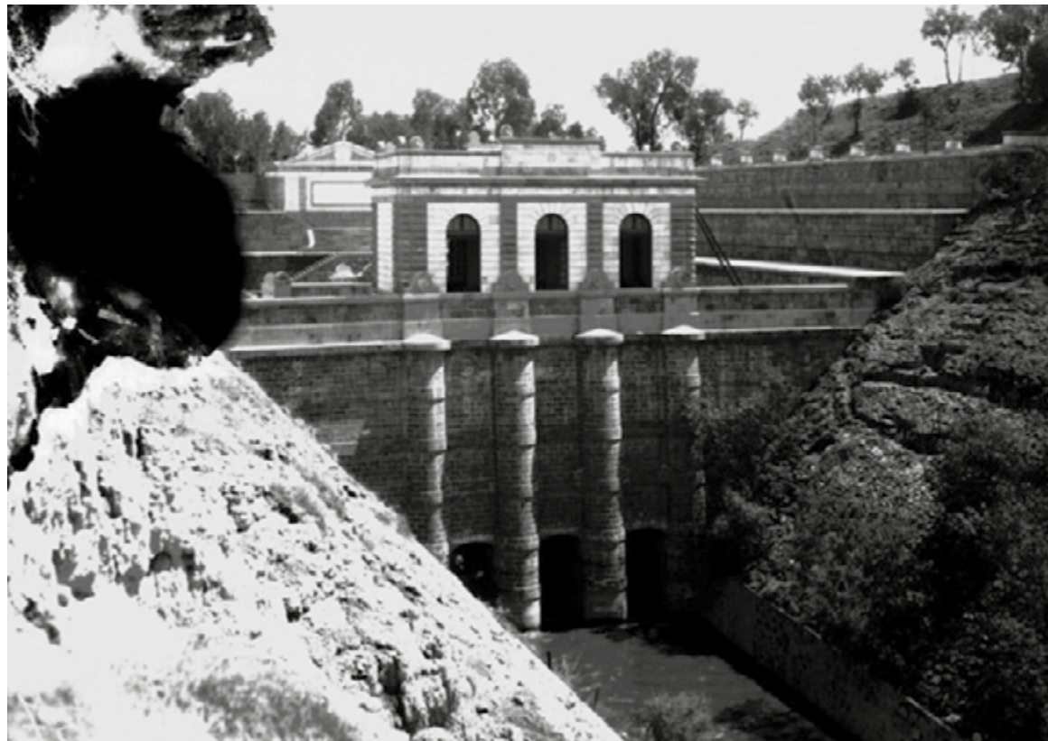
fig. 2.9 Compuerta del Gran Canal de Desagüe. ► Archivo Casasola, 1930.
