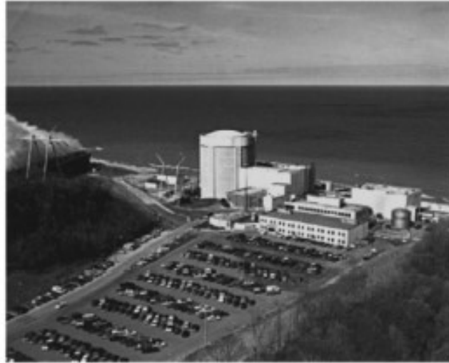
Fig 2.5 Ejemplo de rugosidad de terreno tipo D. Nota. Adaptado de “Minimum Design Loads for Buildings and other Structures” (p. 877) por American Society of Civil Engineers, 2021.
