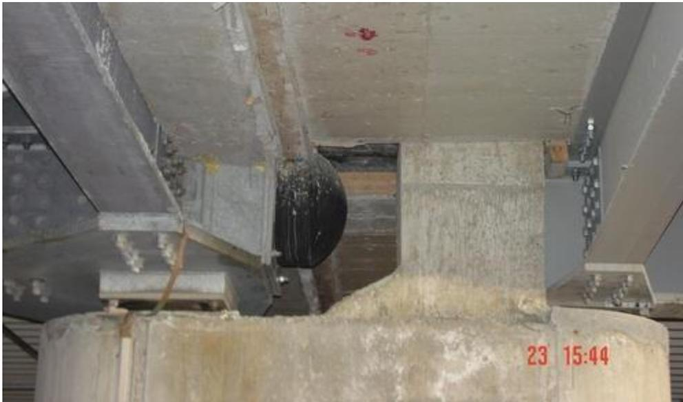
**Figura 5.1** Banda de goma de sección transversal circular instalada en un edificio aislado en Chipre, capaz de absorber posibles impactos entre sus elementos estructurales (Polycarpou *et al.*, 2013)
