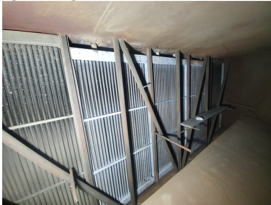
Figura 6.1: Fotografía de interior de intercambiador de calor - 1
