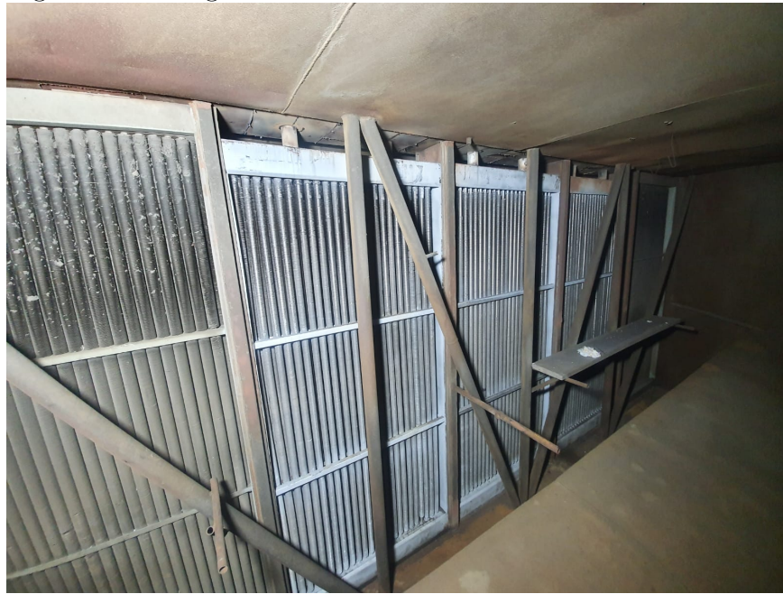
Figura 6.2: Fotografía de interior de intercambiador de calor - 2
