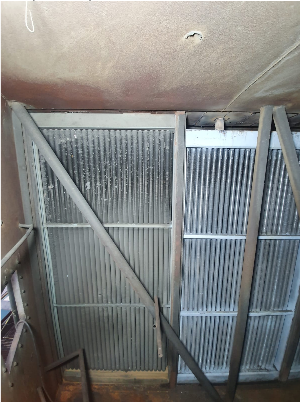
Figura 6.5: Fotografía de interior de intercambiador de calor - 5
