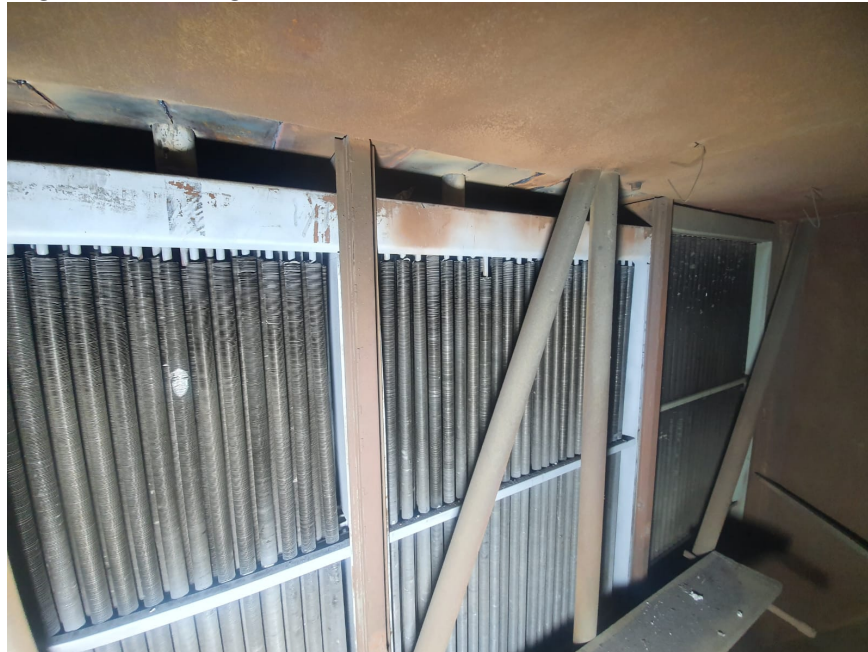
Figura 6.3: Fotografía de interior de intercambiador de calor - 3
