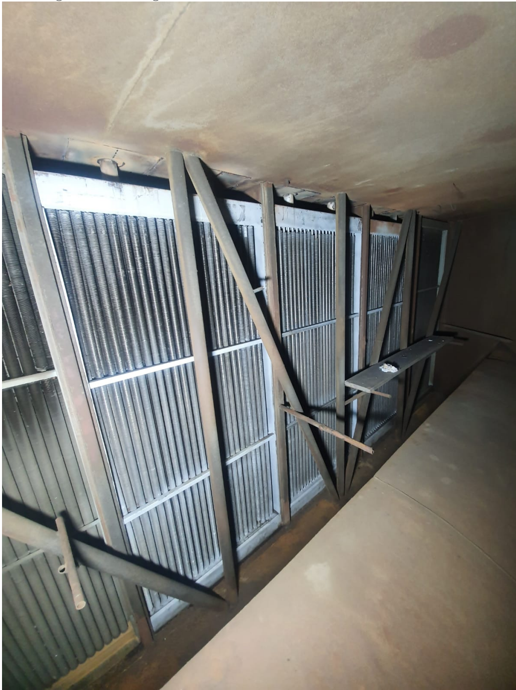
Figura 6.4: Fotografía de interior de intercambiador de calor - 4
