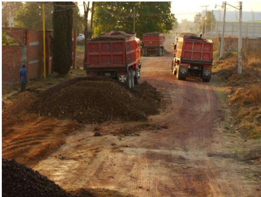
Suministro de material de sub-base.
