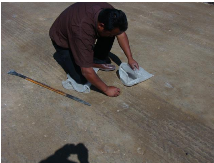
Determinación de la compactación en la estación 0+556 lado derecho
