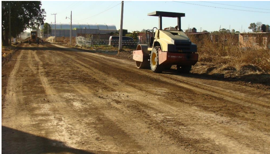
Tendido, afine y compactación en capa de base.
