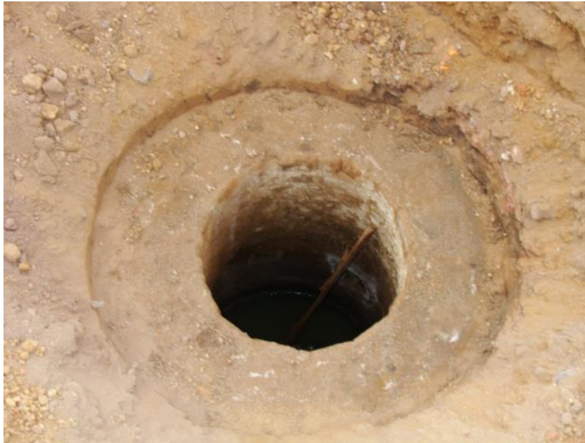
Renivelación de pozos de vista.
