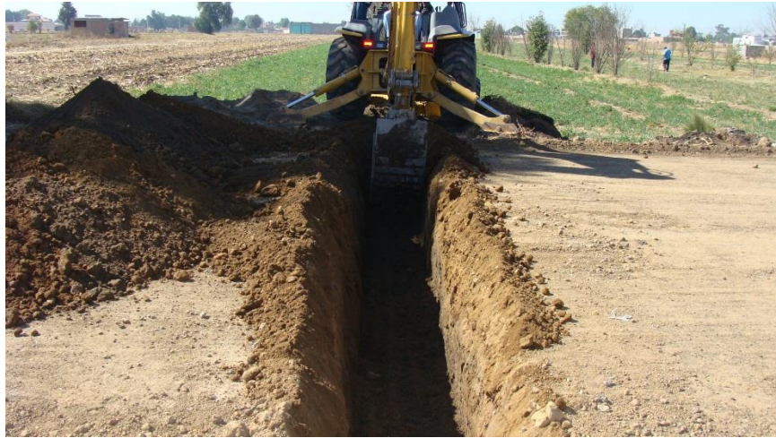
Excavación para bocas de tormenta.
