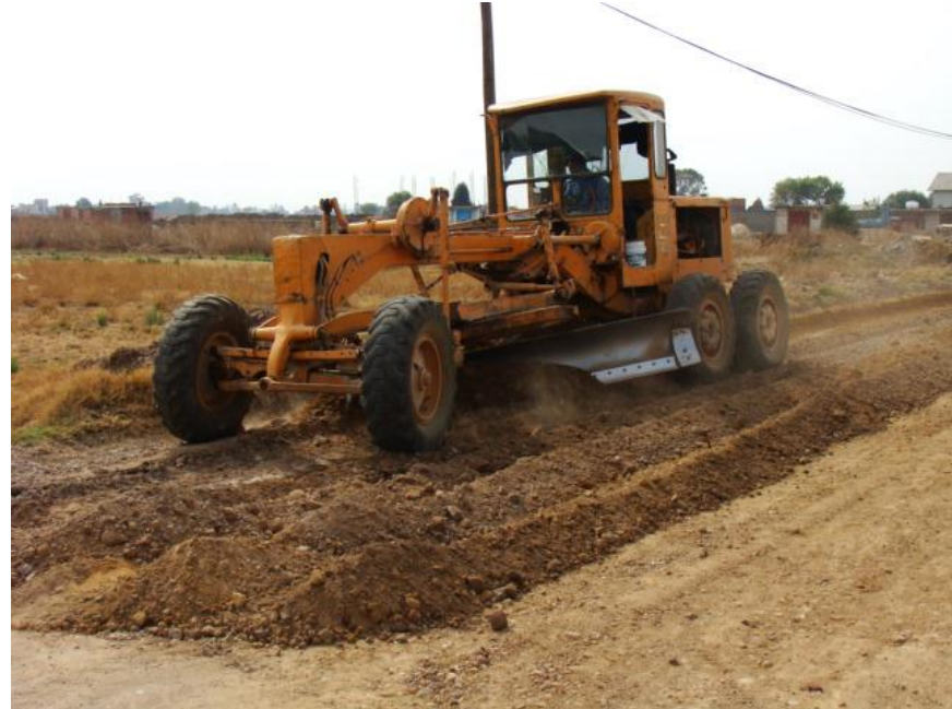
Escarificado del terreno natural
