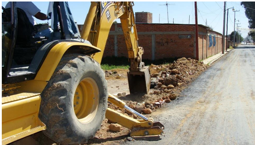
Excavación para bocas de tormenta.
