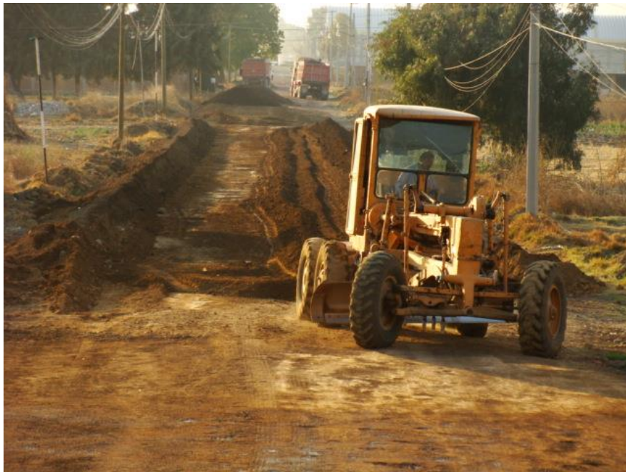
Escarificado del terreno natural constituido basicamente por brecha volcanica.
