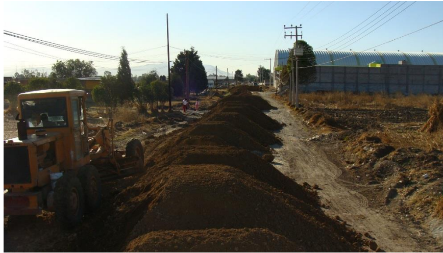
Suministro de material de base.
