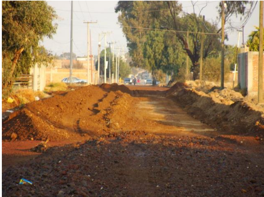
Material homogeneizado para la formación de la capa de sub-base.
