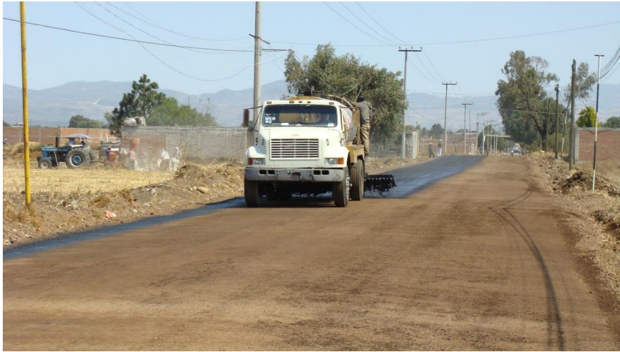
Riego de impregnación.
