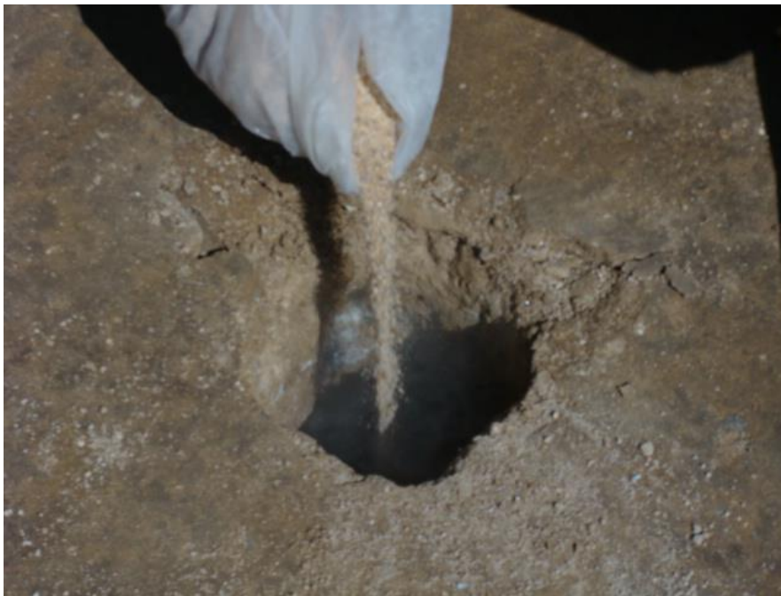
Determinación del grado de compactación km 0+320
