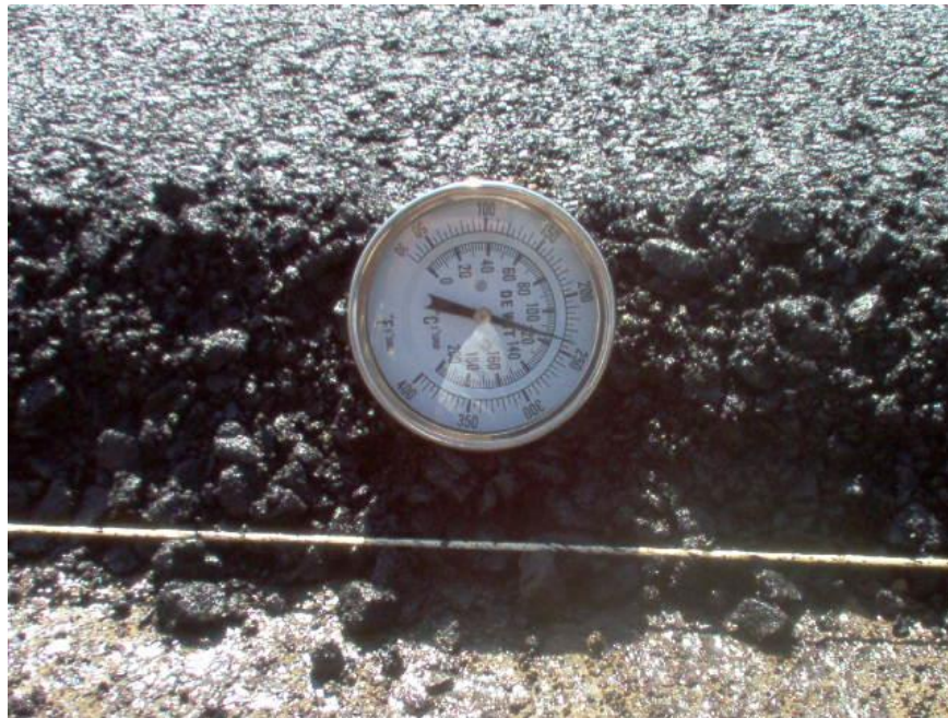
Temperatura de compactado de la carpeta asfaltica.
