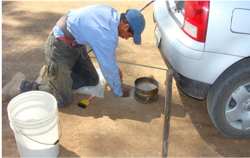
Determinación del grado de compactación en capa de sub-base.
