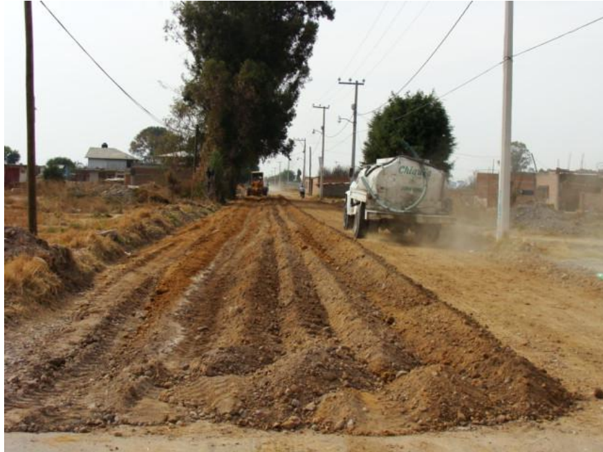
Escarificado del terreno natural
