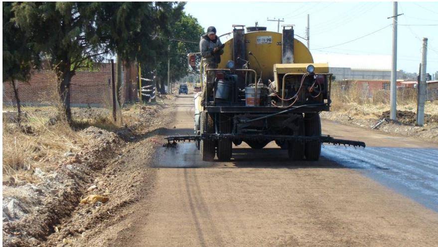
Riego de impregnación.
