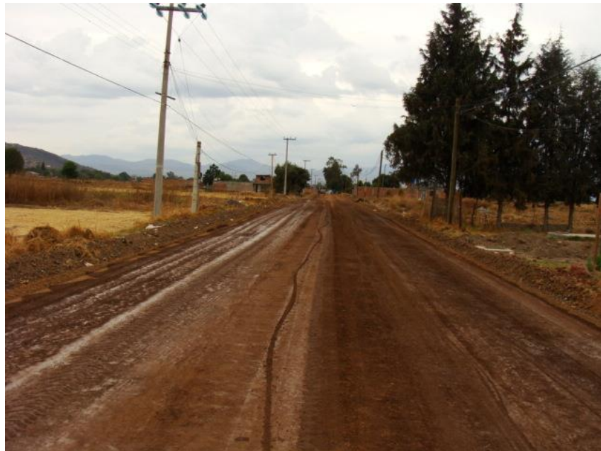
Material homogeneizado para la formación de la capa de sub-base.
