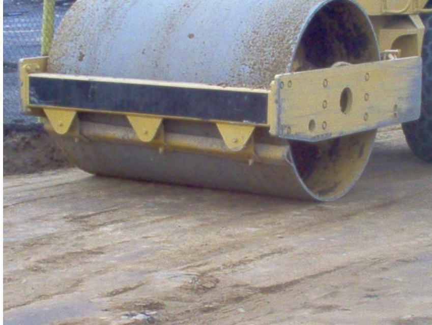
Compactación de la capa de sub-base
