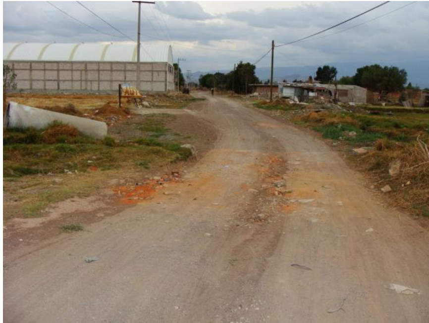
Camino al Ejido, antes de los trabajos de la pavimentación.
