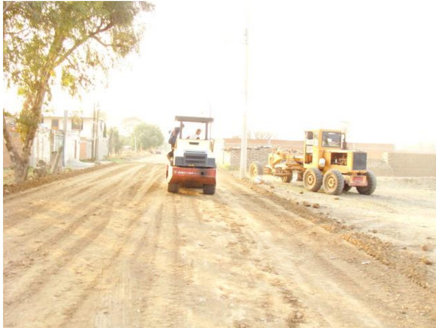
Compactado del terreno natural.
