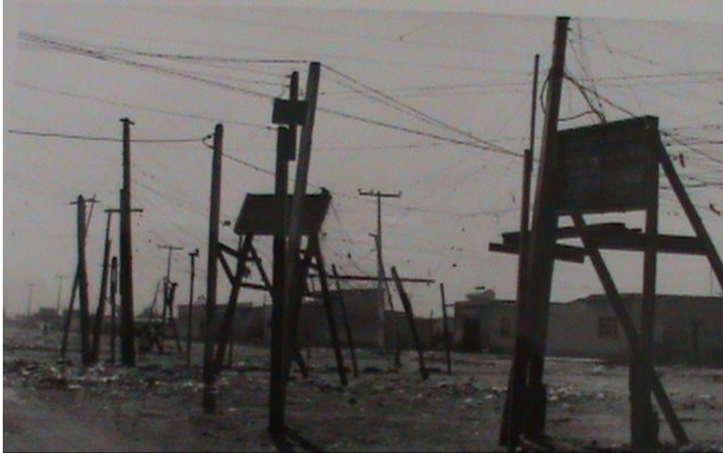
A falta de abastecimiento de luz eléctrica, los pobladores tenían que “colgarse” de los transformadores fuente, 1973. Foto: Acervo fotográfico del Centro de Información y Documentación de Nezahualcóyotl (CIDNE).
