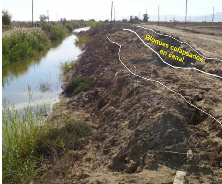
**Ilustración 2.15.** Bordes Colapsados a lo larga de varios canales
