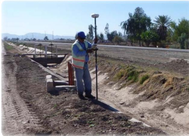
**Ilustración 2.3.** Levantamiento de geometría de la infraestructura
