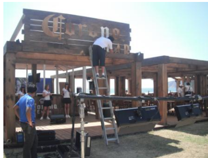
INSTALACIÓN SET DE TRANSMISIÓN / FEBRERO 2011
