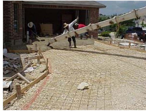
Armado de varilla para los pisos exteriores
