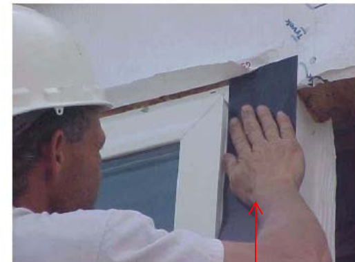
Colocacion del impermeabilizante en las esquinas
