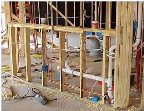
Colocación de cables de luz y drenaje
