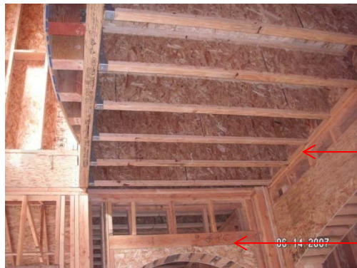
Colocacion de un header y los top plates
