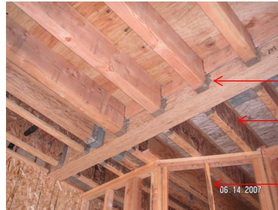
Colocacion de los TJI a un beam (trabe de carga)
