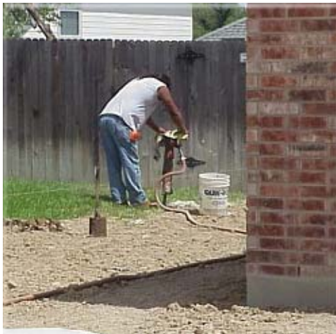
Perforación del terreno para plantar los arboles
