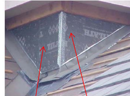
Techo colocación del papel de impermeabilización en las orillas de las paredes que dan al techo
