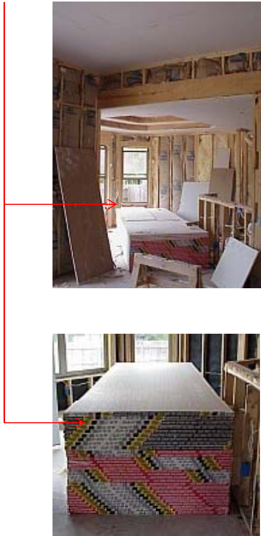
Almacenado del drywall dentro del proyecto
