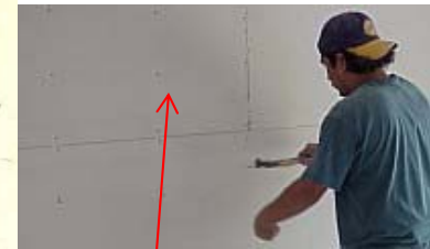
Colocación del los tornillos 1 ½ pulgada
