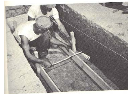
Trazo y cimbrado de los cimientos
