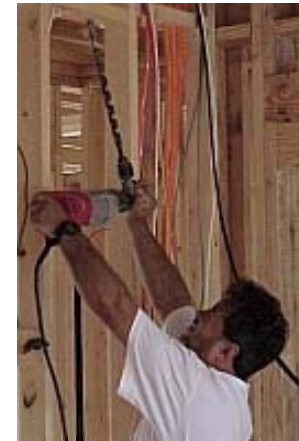
Perforación para las instalaciones eléctricas
