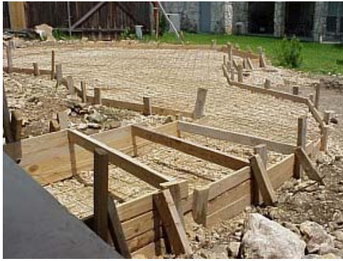
Preparado de la siembra de madera Para recibir el colado de concreto
