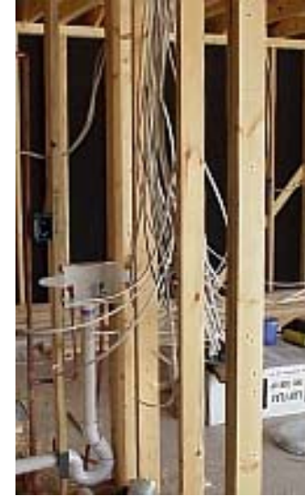
Alambres de luz y pipas de drenaje
