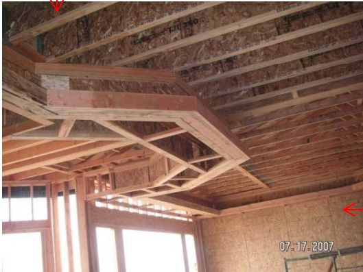
Colocacion de los TJI
