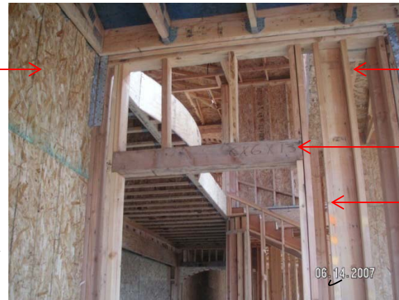
Colocacion de los bearing wall ( muro de carga)
