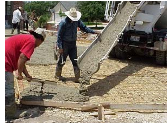
Vaciado del concreto para los piso exteriores
