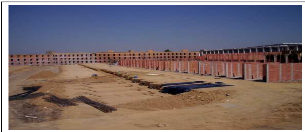
Figura N°56 Colocación de polietileno para recibir acero de cimentación
