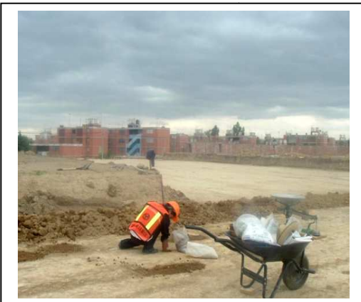
Fig. N°44 Pruebas de control de calidad de compactación
