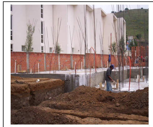
Fig. N°73 Cimentación terminada con firmes pulidos
