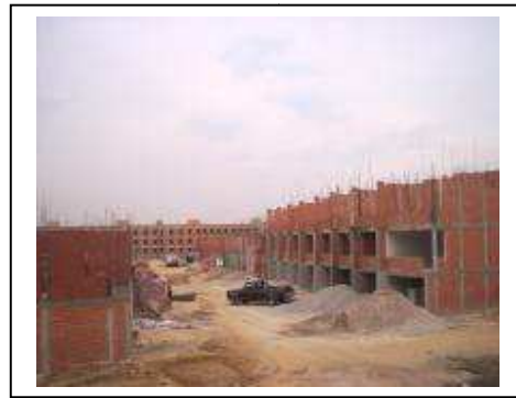
Fig. N°91 Muros y losas 1er y 2º nivel
