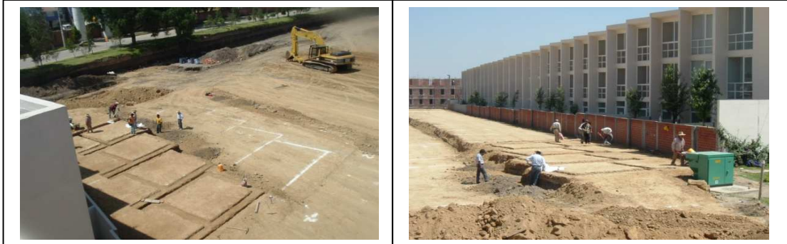
Figura N°55 Trazo y excavación para cimentación de modulo de 4 casas
