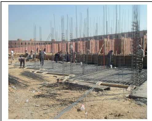
Fig. N°66 Colocación de mallas electro soldadas
