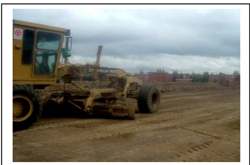
Fig. N°38 Afine de plataformas para dar niveles de proyecto
