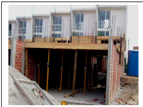
Fig. N°86 Cimbrado para losas de entresijos
