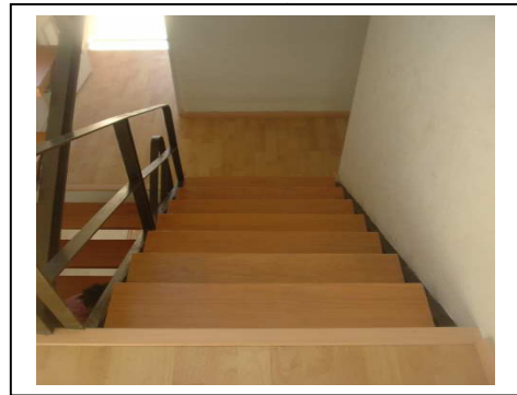
Figura N°122 Escaleras interiores recamaras
