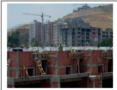
Fig. N°99 Bardas de cubo tinaco y salida azotea
