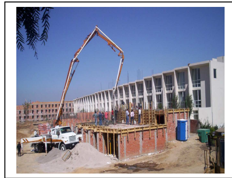
Fig. N°89 Colado de losas, traveses.
