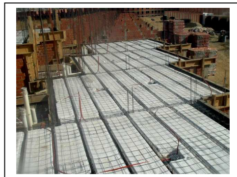
Fig.N°87 Vigueta y bovedilla e Inst. 1er nivel
