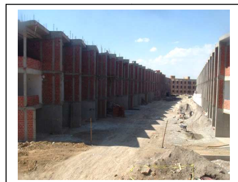
Fig. N°98 Muros y losas terminadas
