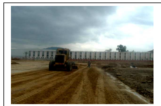
Fig. N°39 Afine de plataformas para dar niveles
