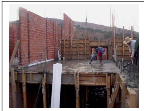
Fig. N°88 Colado de losas, traveses y muros de concreto.
