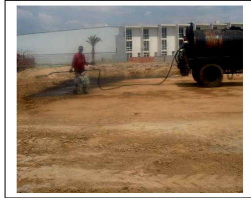
Fig. N° 47 Riego con emulsión asfáltica para protección de lluvia
