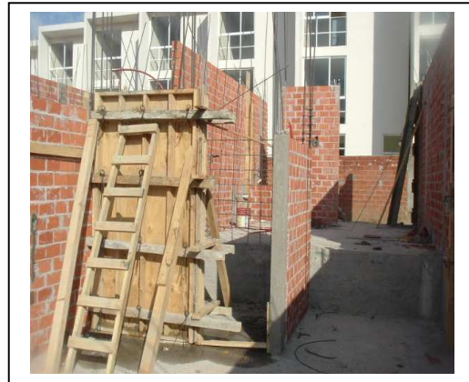
Fig. N°78 Muro de concreto MC1 y MC2
