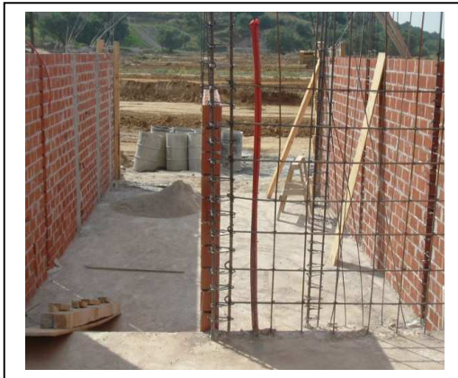
Fig. N°77 Muro de concreto MC1 y MC2
