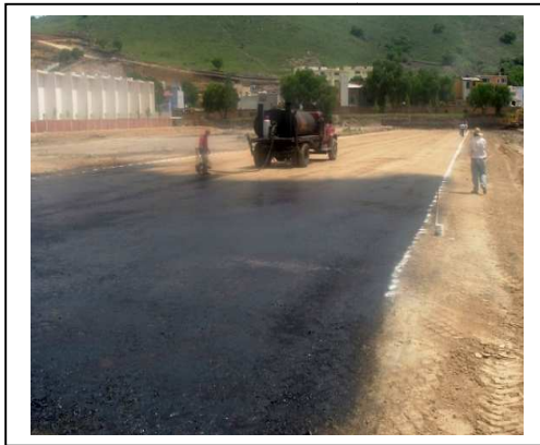
Fig. N° 48 Riego con emulsión asfáltica para protección
