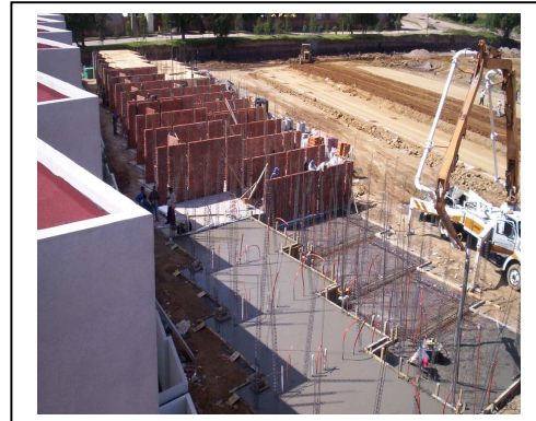
Fig. N°71 Colado de cimentación
