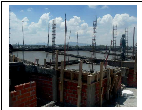
Fig. N°95 Colado de losas azoteas y baños
