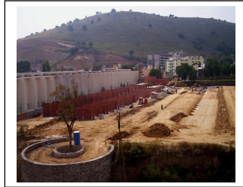
Fig.N°83 Muros y castillos PB
