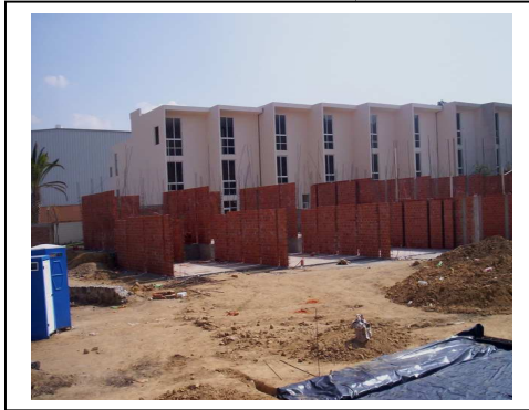
Fig.N°82 Muros y castillos PB
