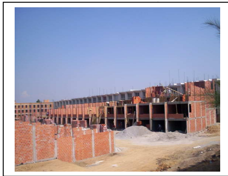
Fig. N°90 Muros y losas 1er y 2º nivel
