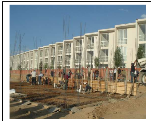
Fig. N°67 Colocación de mallas electro soldadas
