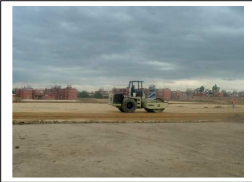
Fig. N°42 Cerrada de plataforma con vibrocompactador
