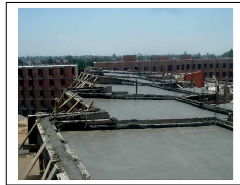
Fig. N°96 Colado de losas y trabes de pretil azoteas
