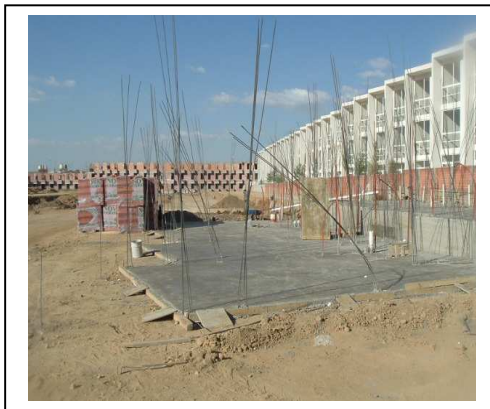
Fig. N°72 Cimentación terminada con firmes pulidos
