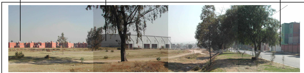
Figura N°15 Bodega existente en predio
