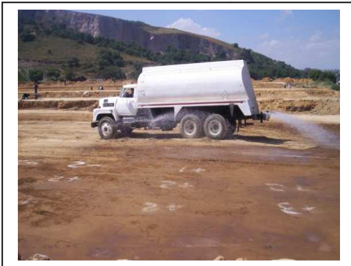
Fig. N°40 Riego de agua para lograr humedad óptima
