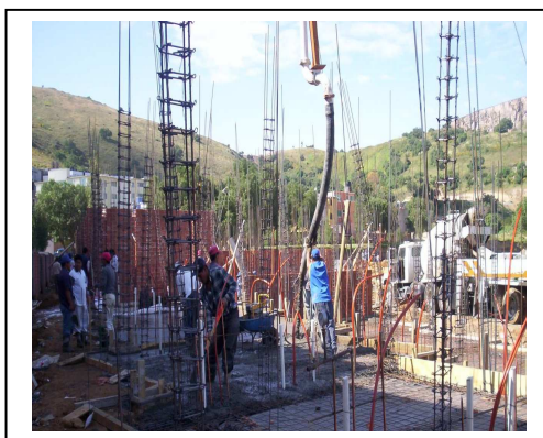
Figura N°68 Colado de cimentación
