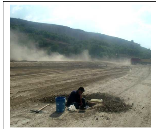
Fig. N°45 Pruebas de control de calidad de compactación
