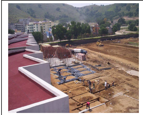
Fig. N°70 Colocación de traveses e instalaciones
