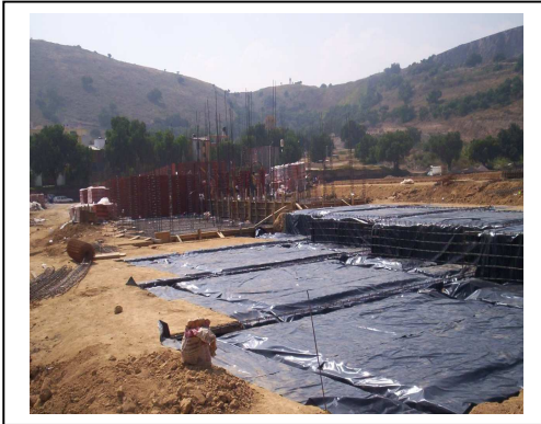
Fig. N°64 Colocación de armado de trabes y muro
