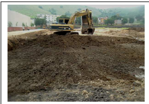
Fig. N°36 Excavación en caja de 80 cm para plataforma
