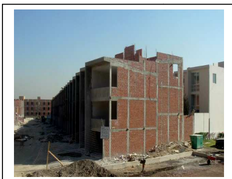
Fig. N°97 Muros y losas terminadas
