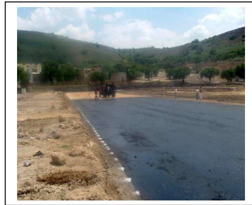
Fig. N° 49 Riego con emulsión asfáltica para protección
