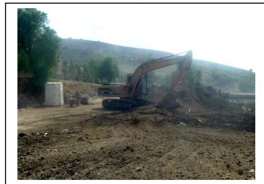
Fig. N°37 Excavación en caja de 80 cm para plataformas
