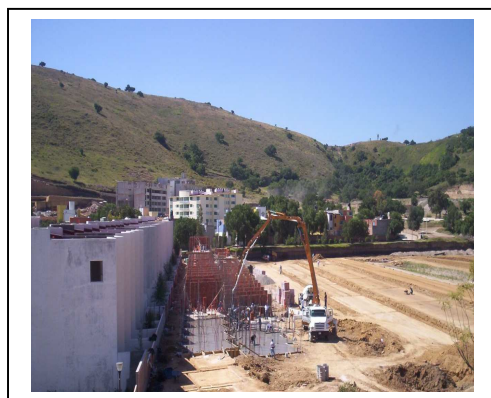
Figura N°69 Colado de cimentación
