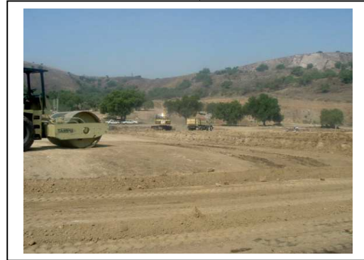
Fig. N°43 Cerrada de plataforma con vibrocompactador
