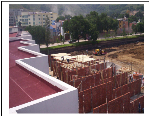
Fig. N°84 Muros PB y colado de castillos
