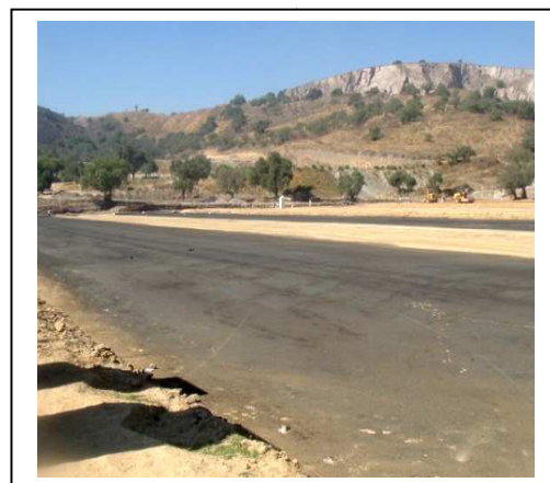
Fig. N° 51 Plataforma terminada e impermeabilizada
