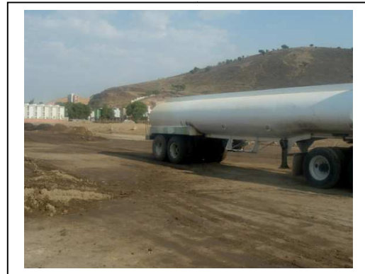
Fig. N°41 Riego de agua para lograr humedad óptima
