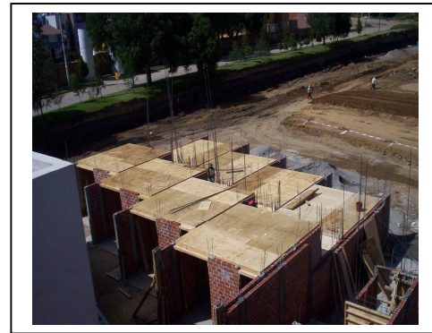
Fig. N°85 Cimbrado para losas de entresijos
