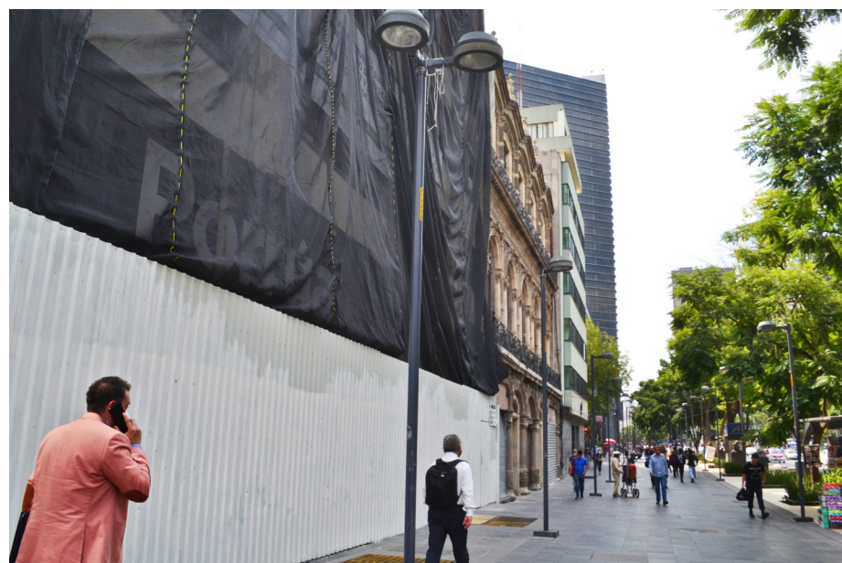
Vista sobre la calle Luis Moya
