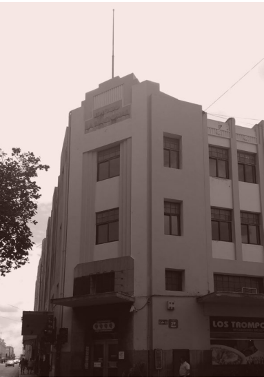
FOTO 19_EDIFICIO LA NACIONAL Elaboración propia, 2022
