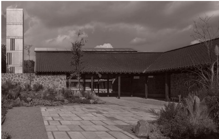
FOTO_03: ESCUELA DE ARTES MCT Sandra Pereznielo Ubicación: Canalejas, Estado de México. Año: 2019 Superficie construida: 7'740 m²
