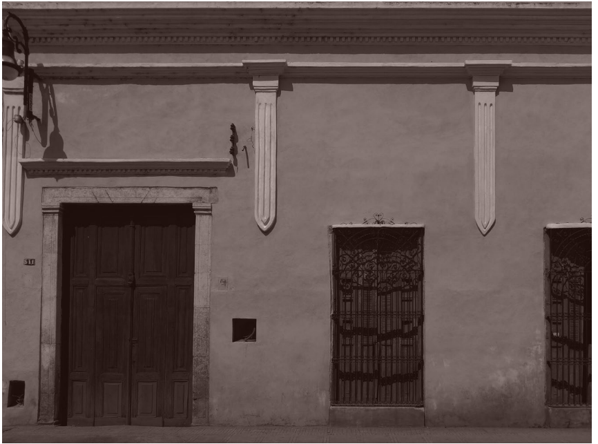
FOTO 14_ANEXO CALLE 55 NO. 511 Elaboración propia, 2022
