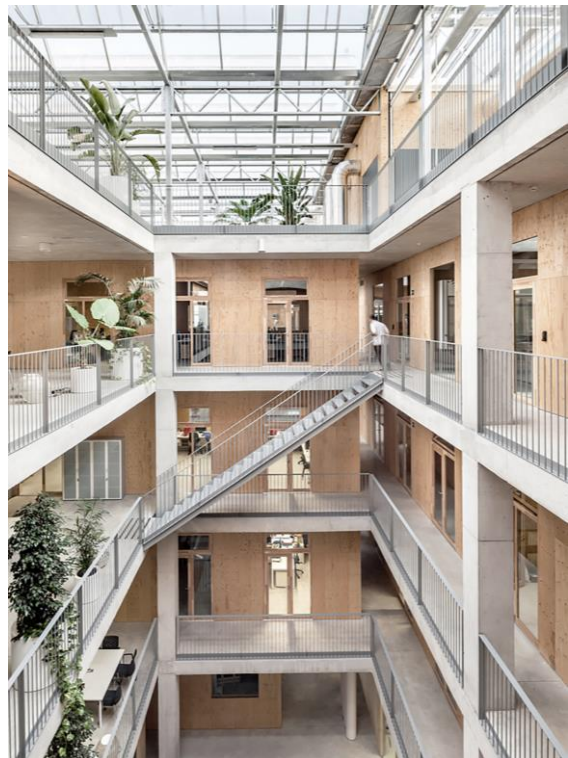
Imagen 26. Goula, A. (2015, 1 de junio). Centro de investigación ICTA – ICP. •UAB / H Arquitectes + DATAAE. [Fotografía].
