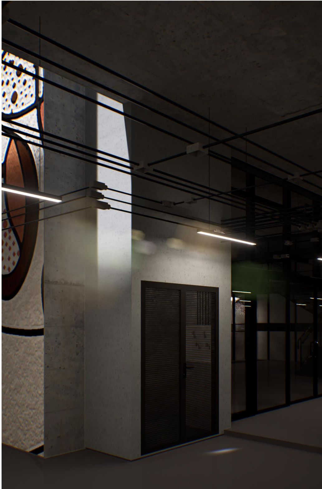
Imagen 38. Botello, D. Medina, M. Salvador, E. (2023, enero). Perspectiva iluminación sótano. [Visualización Digital]. Elaboración propia conforme a partida de instalación eléctrica y diseño de iluminación.
