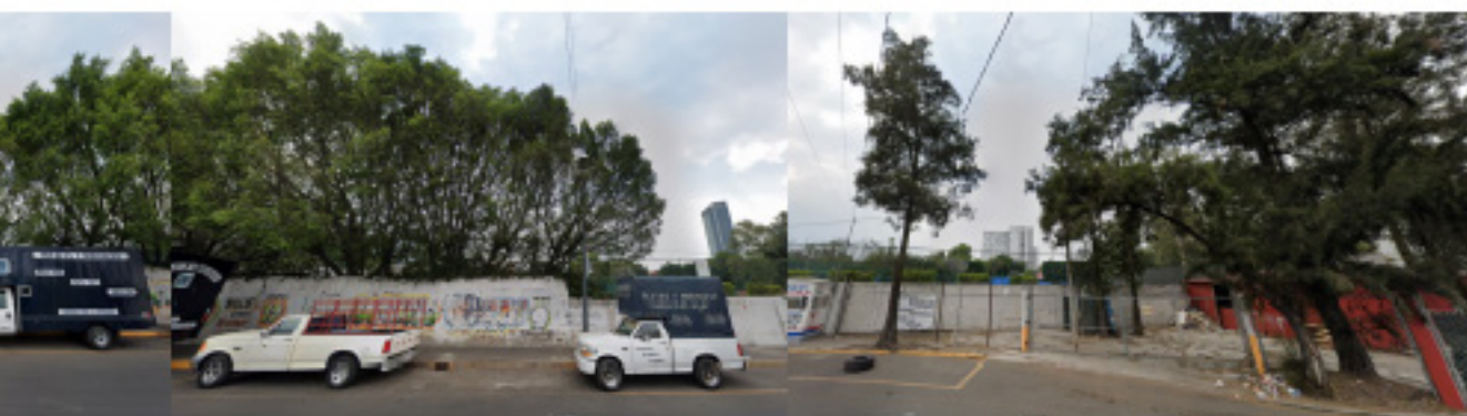
LARGUILLO 3. IMÁGENES TOMADAS DE GOOGLE MAPS
