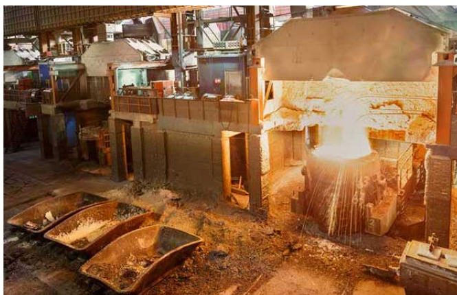
Fig. 14. Fotografía de una industria pirometalúrgica [62].
