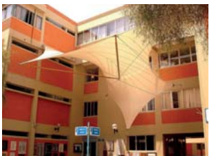
114 Cubierta en Facultad de Arquitectura de Perú, Arq. Aurora P Vildoso. Se sujeta de la estructura del edificio y descarga parte de las aguas pluviales en un jardín
