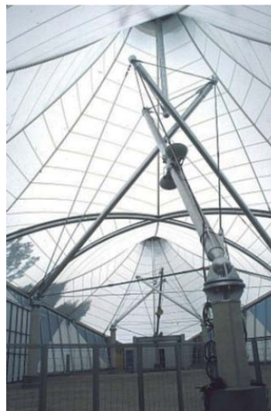
25 White Rhino, nombre por su apariencia exterior con 2 conoides. Se ve cada poste flotante con su respectivo sistema tensegrítico simplex.
