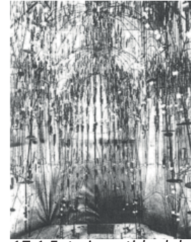
17.1 Foto invertida del modelo para la iglesia Güell tras ser colgados los sacos de arena
