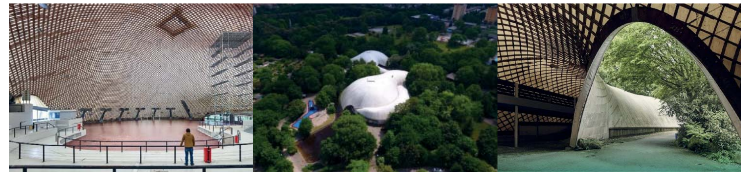
33 Nave multiusos en Mannheim, estado actual tras reciente remodelación; 1- Vista interior, zona mas larga y alta 2- Vista de pájaro 3- Acceso con arco catenario.
