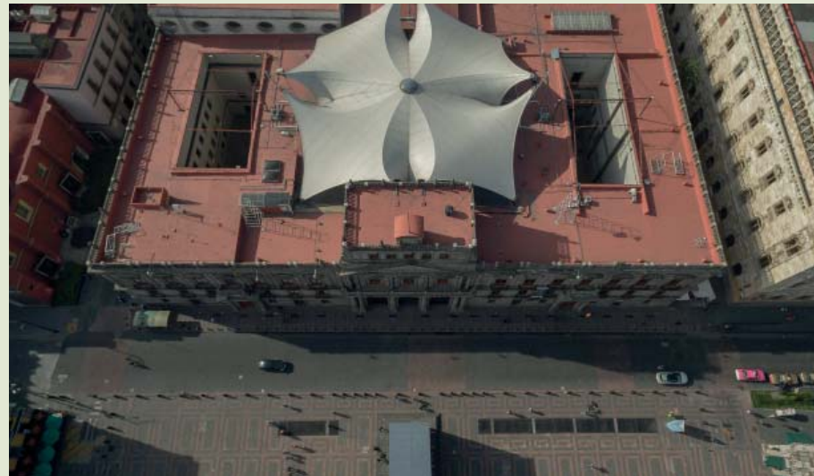
89 Vista aérea de cubierta.
