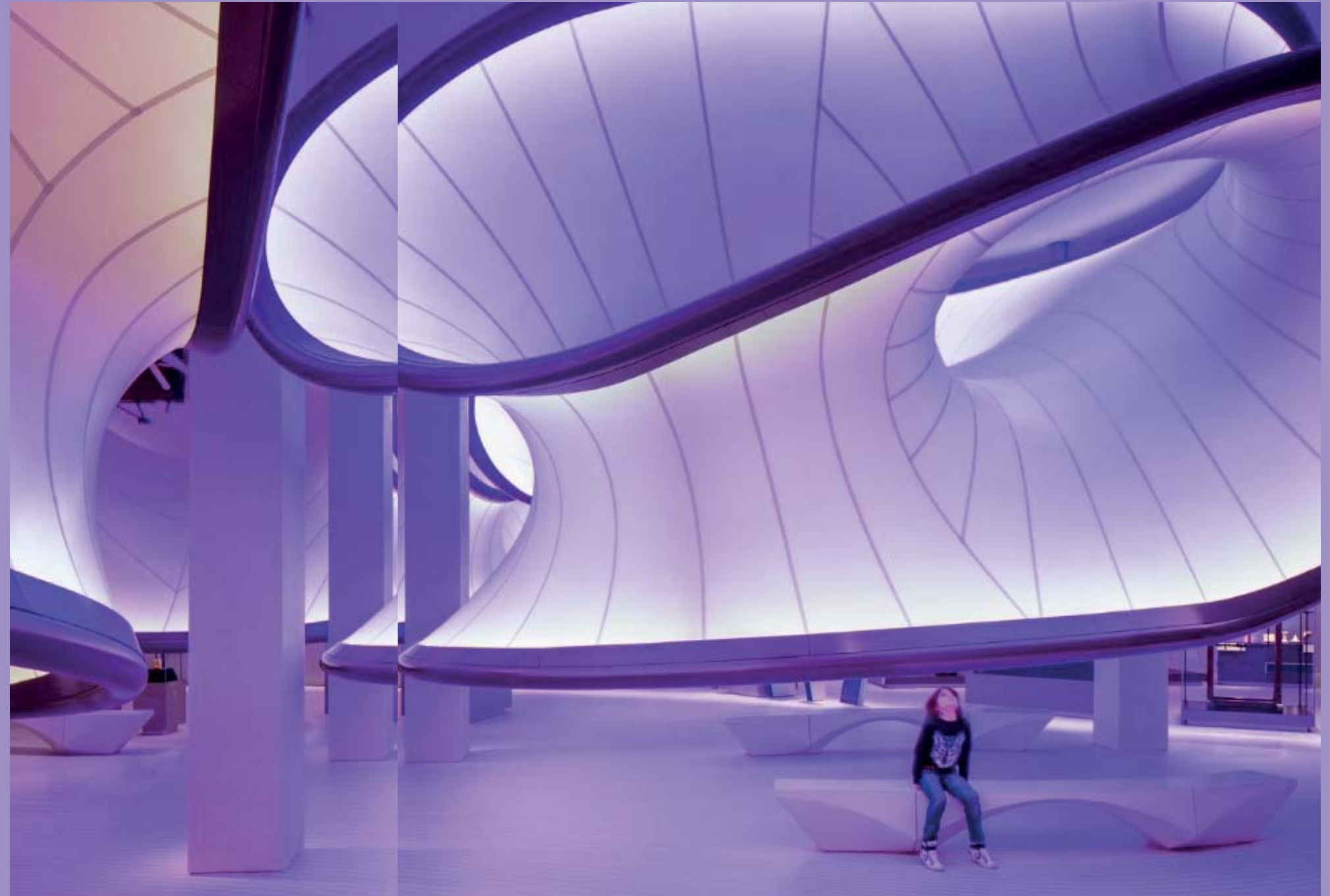
42 Estructuras Paramétricas a tracción. Zaha Hadid Architects (ZHA). Tela tensada en estructura de acero en bucle, abstracción de patrones de flujo de aire generados por un avión, elaborados para la restauración del piso de matemáticas en Winton Gallery Londres.
