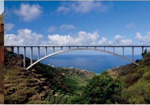
7 Puente con Arco Parabólico. Puente de los Tilos, Isla de la Palma España.
