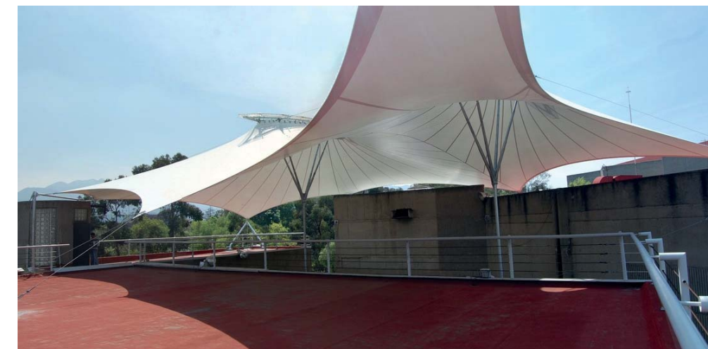
75 Vista desde la azotea, la propuesta no coloca elementos estructurales en el patio.
