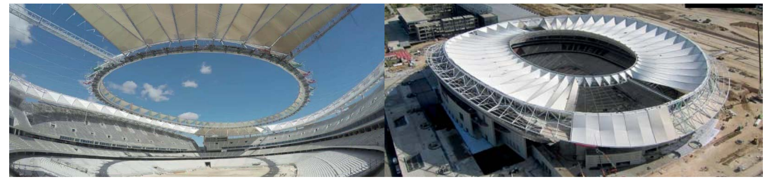
26 Estadio Wanda Metropolitano. Cubierta ligera a base de membrana, anillo de acero a compresión sobre graderías y cables, y anillo interior a tracción.
