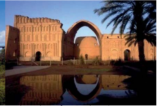
8 Palacio de Ctesifonte en la antigua Persia, siglo III. Arco Catenario, sigue en pie pesar de las ruinas a sus costados.
