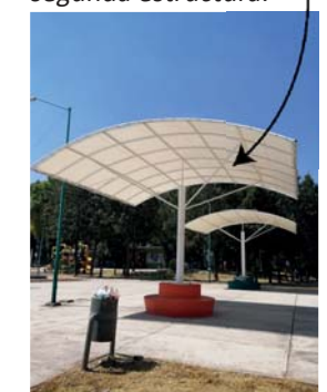
47 Cubierta velaria con forma de bóveda cilíndrica
