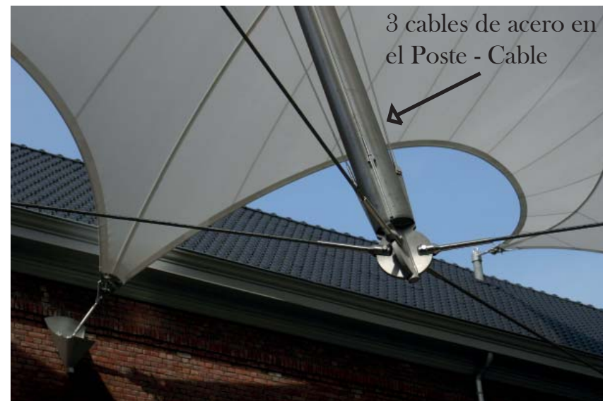
124 Detalle poste flotante y poste - cable
