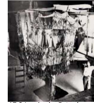
17.3 Izquierda: Foto de modelo iglesia de la colonia Güell revestido con papel, escala dimensiones 1:10 y escala pesos 1:10,000. Derecha: Pintura aguada sobre fotografía para estudiar el exterior.
