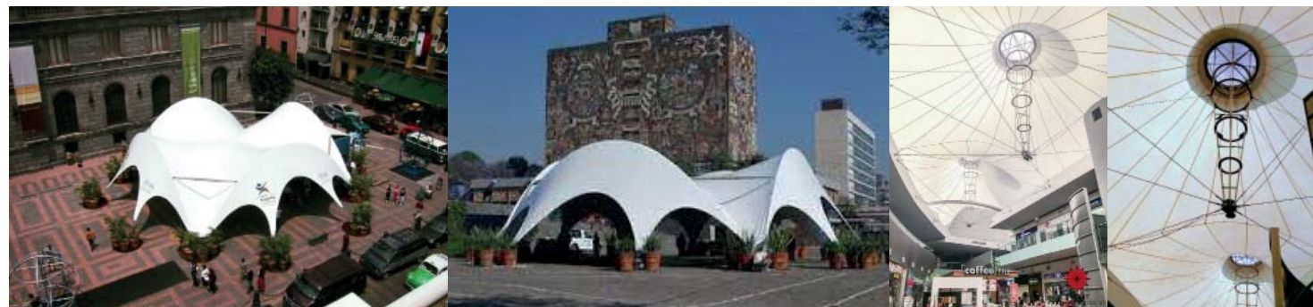
43 Modunam 1; Tensoestructura desmontable y modular, ha sido usada en múltiples ocasiones y toma alrededor de 5 horas construirla.
