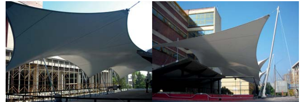
64 Perspectiva desde azotea edificio adjunto. Se observa el apoyo de algunos postes o cables sobre una techumbre existente
