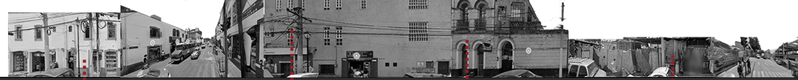
Figura 22: levantamiento de campo, larguillo. Fuente: Elaboración propia
