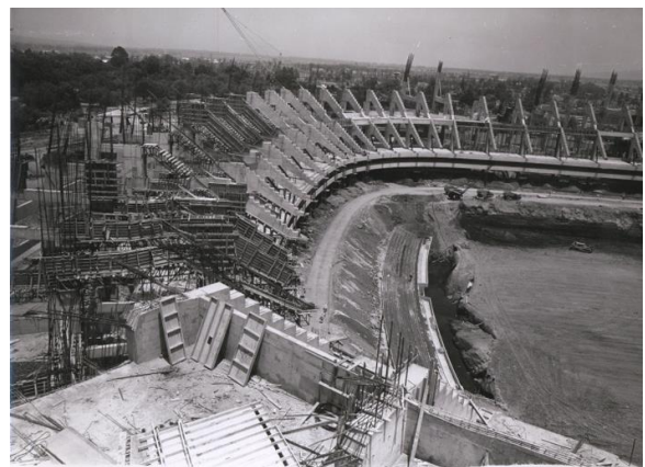
Figura 11. Construcción del estadio azteca
