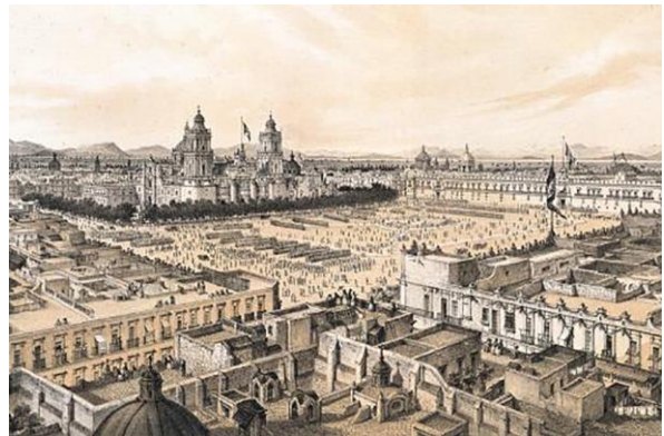
Figura 10. Vista a la plaza de la constitución
