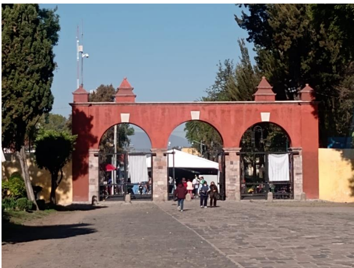
2022 Reconstrucción de fachada
