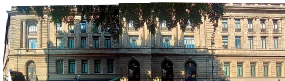
Figura 5. Edificio calle Donceles, CDMX
