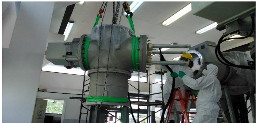
*Figura 3.14 Separación de los módulos con extremo cuidado.*
