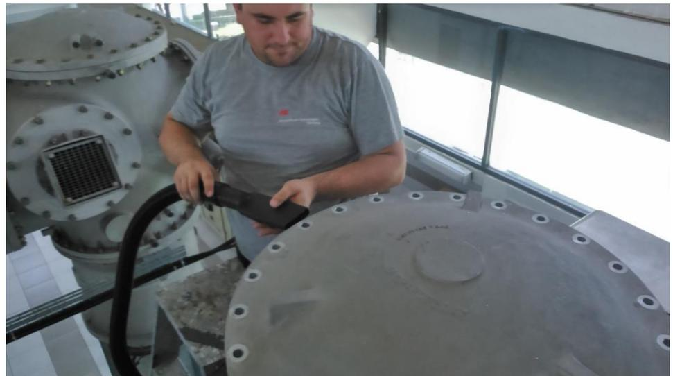
*Figura 3.11 Retiro de impurezas para mantener los módulos limpios*
