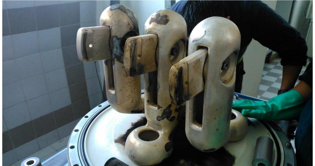
*Figura 3.17 cuchillas combinada (desconectador/puesta a tierra) dañada vista frontal.*
