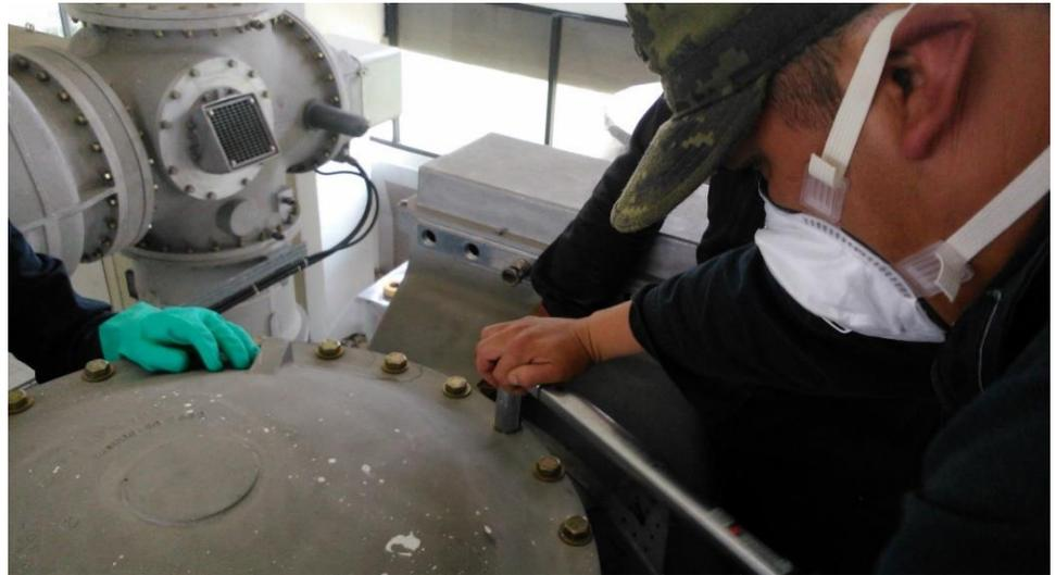
*Figura 3.10 Retiro de las tapas de los módulos para su revisión.*
