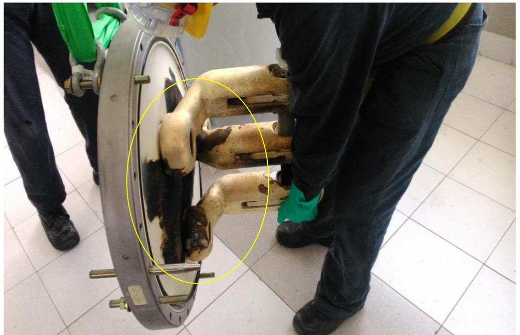
*Figura 3.16 cuchillas combinada (desconectador/puesta a tierra) dañada.*
