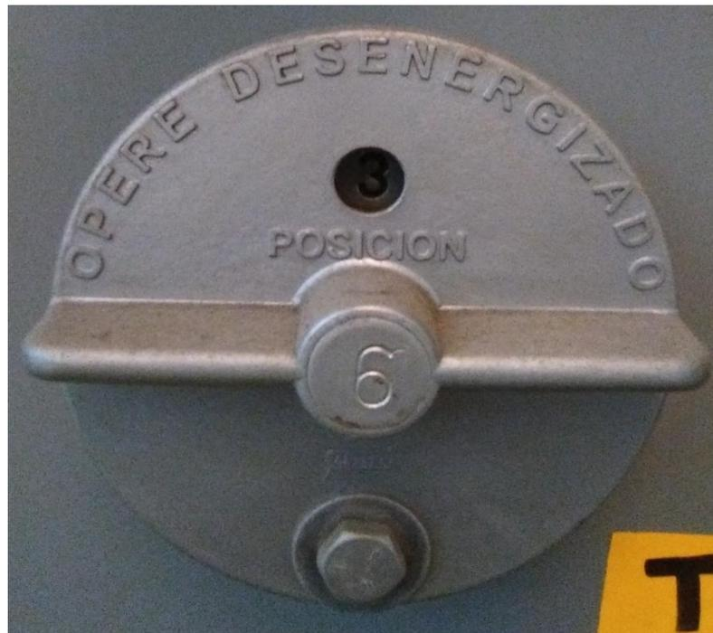
Figura 4.1 Tap (selector de posición de ajuste del transformador)
