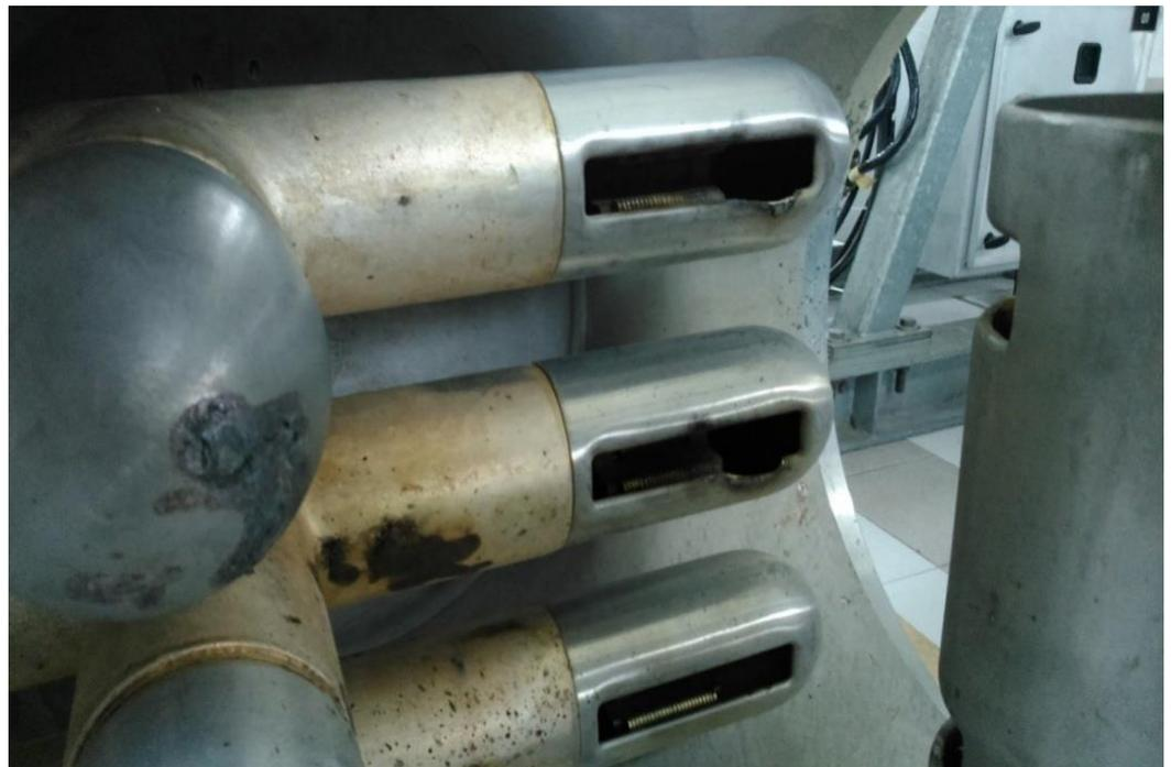
*Figura 3.18 Alojamiento de cuchillas combinada (desconectador/puesta a tierra) dañada.*
