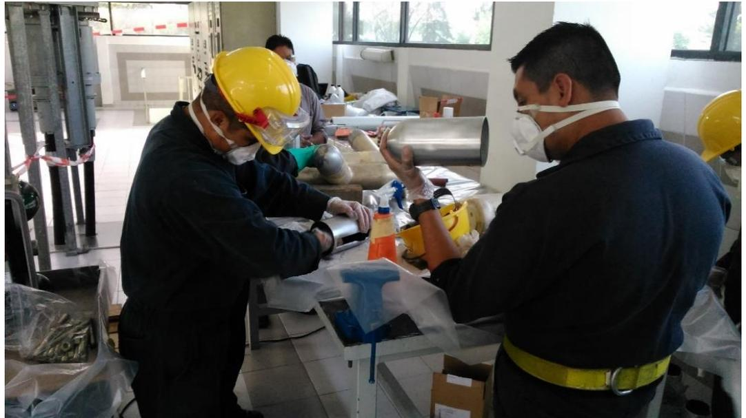
*Figura 3.19 Se limpió los componentes dañados para su reaprovechamiento*
