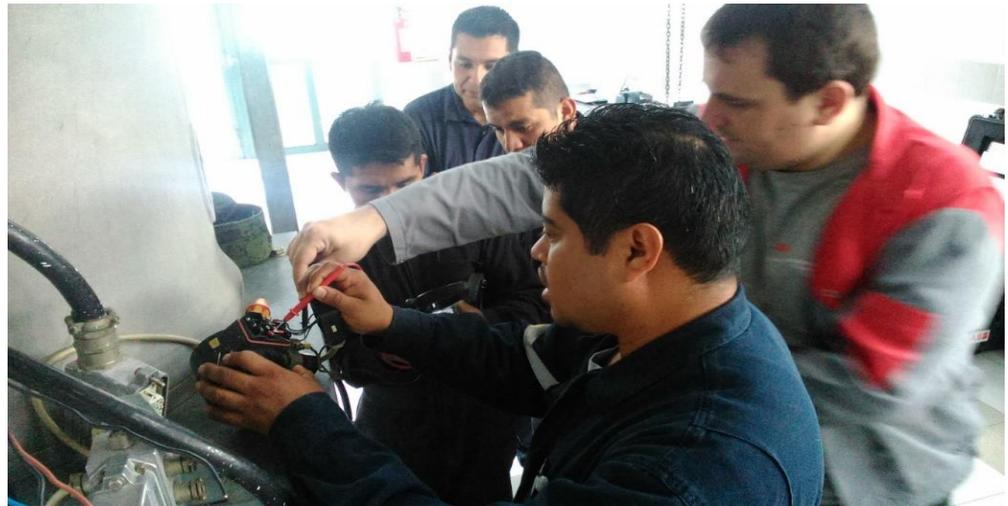
*Figura 3.7 Revisión de manómetros de gas SF6.*
