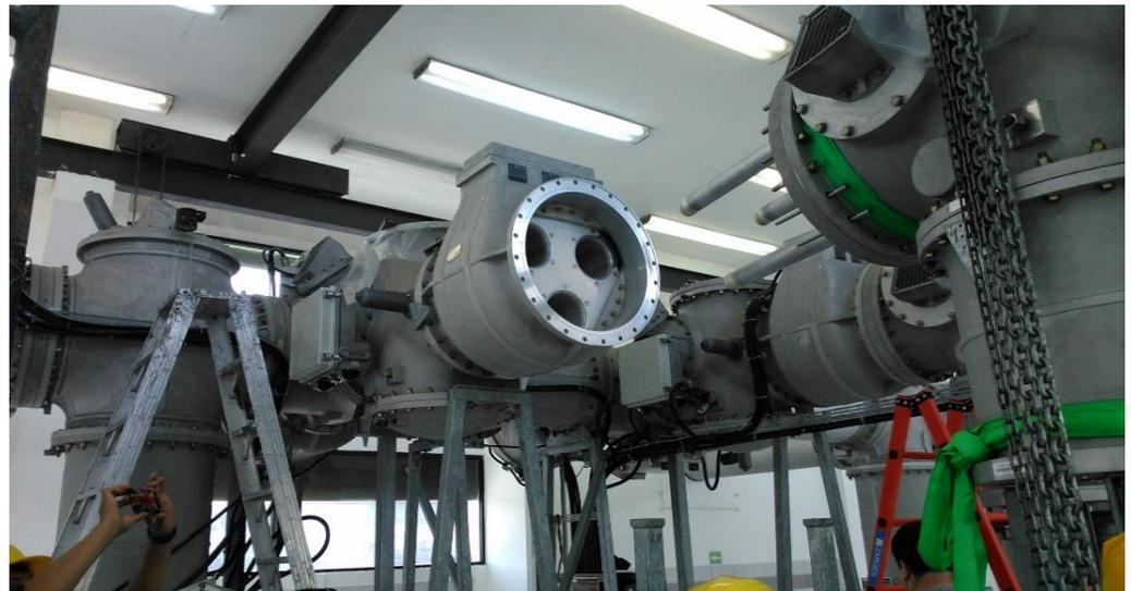
*Figura 3.13 Separación de los módulos*
