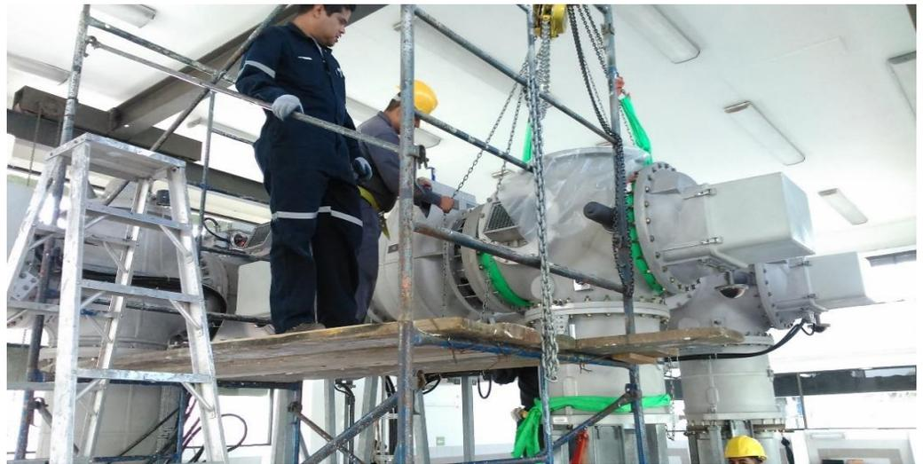
*Figura 3.12 Retiro de módulos por medio de eslingas y polipastos*
