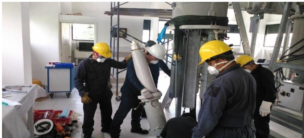
*Figura 3.9 Retiro de acometida IDNA 2 en 85 Kv para poder retirar y trabajar con los módulos de la bahía.*
