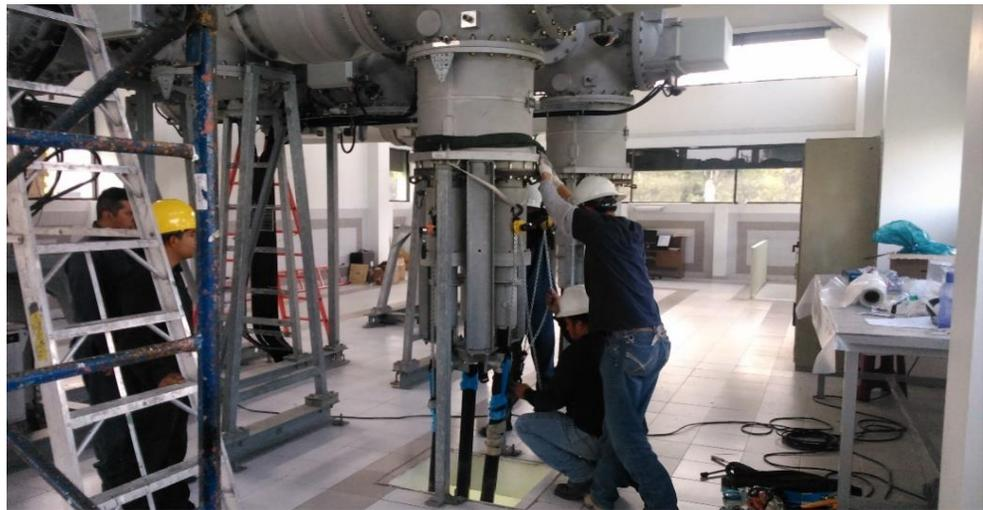
*Figura 3.8 desensamble de alimentadores de la acometida*
