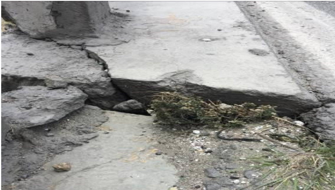
Fig. Detalle de escalón en zona de banqueta día 29 de julio de 2017.
