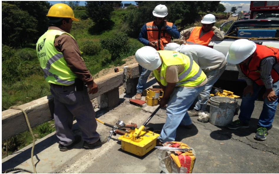
Fig. Registro de presión ejercida al gato para el izaje de la estructura.
