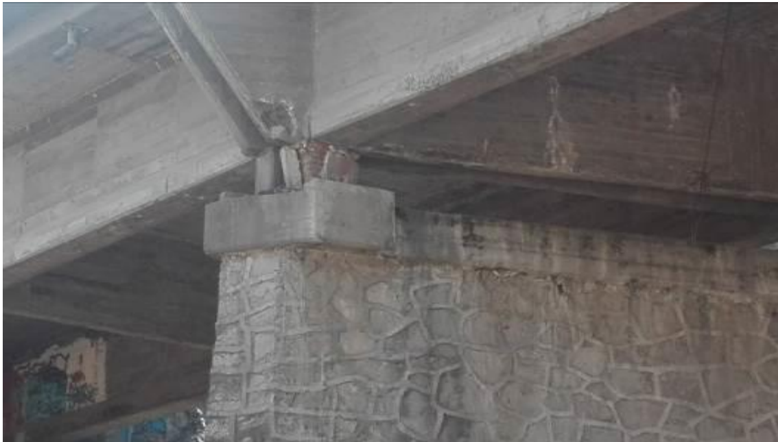
Fig. Detalle del apoyo del tramo central sobre pila 3 lado aguas arriba en enero de 2017.
