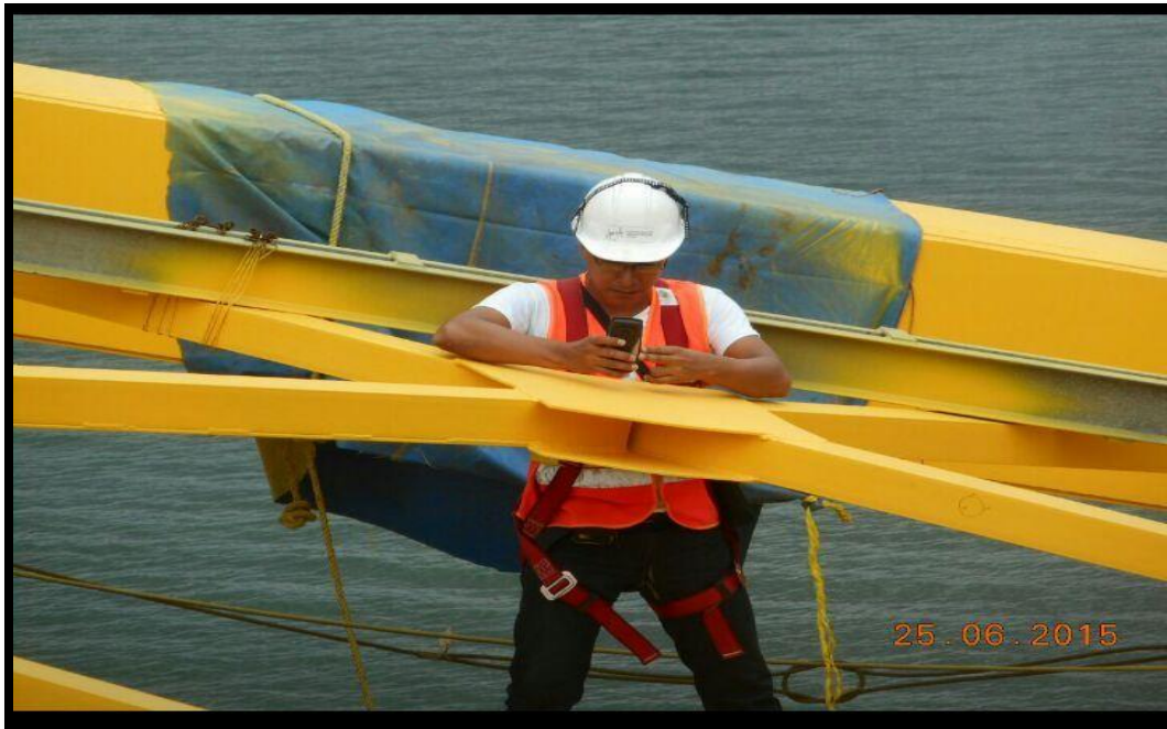
Fig. Verificación de espesores de pintura anticorrosiva en estructuras metálicas
