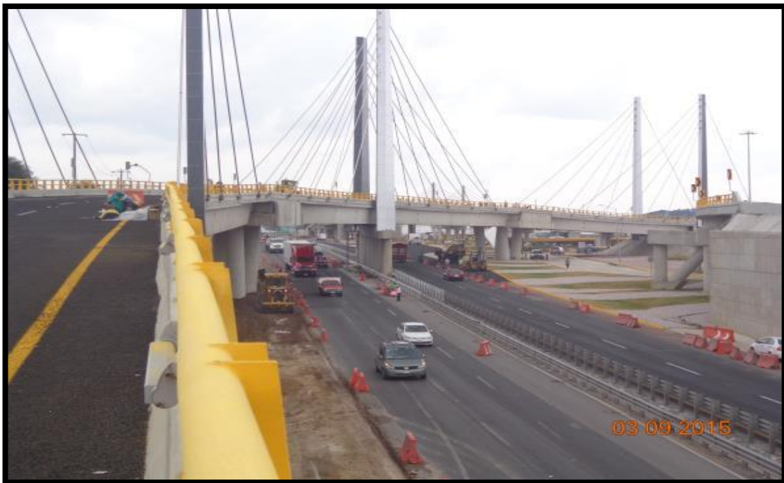
Fig. Construcción de distribuidor vial.
