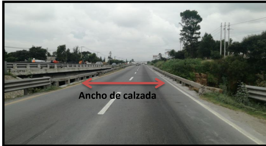
Fig. Superficie de rodamiento. Ancho de calzada de 7.50 m.
