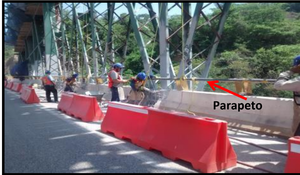
Fig. Mantenimiento de parapeto tipo.
