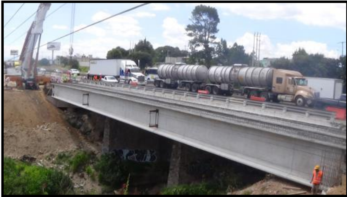
Fig. Tránsito de un camión tipo T3-S2-R4 y un camión tipo T3-S3 sobre el puente Amalucan cuerpo “A”.
