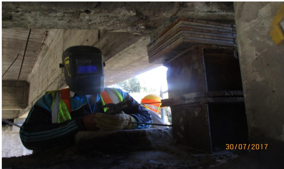
Fig. Fijación de bancos metálicos mediante puntos de soldadura.
