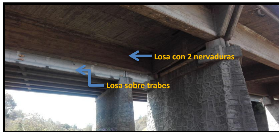
Fig. Losas con 2 nervaduras.
