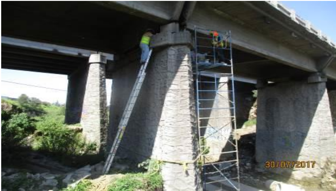
Fig. Inicio de los trabajos de aseguramiento del puente.
