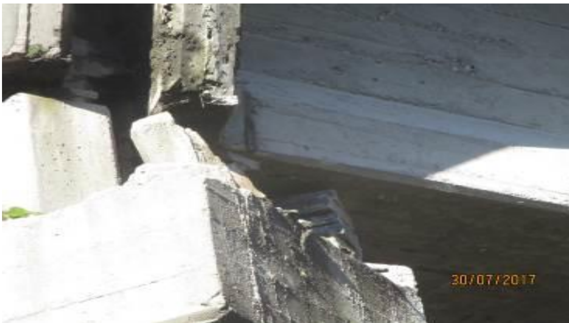
Fig. Vista del apoyo del tramo central lado aguas arriba sobre la pila.
