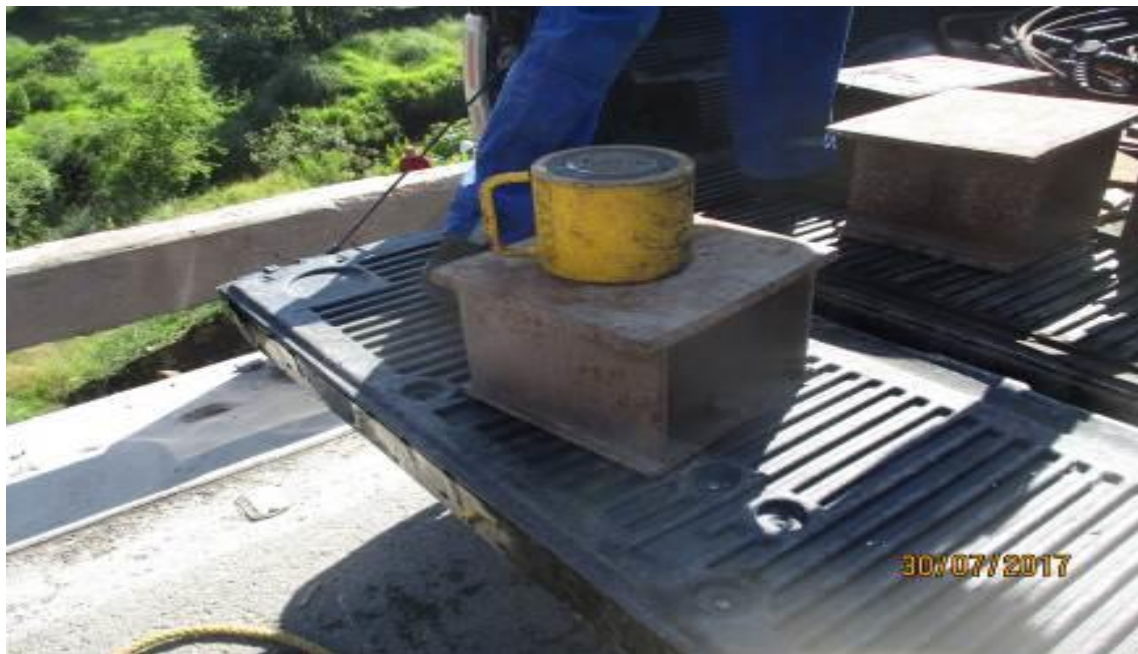
Fig. Bancos metálicos para gateo de la estructura y gato hidráulico con capacidad de 100 ton.
