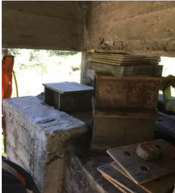
Fig. Zona de apoyo limpia y se coloca un banco de metálico día 30 de julio de 2017.
