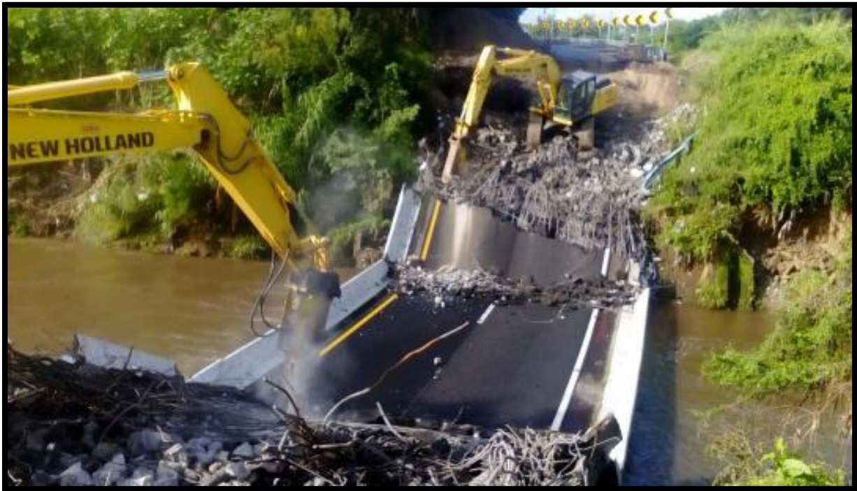
Fig. Demolición de puente Xochitepec, colapsado por sismo del 19 de Septiembre 2017.
