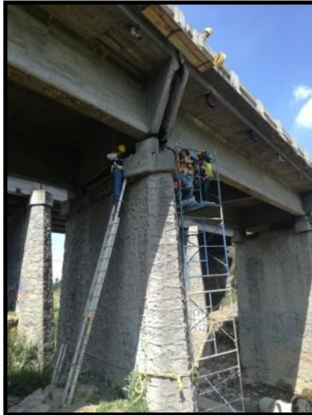
Fig. Trabajos de emergencia a la falla del apoyo en pila de eje 3 del puente Amalucan cuerpo “B”.
