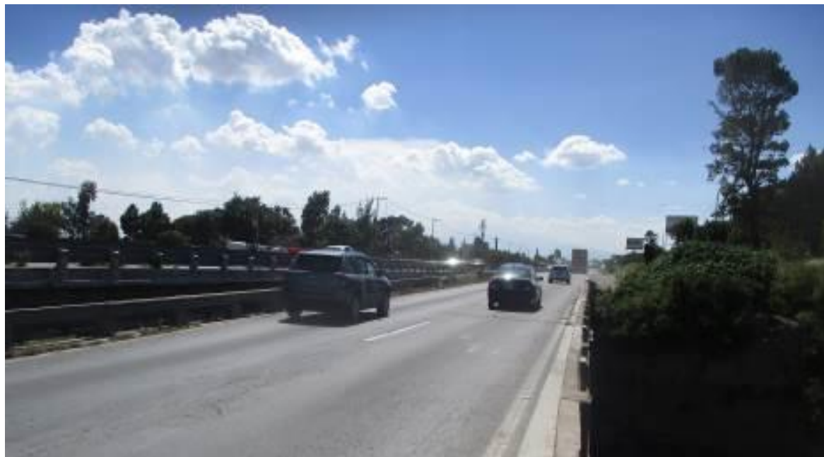
Fig. Puesta en servicio los dos carriles de circulación del cuerpo “B”.
