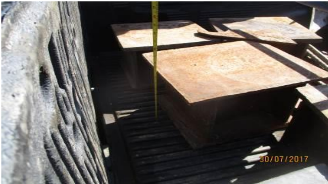
Fig. Bancos metálicos para el gateo de la estructura, elaborados con placas de acero A-36 de \frac{1}{2} " de espesor.
