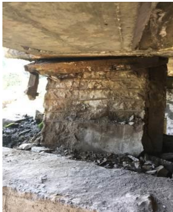
Fig. Vista transversal del apoyo de tramo central lado aguas arriba sobre pila 3 el 30 de julio de 2017.
