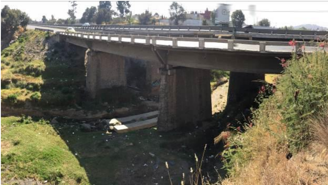
Fig. Vista del Puente Amalucan al inicio en el mes de enero de 2017.
