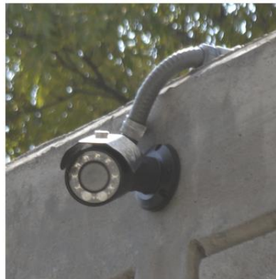
FOTOS 16 Y 17. CÁMARAS TIPO BALA PARA EXTERIORES
