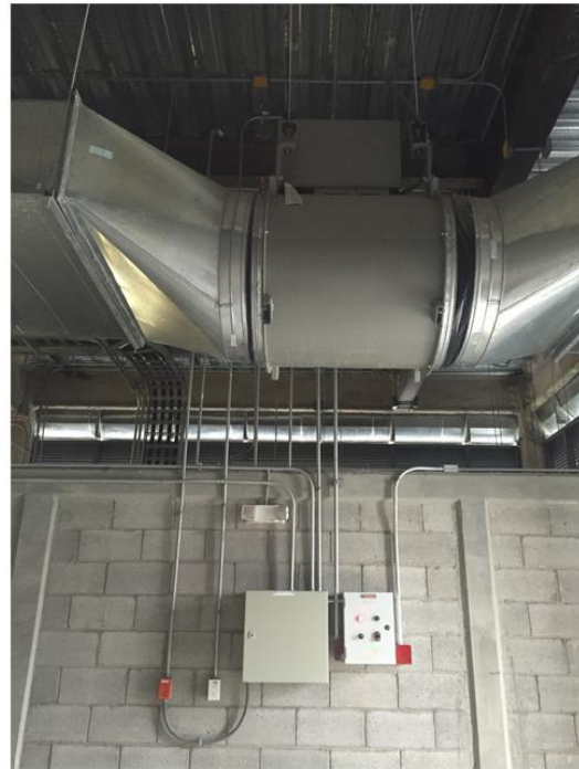
FOTOS 54 Y 55. TABLEROS DE CONTROL DE LA UNIDAD DE VENTILACIÓN DE AIRE NUEVO (UVAN)
