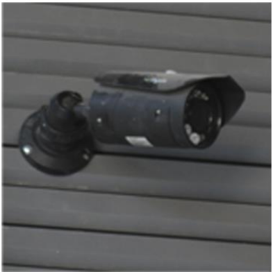
FOTOS 16 Y 17. CÁMARAS TIPO BALA PARA EXTERIORES
