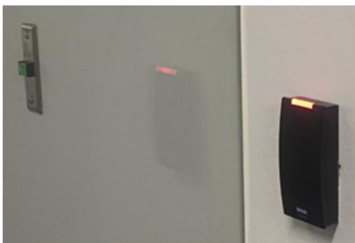
FOTOS 31 Y 32. LECTORA DE PROXIMIDAD Y BOTÓN DE LIBERACIÓN PARA ACCIONAMIENTO DE PUERTAS CON SISTEMA DE CONTROL DE ACCESO POR CONTRA MAGNÉTICA
