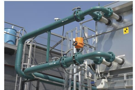
FOTOS 46, 47 Y 48. ELECTRO VÁLVULAS DE CONTROL DE AGUA DE LAS TORRES DE ENFRIAMIENTO
