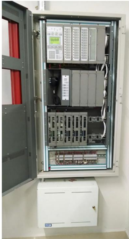
FOTOS 07 Y 08. PANEL CENTRAL DE INCENDIO CON BATERÍA DE RESPALDO (ABIERTO Y CERRADO)
