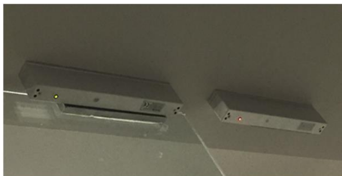
FOTOS 31 Y 32. LECTORA DE PROXIMIDAD Y BOTÓN DE LIBERACIÓN PARA ACCIONAMIENTO DE PUERTAS CON SISTEMA DE CONTROL DE ACCESO POR CONTRA MAGNÉTICA
