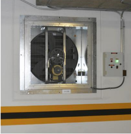
FOTOS 60 Y 61. SISTEMA DE INYECCIÓN Y EXTRACCIÓN DE AIRE EN SÓTANOS DE ESTACIONAMIENTO
