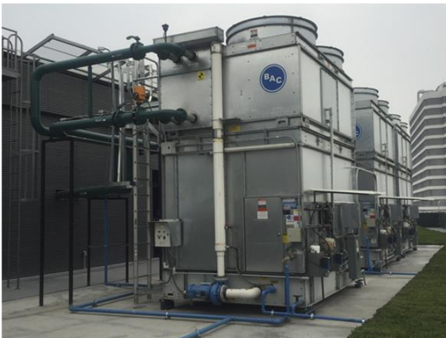
FOTOS 44 Y 45. TORRES DE ENFRIAMIENTO DEL SISTEMA DE AIRE ACONDICIONADO
