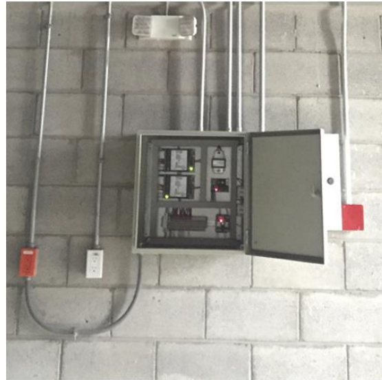
FOTOS 12 Y 13. PANEL DE CONTROL DE PRESURIZACIÓN DE ESCALERAS DE EMERGENCIA (CERRADO Y ABIERTO)
