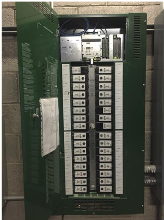
FOTOS 58 Y 59. TABLEROS GREENMAX ABIERTOS PARA CONTROL DE ILUMINACIÓN
