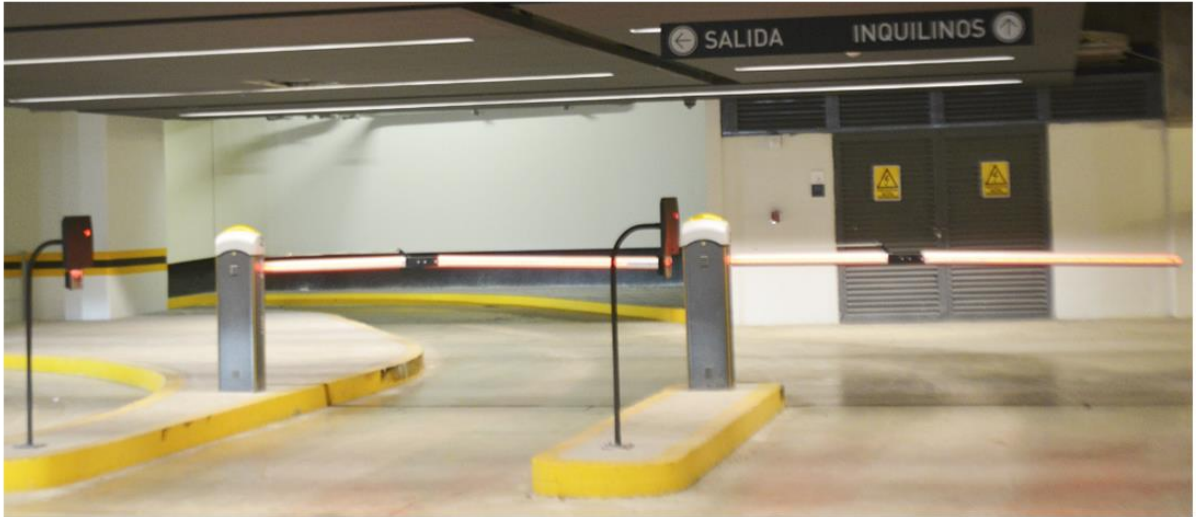
FOTO 37. CONTROL DE ACCESO CON BARRERA VEHICULAR A ESTACIONAMIENTO EN SÓTANOS
