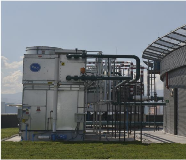
FOTOS 42 Y 43. TORRES DE ENFRIAMIENTO DEL SISTEMA DE AIRE ACONDICIONADO
