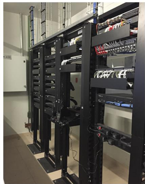
FOTOS 21 Y 22. RACKS DE DVRs DE 16 CANALES UBICADOS EN EL CUARTO DE CONTROL
