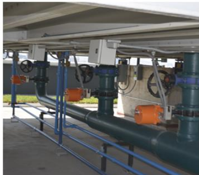
FOTOS 46, 47 Y 48. ELECTRO VÁLVULAS DE CONTROL DE AGUA DE LAS TORRES DE ENFRIAMIENTO
