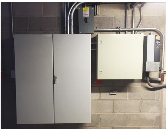
FOTOS 44 Y 45. TABLERO CENTRAL DE AGUA HELADA, CHILLERS Y TORRES DE ENFRIAMIENTO
