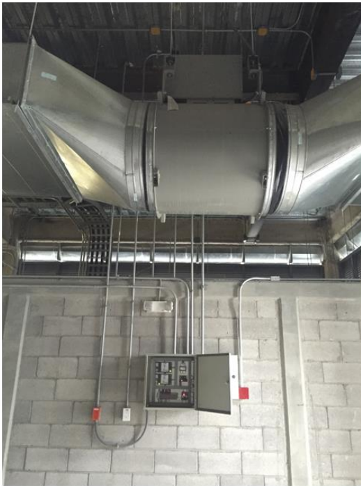
FOTOS 54 Y 55. TABLEROS DE CONTROL DE LA UNIDAD DE VENTILACIÓN DE AIRE NUEVO (UVAN)
