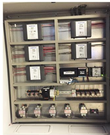
FOTOS 44 Y 45. TABLERO CENTRAL DE AGUA HELADA, CHILLERS Y TORRES DE ENFRIAMIENTO
