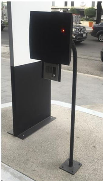
FOTOS 35 Y 36. LECTORAS DE PRÓXIMIDAD PARA ACCIONAMIENTO DE BARRERA VEHICULAR
