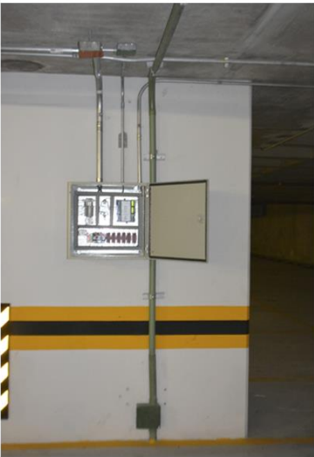
FOTOS 62 Y 63. TABLERO DE CONTROL DE VENTILACIÓN EN SÓTANOS
