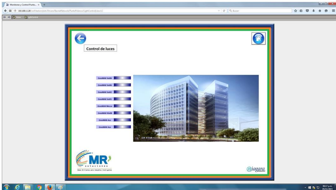
FOTO 71. PANTALLA DEL SISTEMA BMS PARA MONITOREO Y CONTROL DE LUCES
