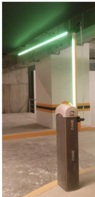
FOTO 37. CONTROL DE ACCESO CON BARRERA VEHICULAR A ESTACIONAMIENTO EN SÓTANOS
