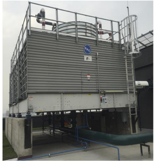
FOTOS 42 Y 43. TORRES DE ENFRIAMIENTO DEL SISTEMA DE AIRE ACONDICIONADO
