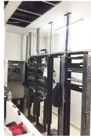
FOTOS 65 Y 66. RACK DE COMUNICACIONES PARA EL SISTEMA BMS EN CUARTO DE CONTROL
