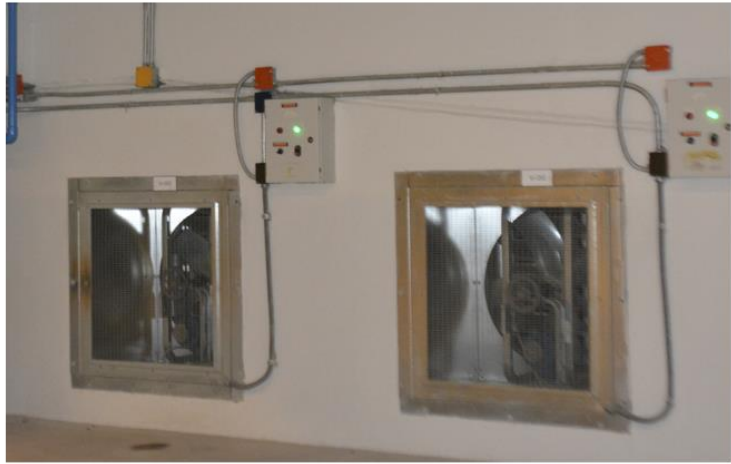
FOTOS 60 Y 61. SISTEMA DE INYECCIÓN Y EXTRACCIÓN DE AIRE EN SÓTANOS DE ESTACIONAMIENTO
