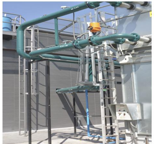
FOTOS 44 Y 45. TORRES DE ENFRIAMIENTO DEL SISTEMA DE AIRE ACONDICIONADO
