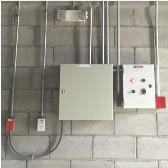
FOTOS 12 Y 13. PANEL DE CONTROL DE PRESURIZACIÓN DE ESCALERAS DE EMERGENCIA (CERRADO Y ABIERTO)
