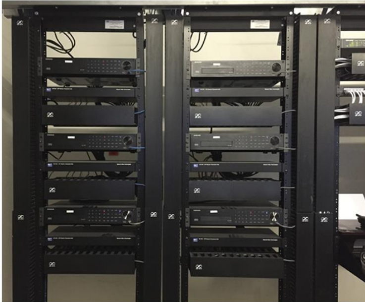
FOTOS 21 Y 22. RACKS DE DVRs DE 16 CANALES UBICADOS EN EL CUARTO DE CONTROL
