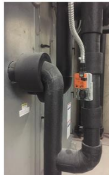
FOTOS 46, 47 Y 48. ELECTRO VÁLVULAS DE CONTROL DE AGUA DE LAS TORRES DE ENFRIAMIENTO
