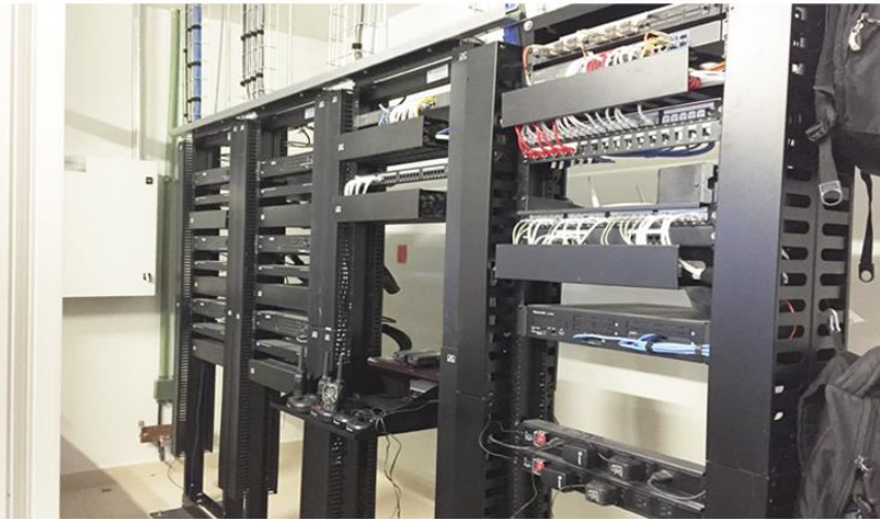
FOTOS 65 Y 66. RACK DE COMUNICACIONES PARA EL SISTEMA BMS EN CUARTO DE CONTROL
