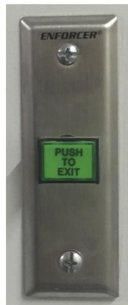
FOTOS 29 Y 30. LECTORA DE PROXIMIDAD Y BOTÓN DE LIBERACIÓN PARA ACCIONAMIENTO DE PUERTAS
