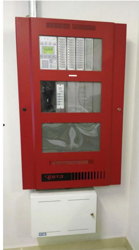
FOTOS 07 Y 08. PANEL CENTRAL DE INCENDIO CON BATERÍA DE RESPALDO (ABIERTO Y CERRADO)
