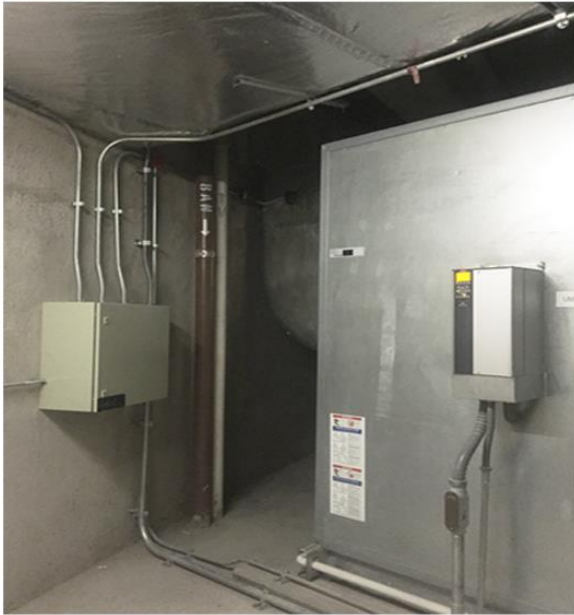
FOTOS 46 Y 47. UNIDAD MANEJADORA DE AIRE (UMA)
