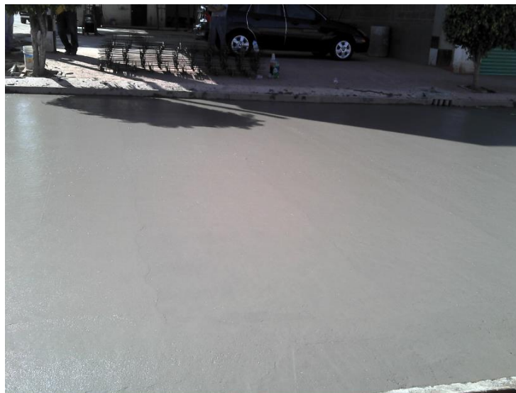
Imagen VI.5.3 Acabado liso de la losa.
