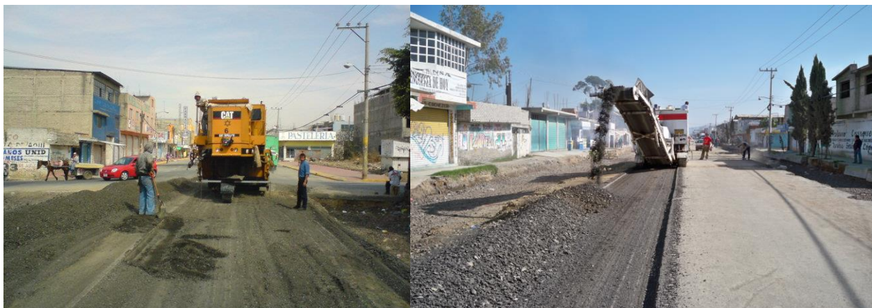
Imágenes VI.3.6 Trituración de la carpeta Existente.
