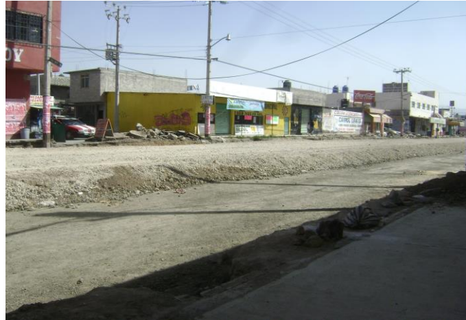
Imagen VI.3.11 Conformación de la base
