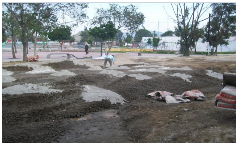
Imagen II.2.2.1 estabilización de suelo con cal.
