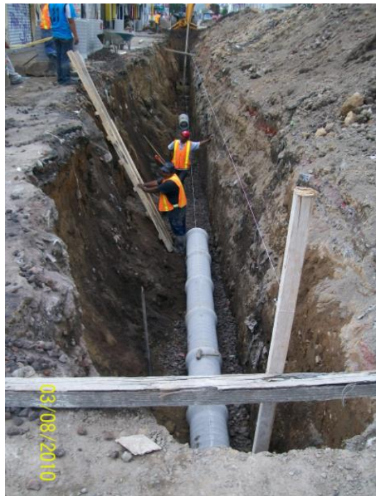
VI.2.3 Introducción de colector para descargas domiciliarias y agua pluvial
