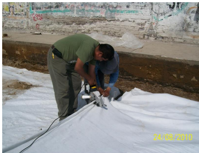
Imagen VI.3.4 Costura de traslapes en el geotextil
