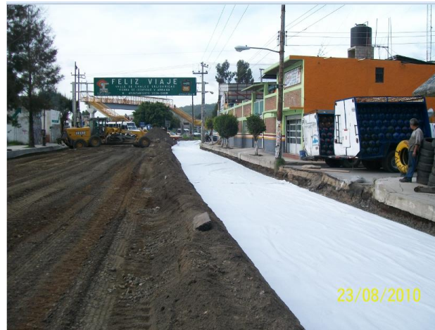
Imagen VI.3.3 colocación del filtro textil
