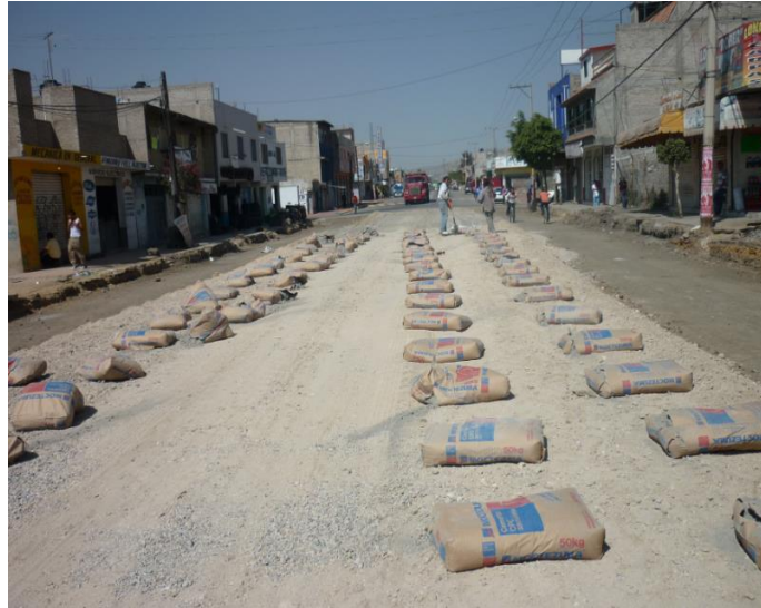
Imagen II.2.2 trabajos previos para la construcción del suelo cemento.
