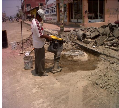
Imagen VI.4.2 Renivelación de pozos de visita
