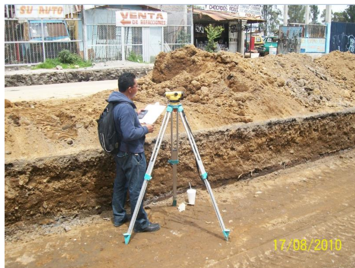
Imagen VI.3.1 revisión de niveles de excavación y preparación de la cama cortes
