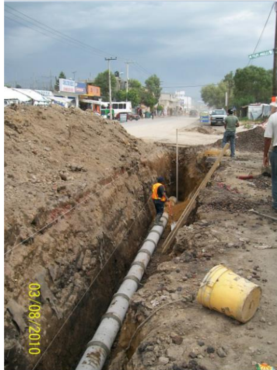
VI.2.4 Introducción de tubería para desalojo de aguas negras y pluviales
