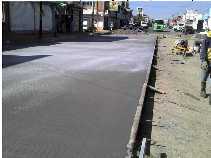
Imagen VI.5.5 colocación de membrana de curado.
