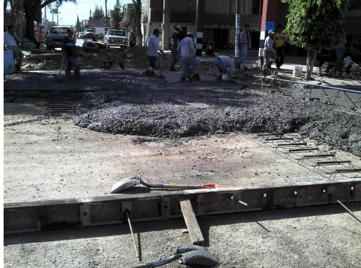
Imagen VI.5.2 colocación de las canastillas y empate con calles que comunican con la vialidad.
