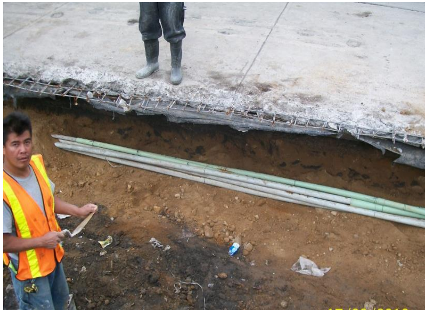
V.6 Obras inducidas, canalización de telefonía.
