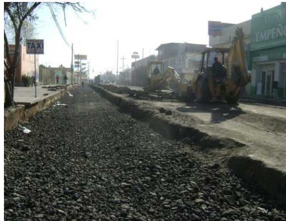
VI.3.5 Construcción de la capa de tezontle.
