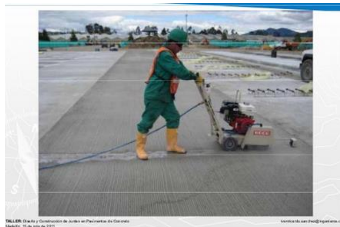
Imagen VI.5.7 Trabajos de corte para inducir la grieta.
