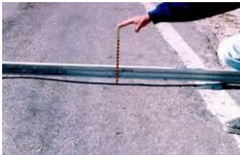
Imagen IV.2.2.3 Falla por cortante
