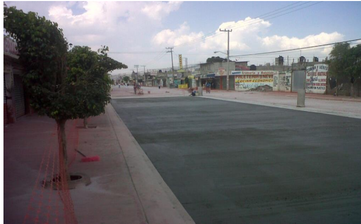
Imagen VI.5.7 acabado de la superficie de rodamiento.
