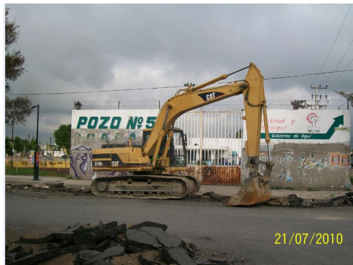
VI.1.3 Excavación por medios mecánicos
