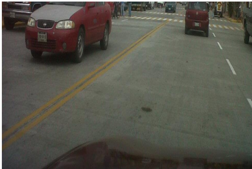
Imagen VI.6.4 operación de la vialidad con su respectiva pintura en la vialidad.
