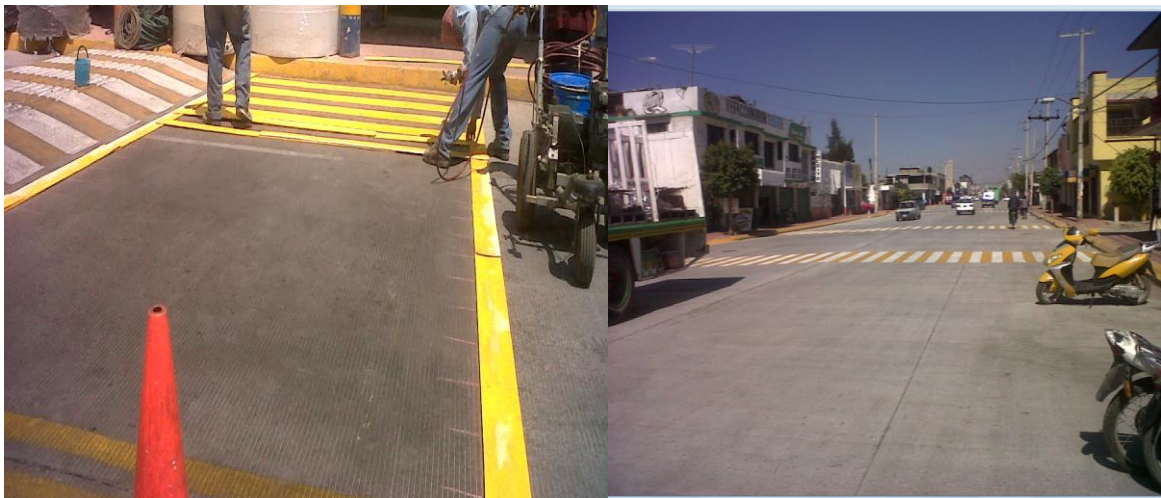
Imagen VI.6.2 Pintura para pasos peatonales de protección.
