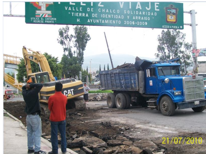
VI.1.4 Carga y acarreo de material producto de la excavación
