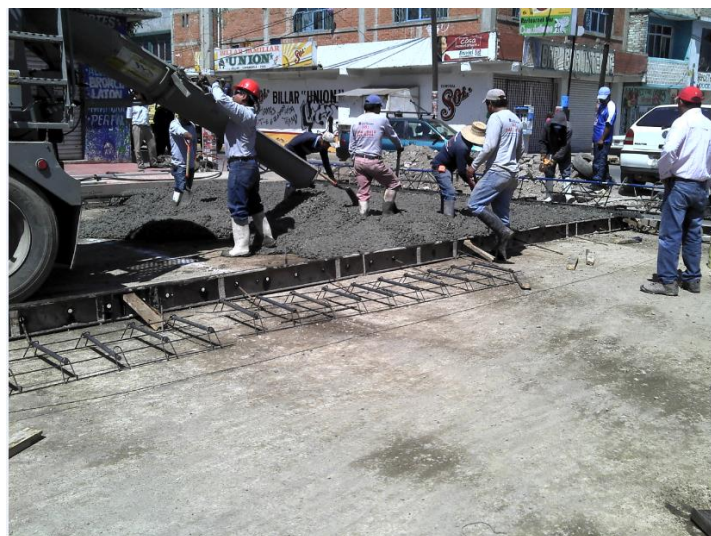
Imagen VI.5.1 Construcción pavimento rígido.
