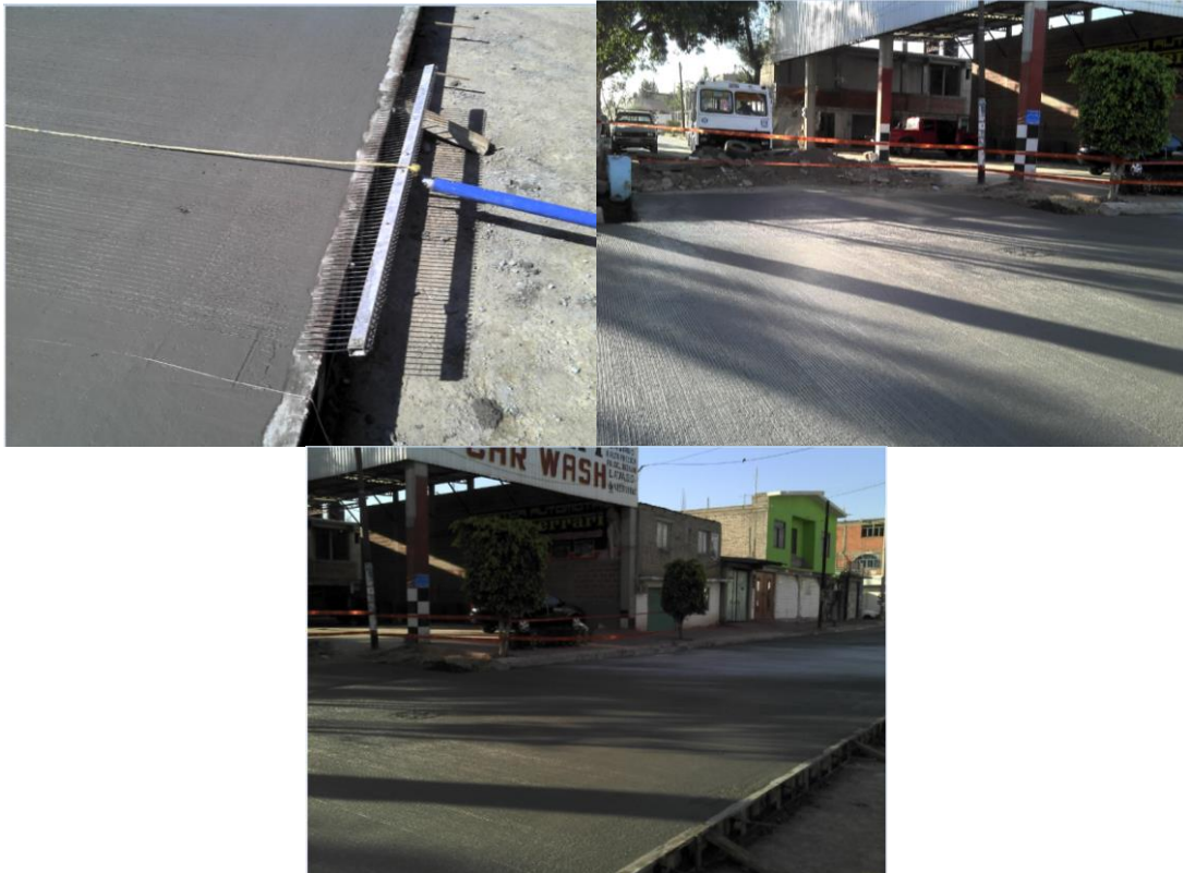
Imágenes VI.5.4 acabado final del pavimento.
