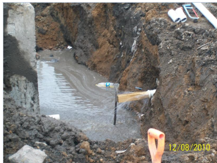
Imagen VI.2.5 reparaciones de líneas de agua potable
