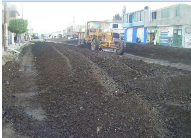
Imagen III.4.1 Sub base de grava controlada y material producto de la trituración existente.
