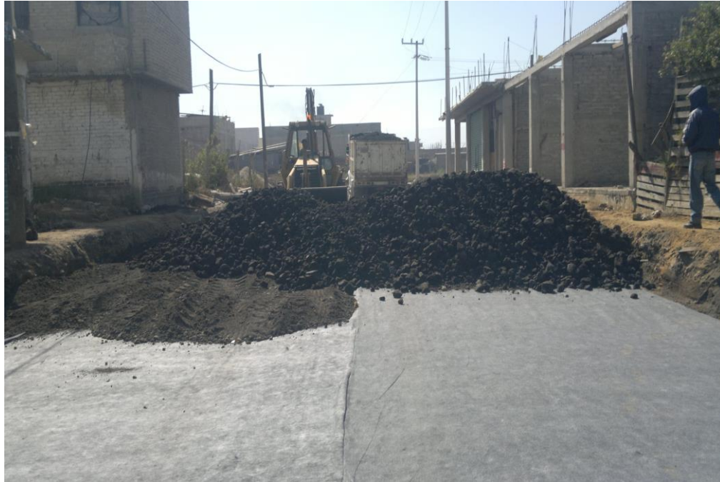
Imagen III.3.1 colocación de geosintético y la colocación y tendido de la capa sub rasante.
