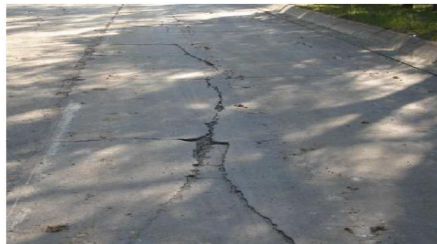
Imagen IV.3.3 Grietas longitudinales
