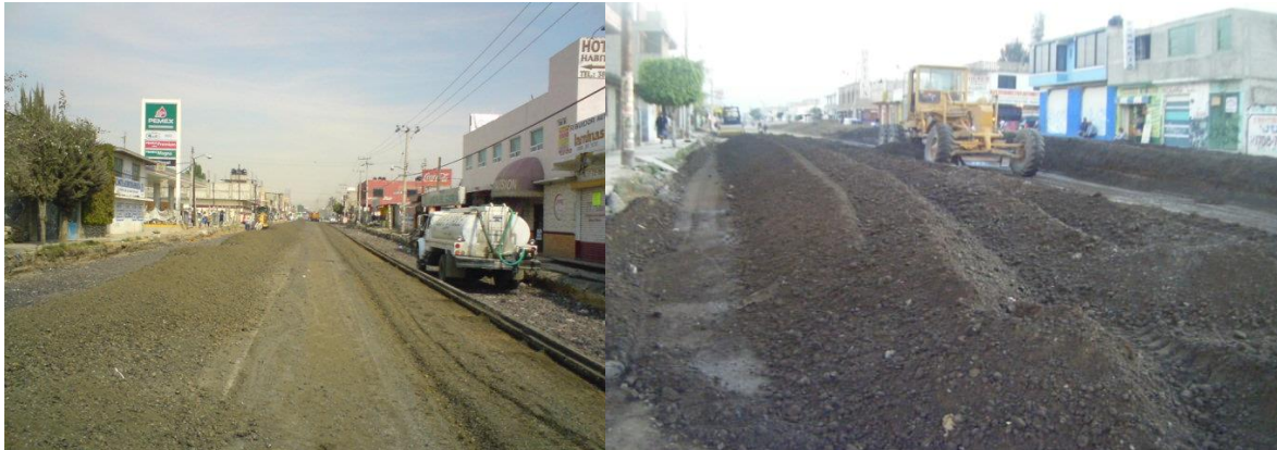
Imágenes VI.3.8 Conformación de sub base.
