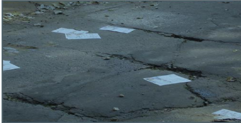
Imagen IV.3.4 Falla Estructural
