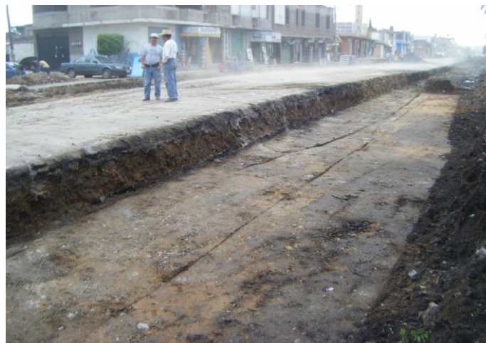
Imagen VI.3.2 cama de los cortes preparada para recibir el geotextil
