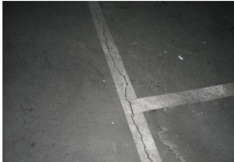
Imagen IV.2.2.4 Agrietamiento Longitudinal
