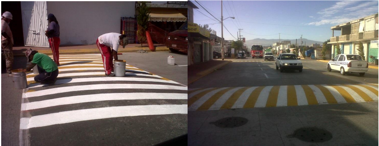
Imagen VI.6.2 Pintura en reductores de velocidad (topes).
