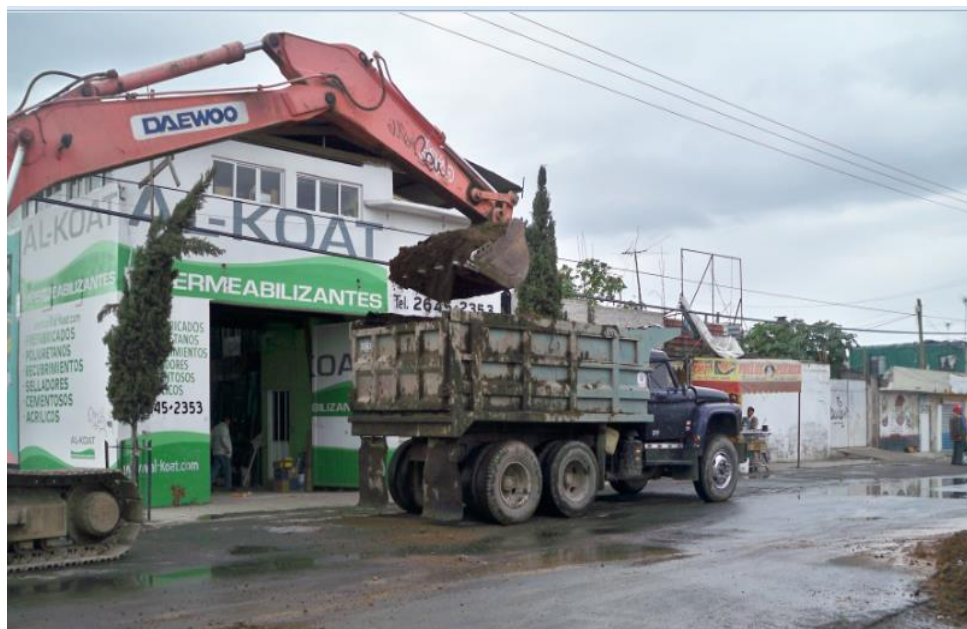
Imagen V.5. Trabajos de excavación en avenida Cuauhtémoc
