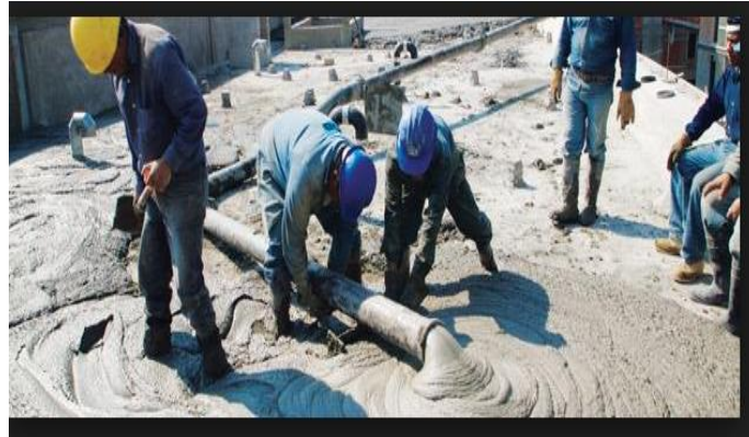
Imagen II.2.2.3 estabilización de suelo con relleno fluido.
