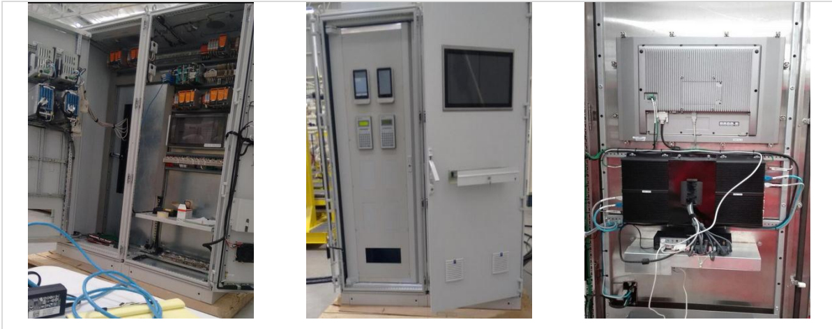
Fig. 4.17 Tendido de cable para caja de conexiones
