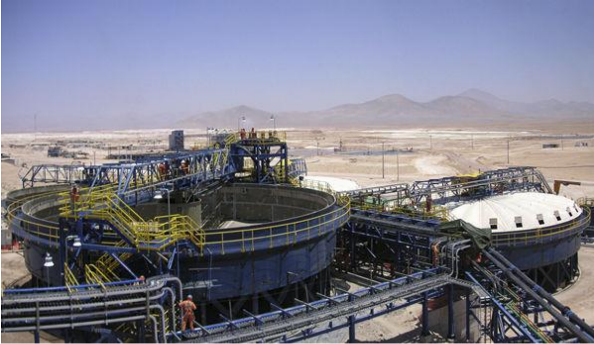
Fig. 2.8 Espesador de concentrado (imagen de archivo personal de GMSI)
