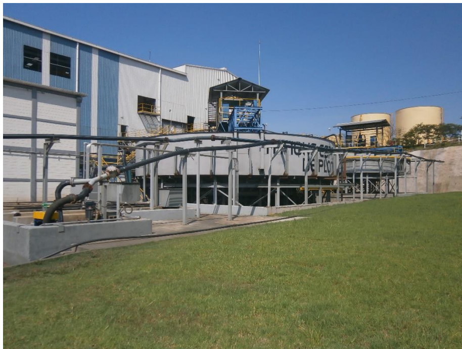
Fig. 2.7 Espesador de concentrado (imagen de archivo personal de GMSI)
