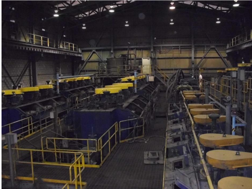
Fig. 2.19. Edificio de flotación. (Archivo personal de GMSI)
