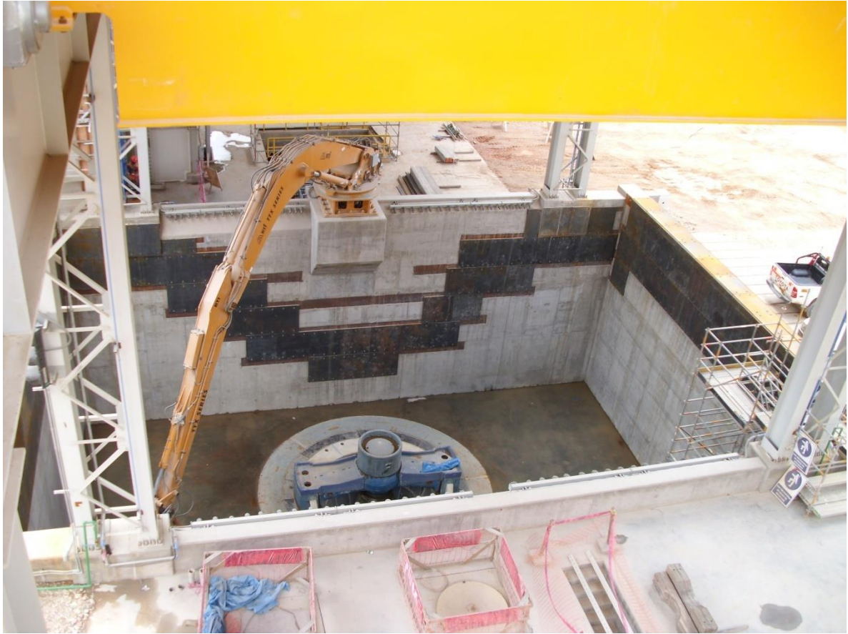
Fig. 2.15. Vista superior de quebradora giratoria con su tolva donde descargan los volquetes y su picador de roca para partir rocas que exceden el tamaño (archivo personal de GMSI)
