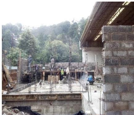
Excavación y colado de plantilla para habilitación de acero en zapatas corridas y cimbrado en área de gradas. Se reforzaron columnas existentes de primer nivel revistiéndolas de acero, cimbrando y colando de dimensiones de 30\*30
