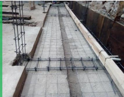
Se coló la plantilla de concreto con resistencia de  $f'c = 150$  kg/m<sup>2</sup> en el perímetro de la alberca, que es el pasillo para las instalaciones con 1.30m de ancho.
