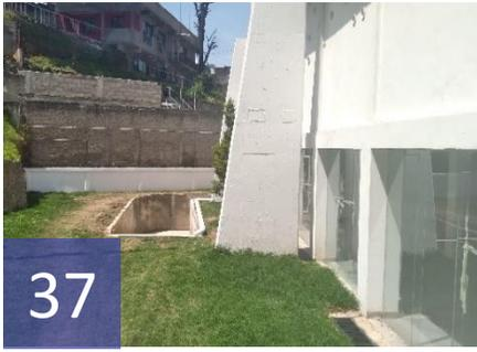
En la fachada norte encontramos los contrafuertes, vanos entre columnas con colocación de cristales templados. Acceso de rampa hacia cuarto de máquinas.
