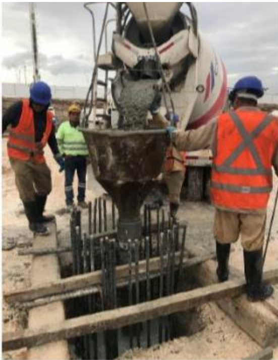
FIGURA 197.- COLADO DE PILAS.
