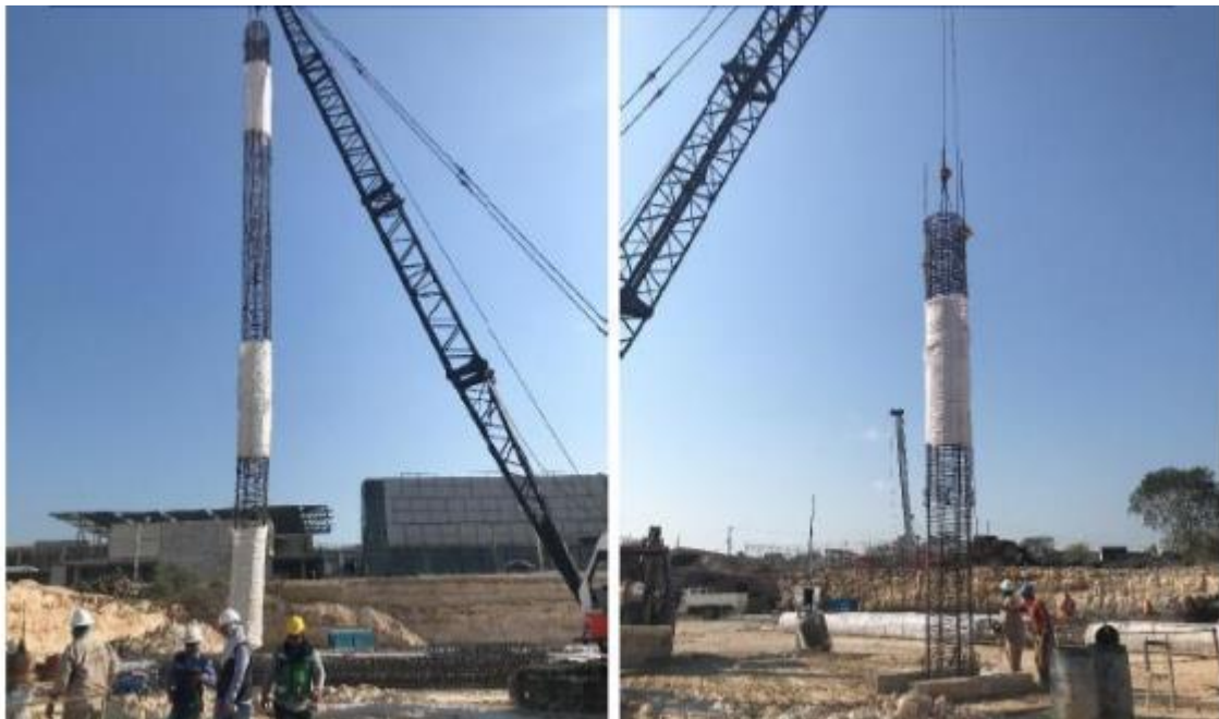
FIGURA 195.- COLOCACIÓN DE TERGALINA.
