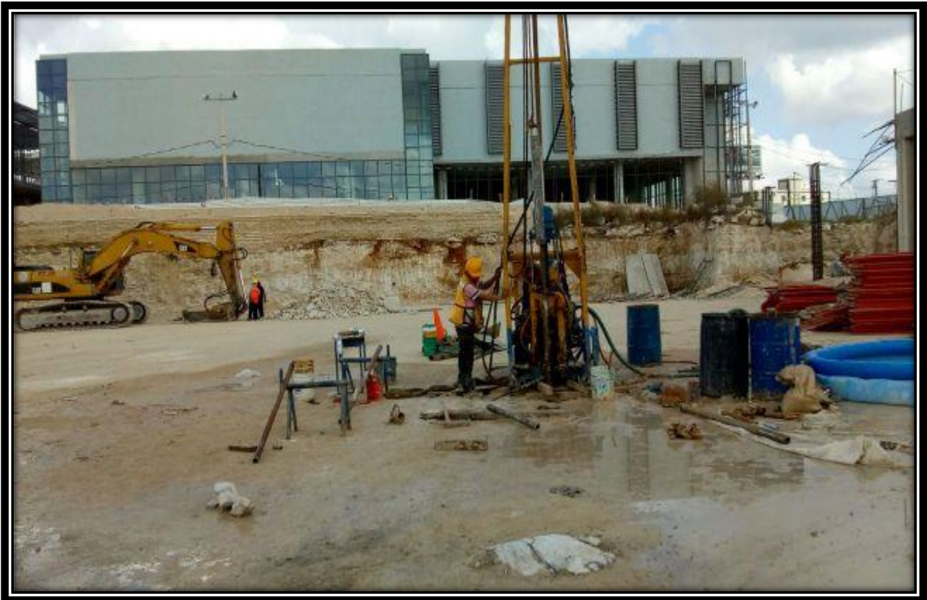
EXPLORACIÓN DEL SUBSUELO EN TORRE 1.
