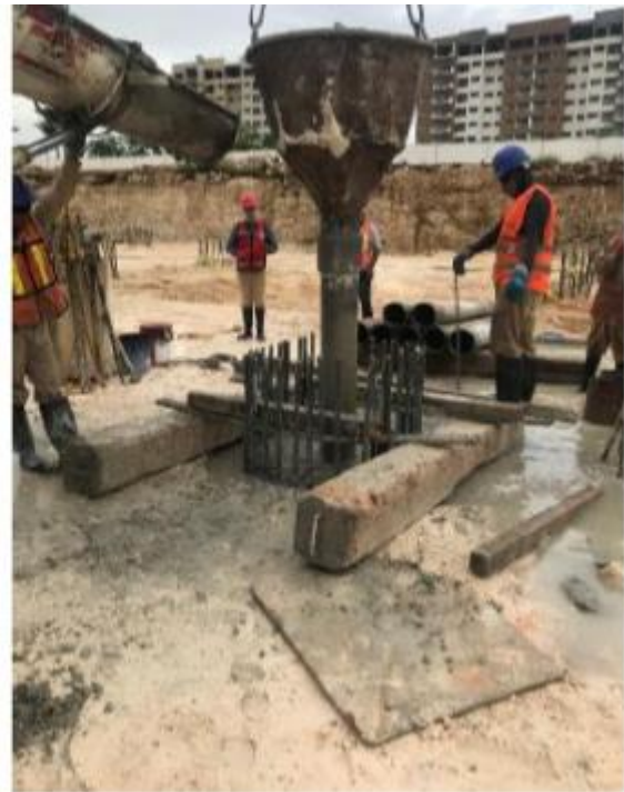
FIGURA 197.- COLADO DE PILAS.
