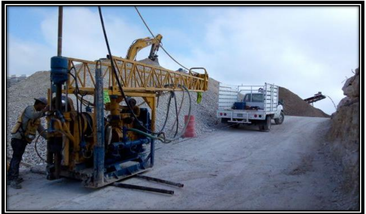
EXPLORACIÓN DEL SUBSUELO EN TORRE ÍNDICO
