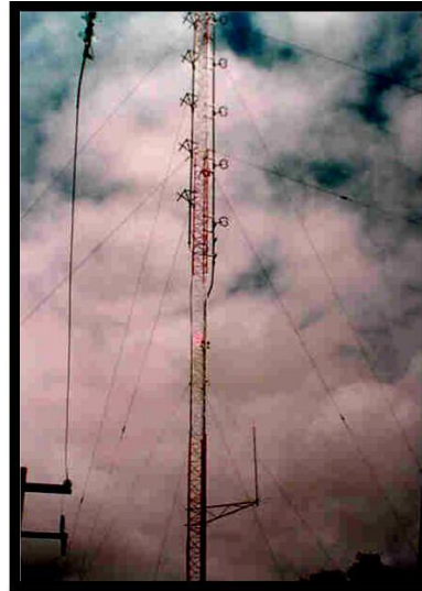
Ilustración 2.17: Estructura y Sistema Radiador (Antena)
