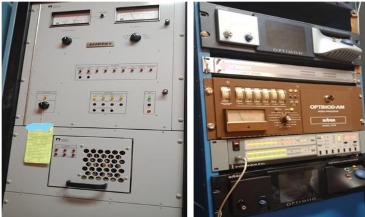
Ilustración 2.20 - En esta imagen 1 (izq) se observa un transmisor que opera en Frecuencia Modulada. En la imagen 2 (der) se observa un arreglo de medidores de comprobación técnica, (dos monitores de modulación, uno analógico y otro digital, y dos procesadores de audio digital.
