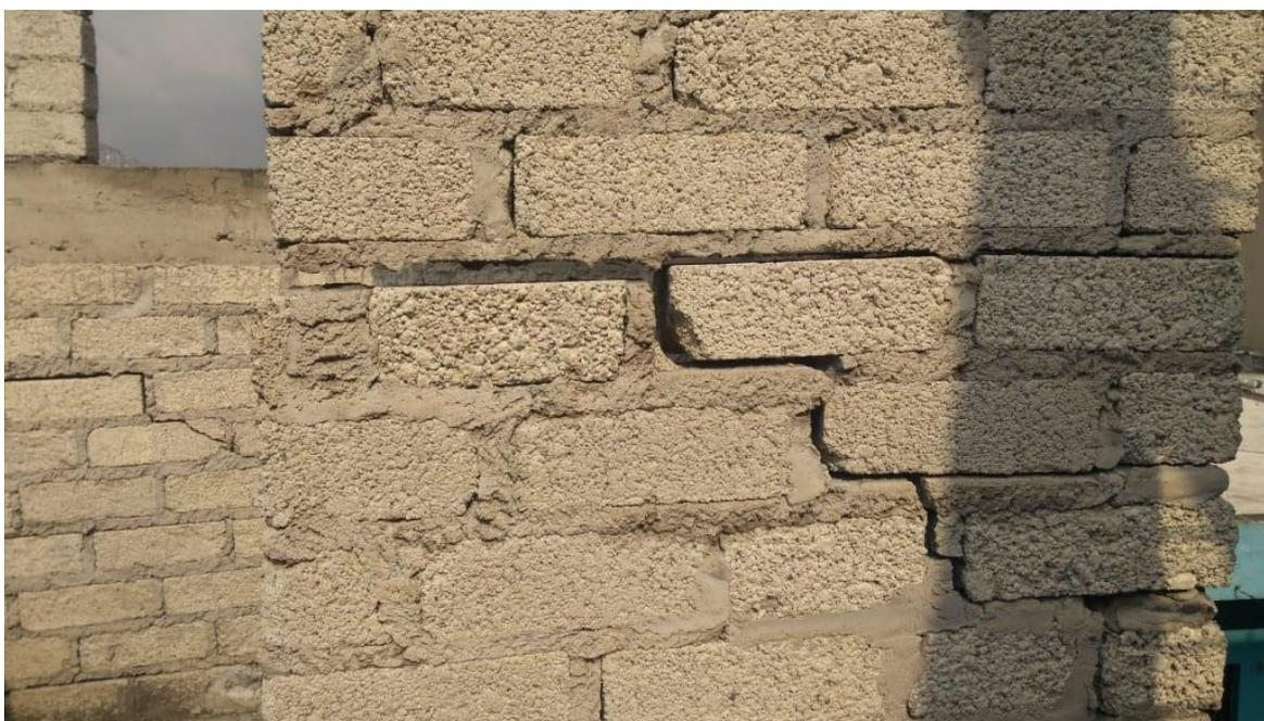
*Imagen 1.3.3.7.- Foto de murete dañado por falta de castillos.*
