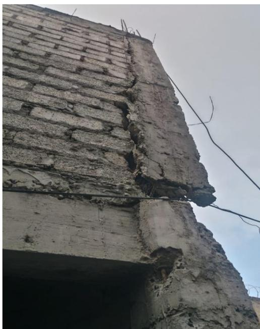
*Imagen 1.3.3.4.- Foto de castillo dañado de planta baja a planta alta.*
