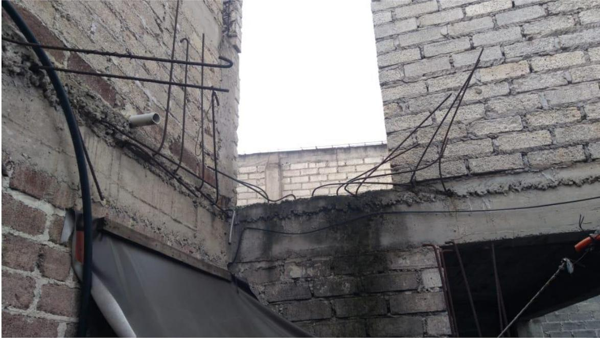
*Imagen 1.3.3.10.- Foto de falta de castillos en muros.*
