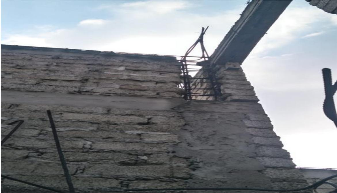
*Imagen 1.3.3.8.- Foto de mal proceso constructivo en castillo.*
