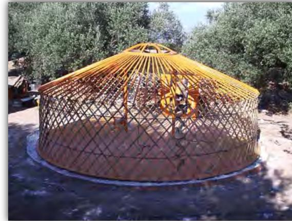
Figura 24. Interior de la "Yurta Mongol" o "Gher". Estructura hecha con madera de manera "enrejada", el techo es un cono truncado hecho del mismo material con anillos que permiten su rigidez.
