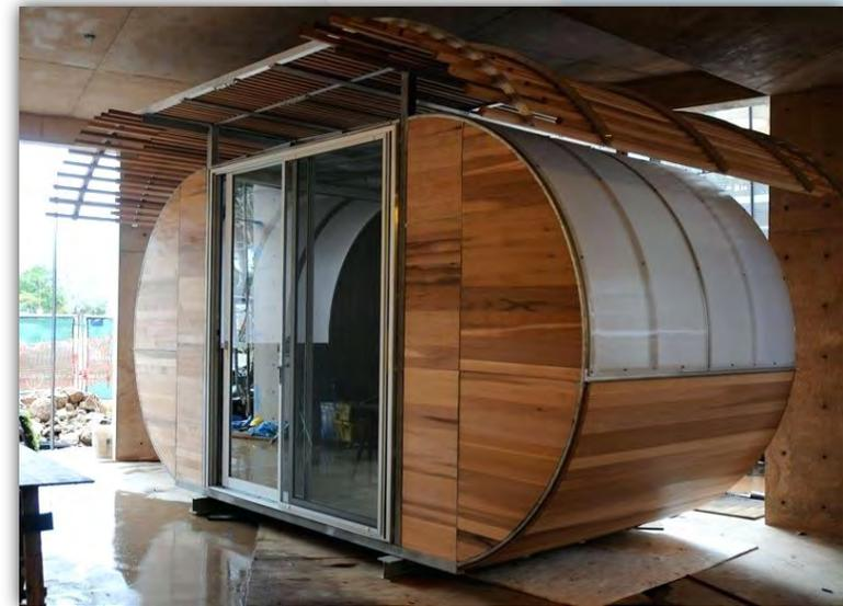
Figura 29. Prototipo de la “Casa Arco”. Ofrece energía por medio de paneles solares, y cuenta con sensores en las puertas que suprimen las manijas.
