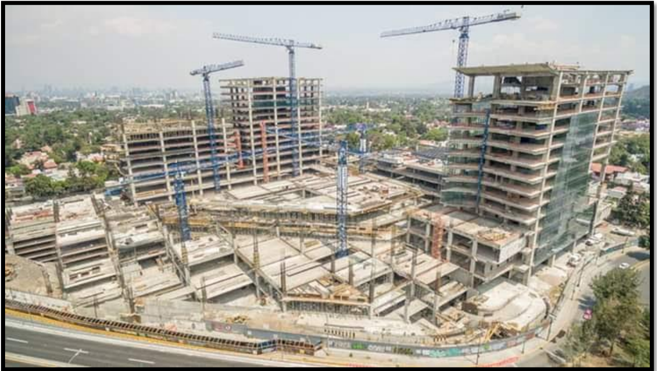
Ilustración 53. Construcción ARTZ PEDREGAL.
