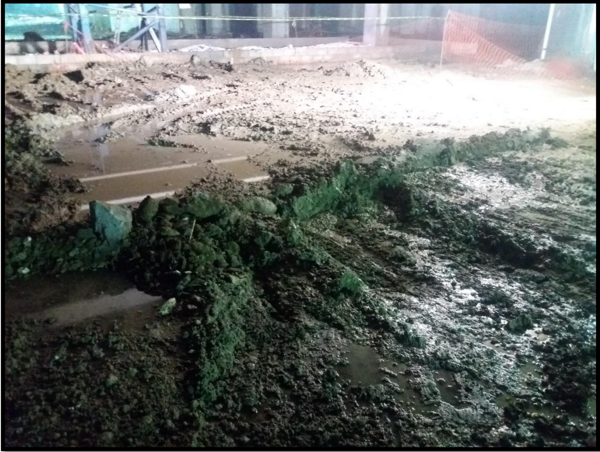
Ilustración 52. Material de relleno saturado.
