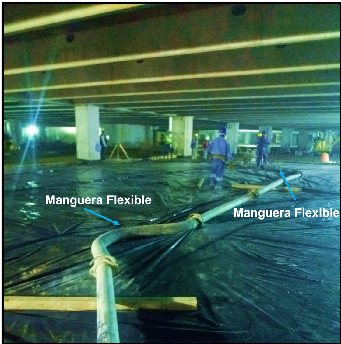
Ilustración 66. Conexión de tubería de colado.
