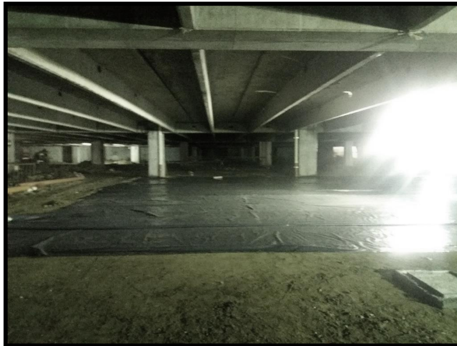
Ilustración 72. Suelo cemento aplicado como alternativa.
