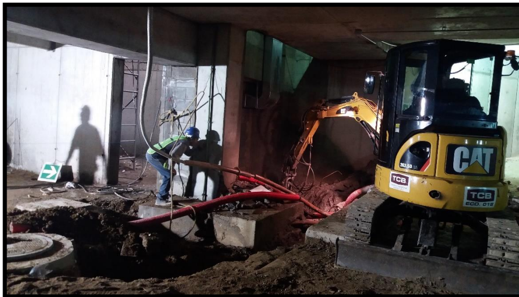
Ilustración 59. Mini retroexcavadora con rompedora.
