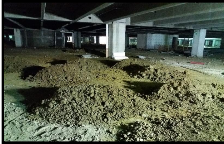
Ilustración 61. Material para afine y compactación.
