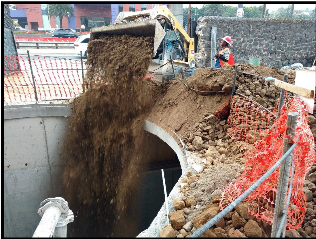
Ilustración 56. Depósito de material sano de relleno.
