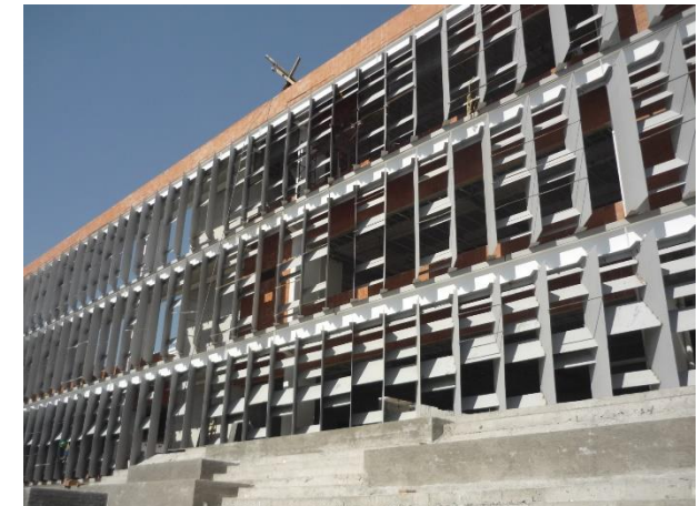
Fachaleta en pasillos, mármol en escalera y fachada de acero en parasoles.
