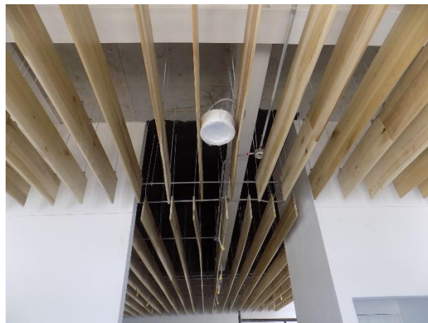
Falso plafón de placas e madera, instalaciones eléctricas e hidrosanitarias.
