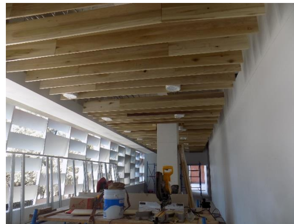
Falso plafón de placas e madera, instalaciones eléctricas e hidrosanitarias.
