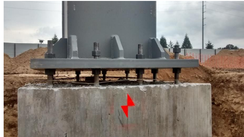
Anclaje de columnas a anclas en zapatas corridas, nivelación de la placa base.
