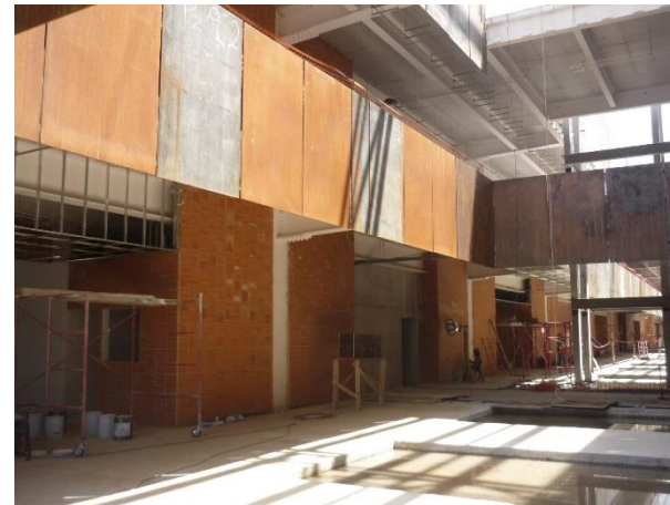
Fachaleta en pasillos, mármol en escalera y fachada de acero en parasoles.
