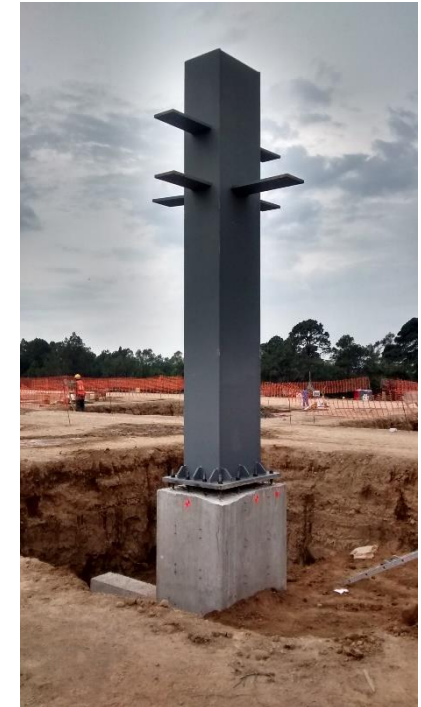
Anclaje de columnas a anclas en zapatas corridas, nivelación de la placa base.
