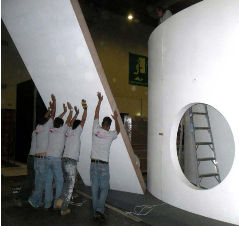
Ilustración 14. Personal operativo realizando el levantamiento de un tótem de 400 x 120 cm, por 20 cm de profundidad, durante un evento de montaje para un stand de la empresa General Electric, en junio del 2016 en el Centro internacional de exposiciones y convenciones. Imagen propia.
