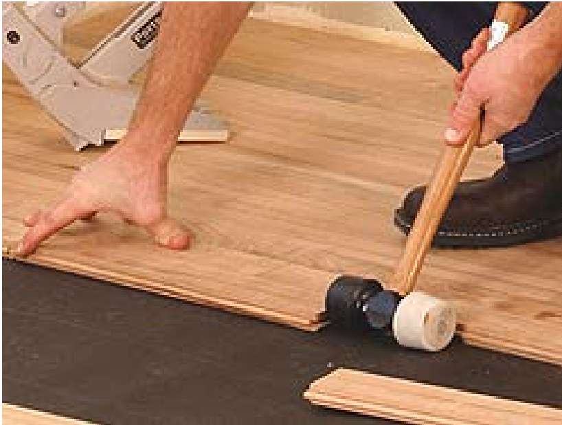
Ilustración 19. Colocación de duela sobre superficie plana. Imagen propia.
