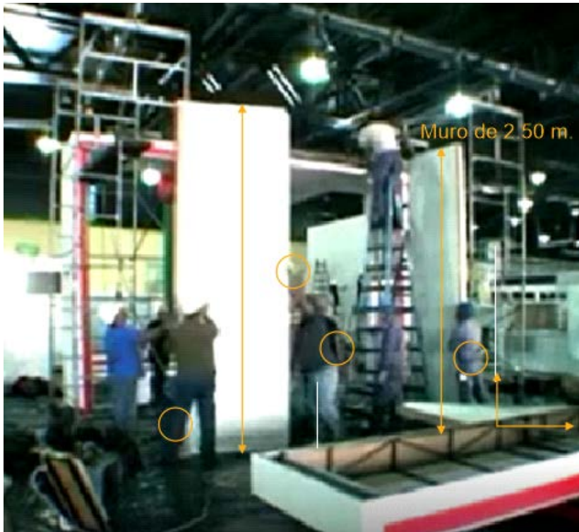
Ilustración 21. Para la colocación de los elementos de mayor peso, se requiere de hasta 4 personas que ayuden a estabilizar las piezas dentro del área donde se prevé sea anclada, con ayuda de mecanismos de sujeción removibles.
