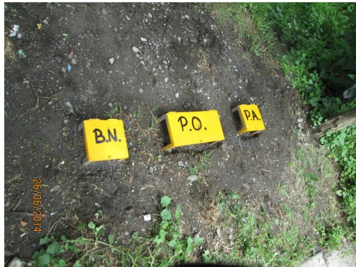
Pozo de observación (PO)
