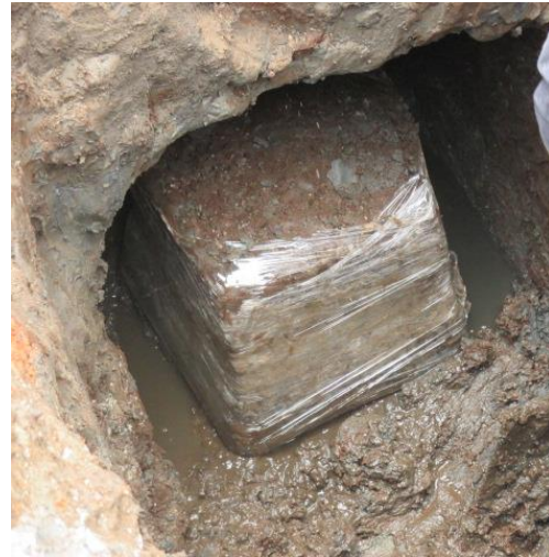
Pozo a Cielo Abierto
