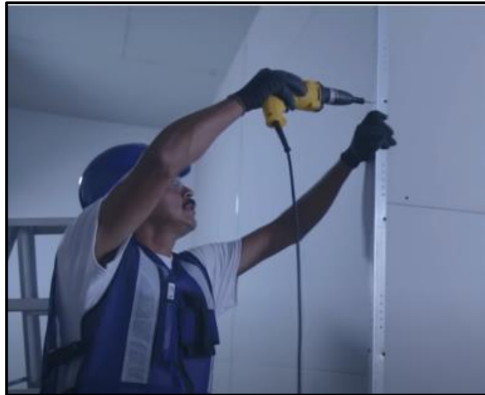
Figura 37. Atornillado para fijación en esquineros.
