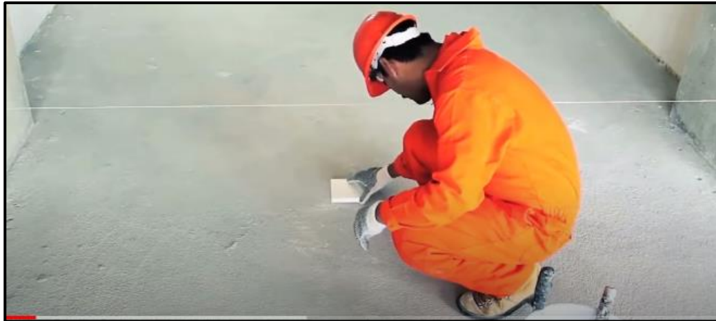
Figura 78. Colocación de calzas de poliestireno de alta densidad.
