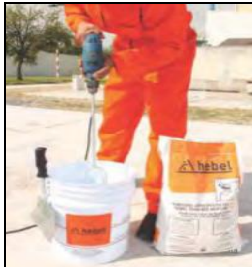
Figura 75. Preparación del adhesivo Hebel.
