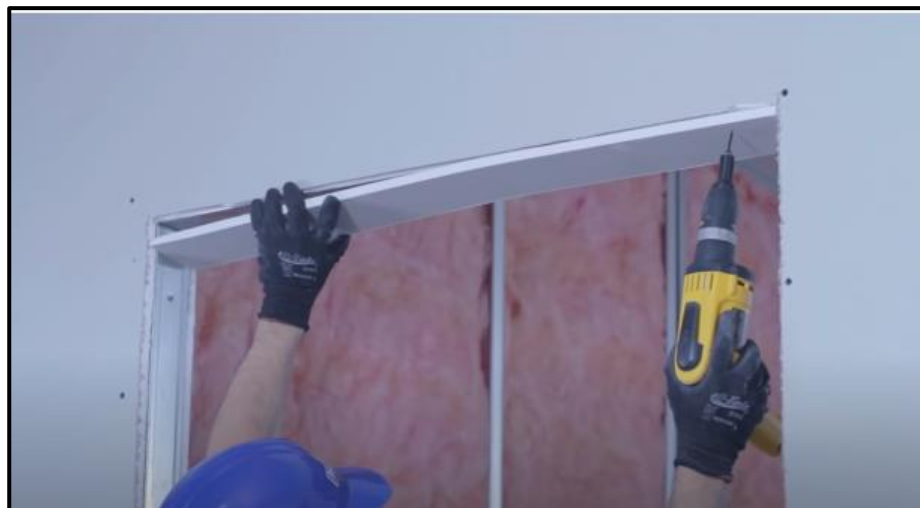
Figura 36. Colocación de tapas de panel de yeso en vanos o huecos.
