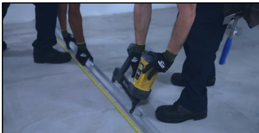
Figura 25. Colocación de tornillos a cada 60 cm entre sí.
