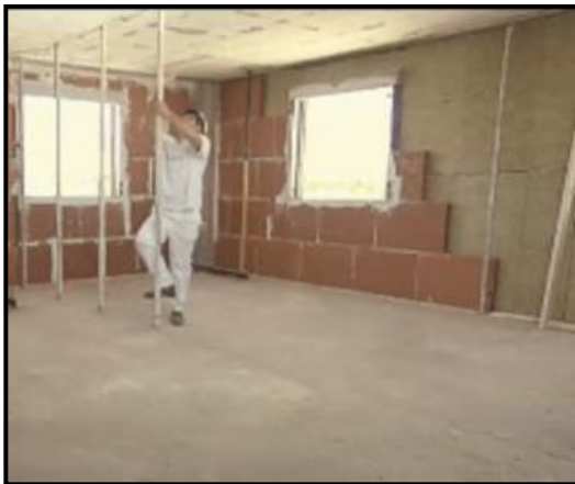
Figura 55. Colocación de reglas telescópicas.
