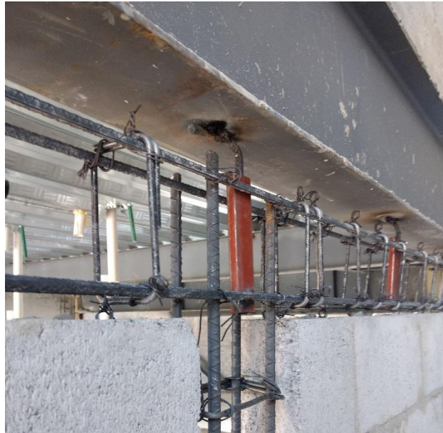
Figura 96. Acercamiento en la zona de conexión.
