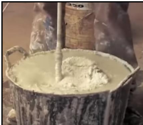
Figura 51. Batido de la mezcla.
