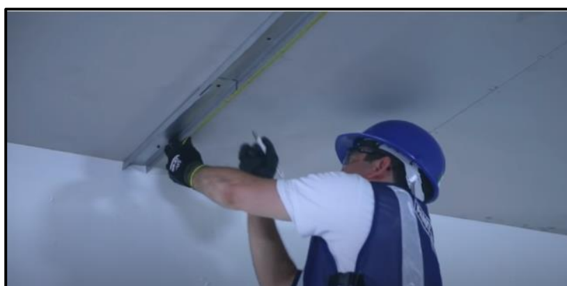
Figura 27. Ubicación y marcado para postes a cada 61 cm (sobre el techo).
