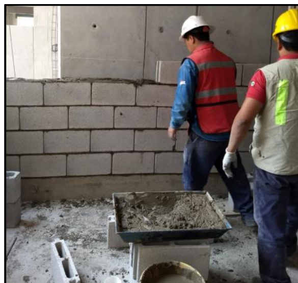
Figura 71. Colocación de hiladas subsecuentes.
