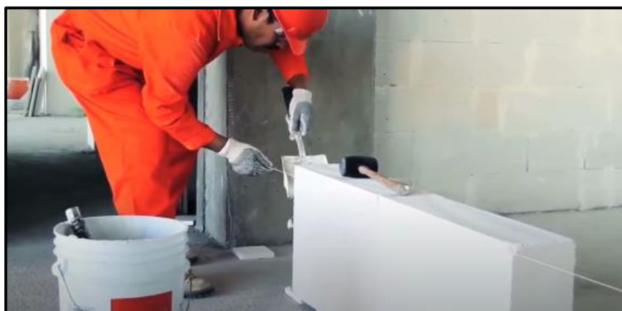
Figura 80. Aplicación de adhesivo sobre la cara lateral en espera del block siguiente.
