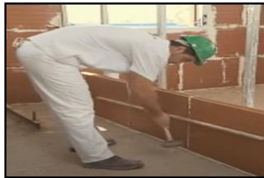
Figura 62. Alineación de la primera hilada.
