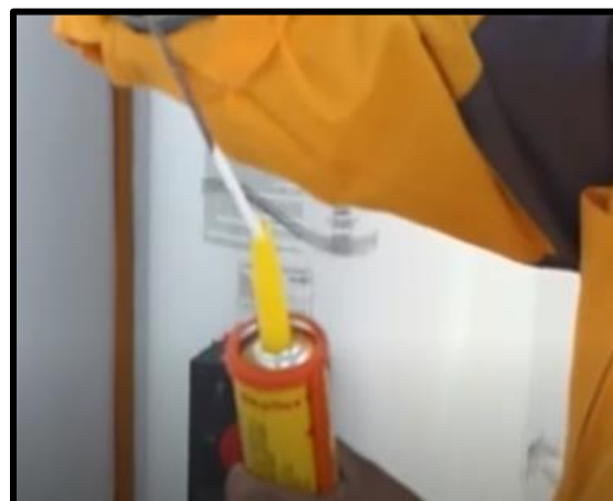
Figura 109. Perforación del sello del cartucho.
