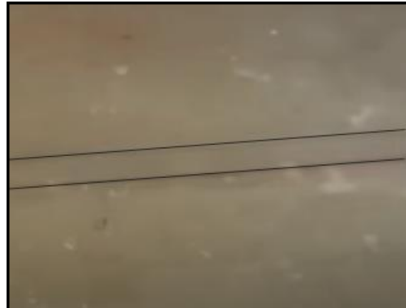
Figura 54. Superficie marcada a espera de recibir el desplante de muros.
