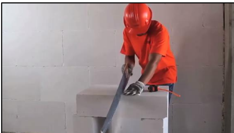
Figura 86. Corte con serrucho.
