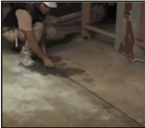
Figura 53. Marcado de los ejes.
