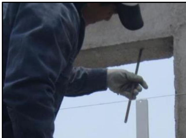
Figura 118. Anclaje de conexión.
