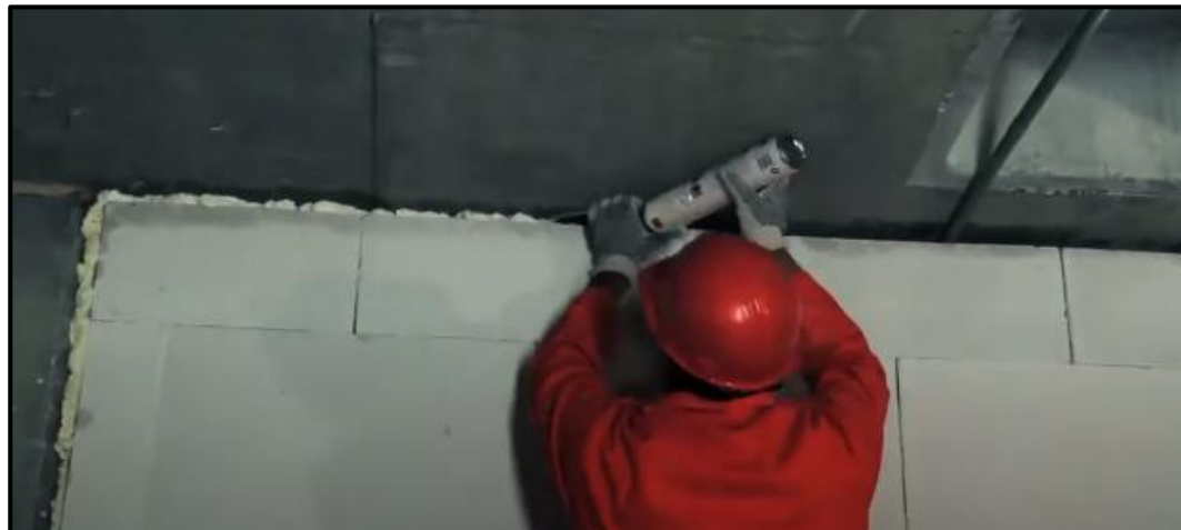
Figura 91. Aplicación de espuma de poliuretano en junta superior.
