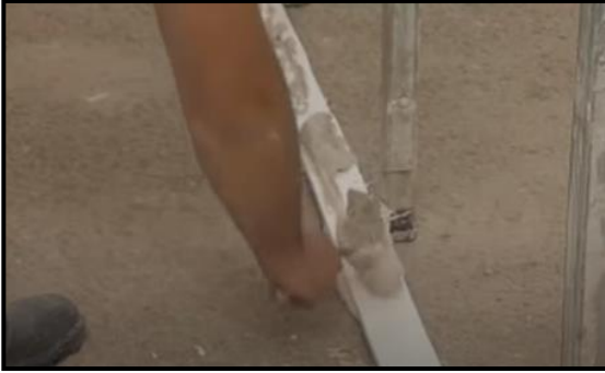
Figura 59. Aplicación de adhesivo para recibir primera hilada de tabiques.
