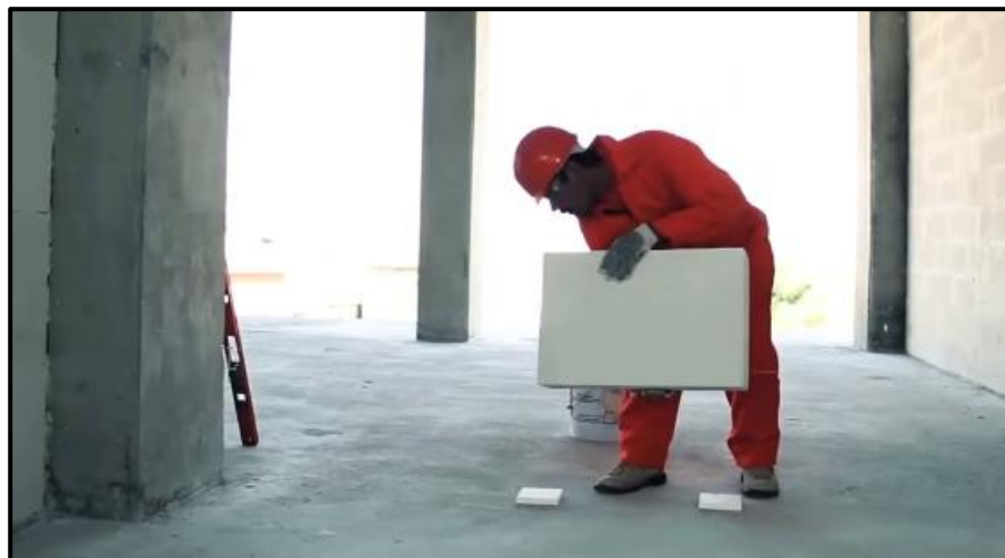
Figura 79. Desplante de primera pieza sobre las calzas.
