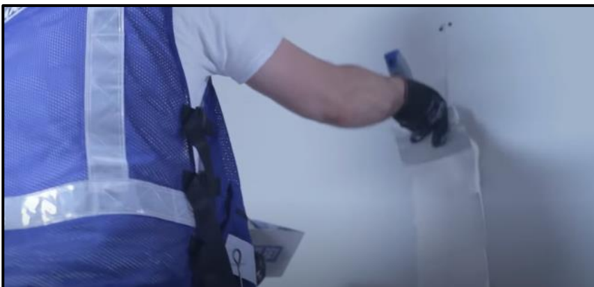
Figura 41. Aplicación de compuesto sobre la unión de los paneles.
