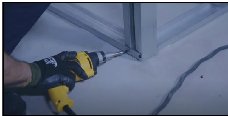
Figura 30. Atornillado de postes metálicos a canales de amarre.
