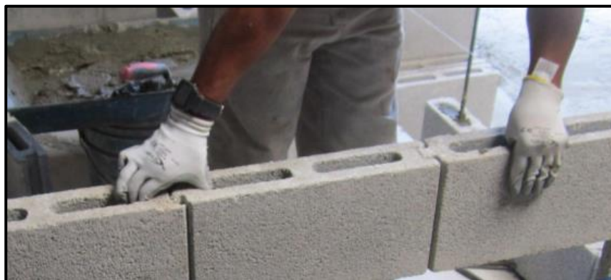
Figura 69. Colocación de 3 bloques a la vez.
