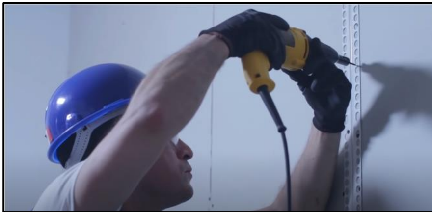
Figura 38. Colocación de junta de control a cada 9.10 m.
