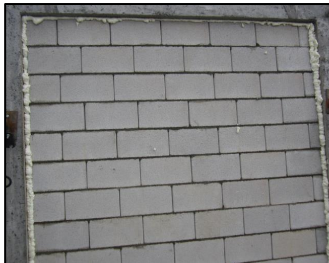
Figura 121. Sellado de juntas con poliuretano.
