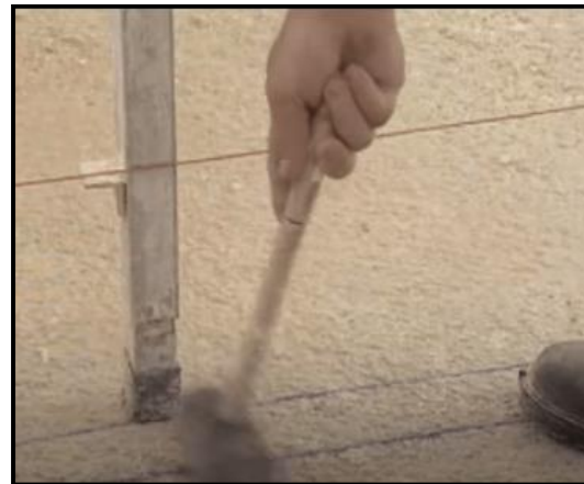
Figura 56. Verificación de la correcta alineación de reglas.
