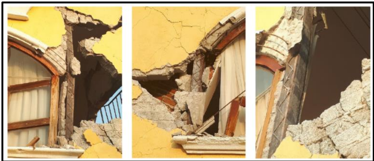
Figura 4. Uso de perfiles de acero como elementos confinantes de muros.
