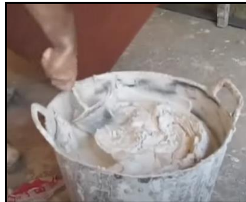
Figura 52. Mezcla con consistencia adecuada.
