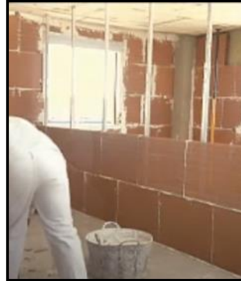
Figura 64. Colocación en forma cuatrapeada.
