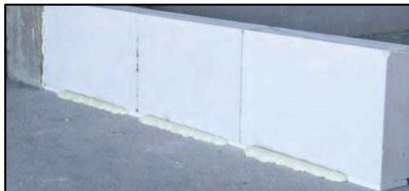
Figura 84. Expansión de espuma de poliuretano en desplante.
