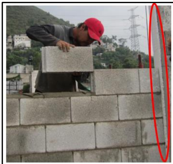
Figura 120. Placa de poliestireno expandido en junta.
