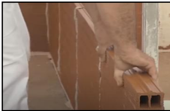
Figura 61. Pegado de tabiques.
