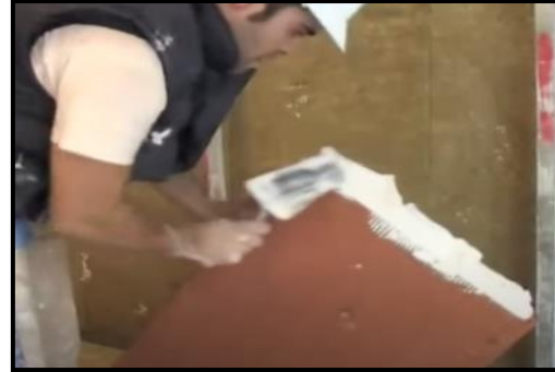
Figura 60. Aplicación de adhesivo en la cara lateral del tabique.
