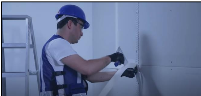
Figura 42. Colocación de cinta de papel a lo largo de la junta.
