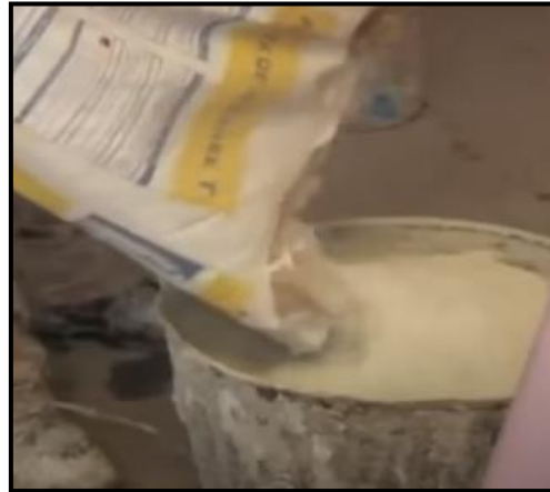
Figura 50. Adición del adhesivo.
