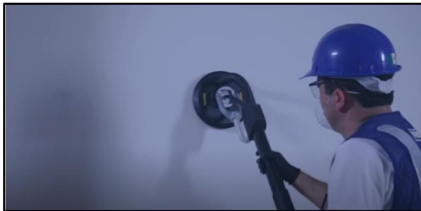
Figura 44. Lijado de la superficie del muro.
