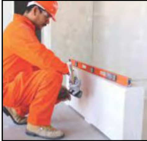
Figura 81. Verificación de alineación y plomo de hilada.
