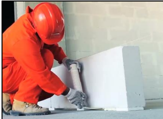
Figura 83. Sellado de juntas con poliuretano.
