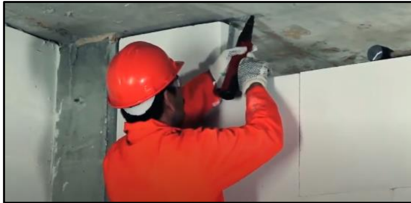
Figura 90. Sujeción de laminillas a elementos estructurales.
