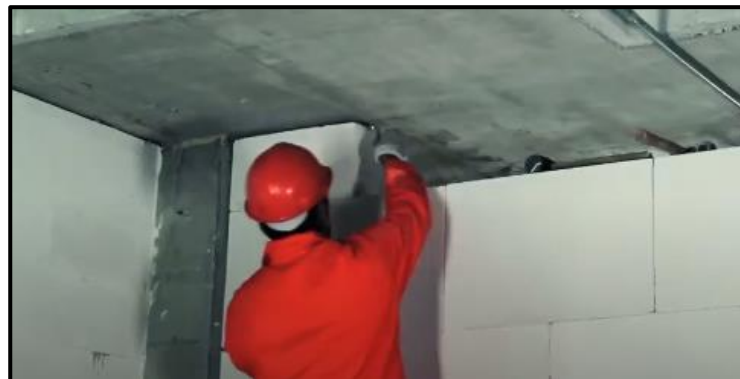
Figura 88. Colocación de la laminilla conectora.
