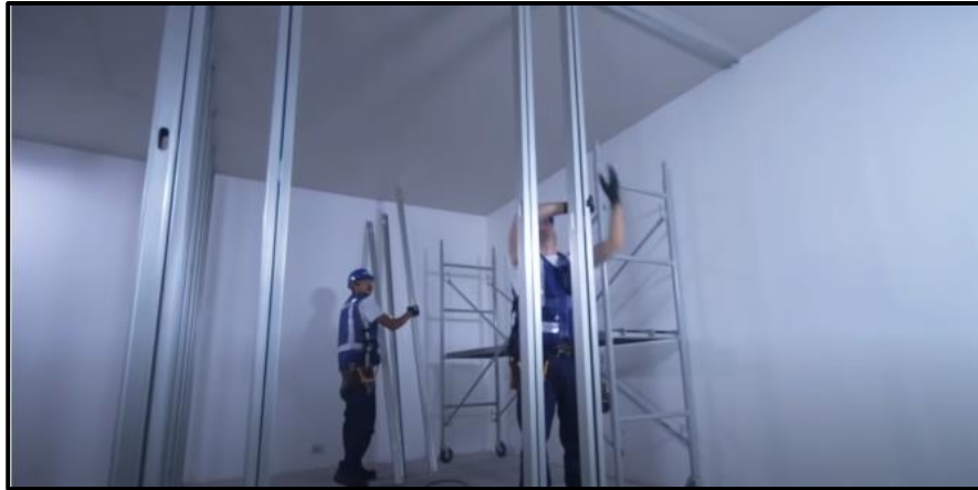
Figura 29. Colocación de doble poste para vanos de puertas y ventanas.
