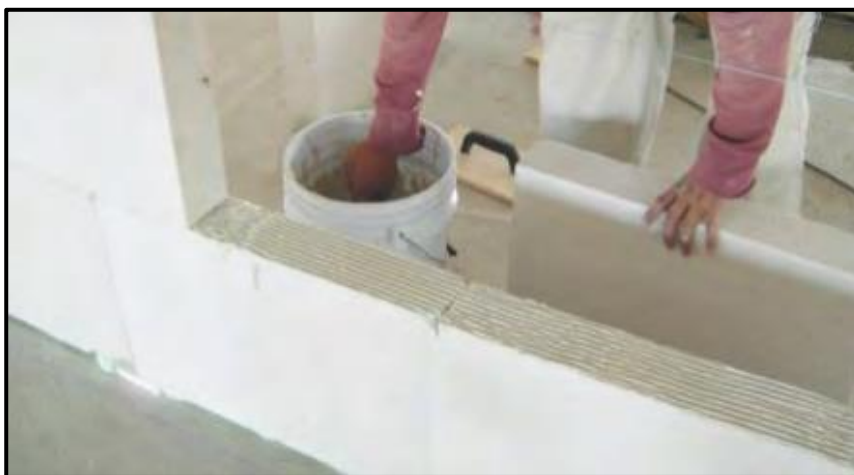
Figura 85. Aplicación del adhesivo.
