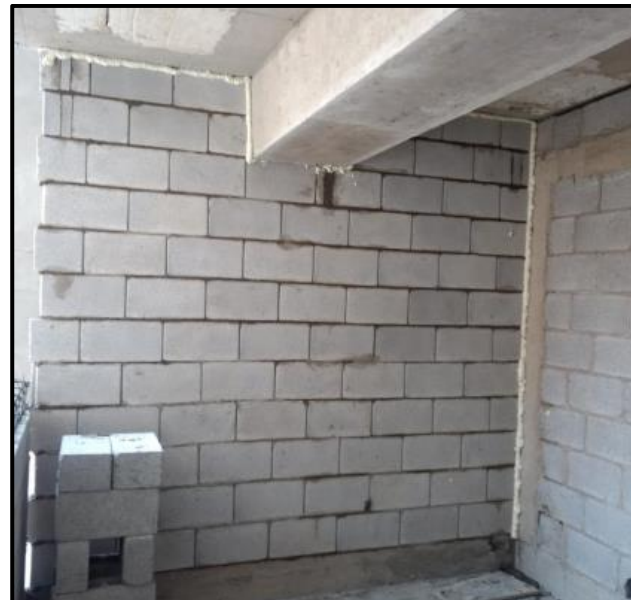
Figura 73. Espuma de poliuretano en el perímetro del muro para desligar de elementos estructurales.
