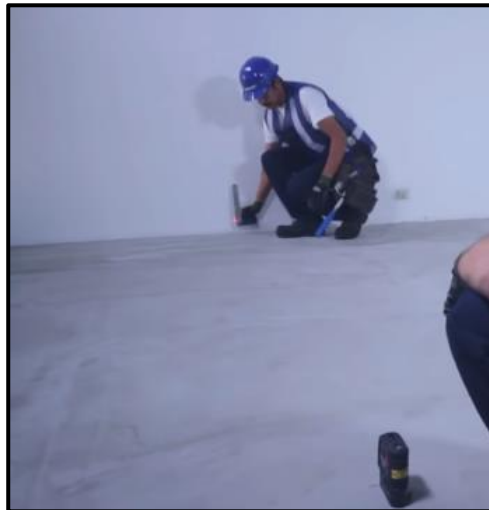
Figura 23. Identificación del lugar de colocación de canal inferior.
