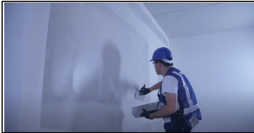
Figura 43. Aplicación de una delgada capa de compuesto sobre todo el muro.
