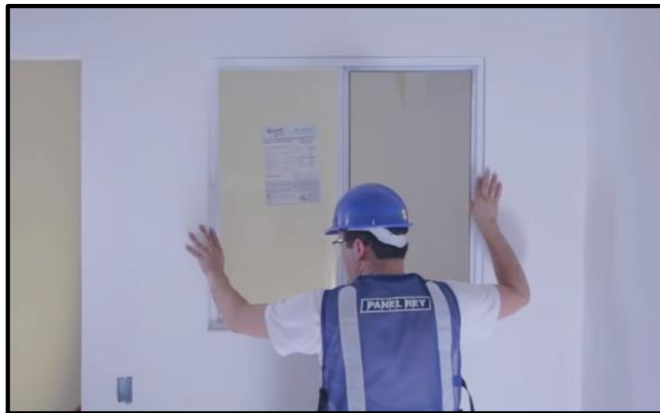
Figura 46. Instalación de puertas, ventanas y acabados finales.
