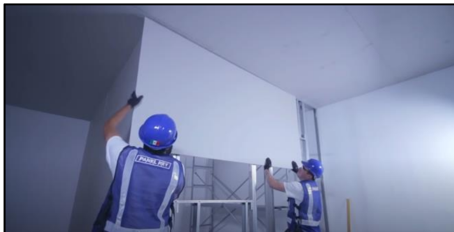
Figura 32. Instalación del panel de yeso en modo horizontal.
