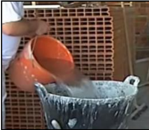
Figura 49. Colocación de agua necesaria en el recipiente.
