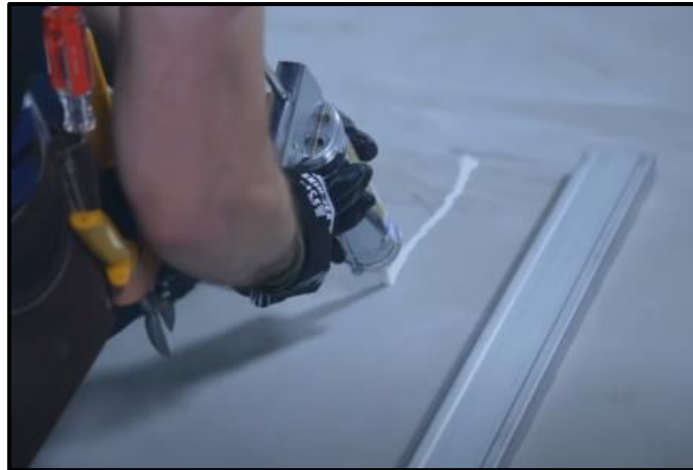
Figura 24. Colocación de sellador de silicón.
