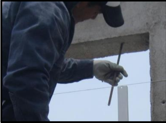
Figura 93. Anclaje de conexión.
