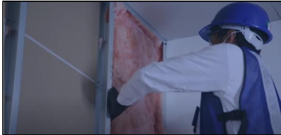
Figura 35. Colocación de fibra de vidrio.
