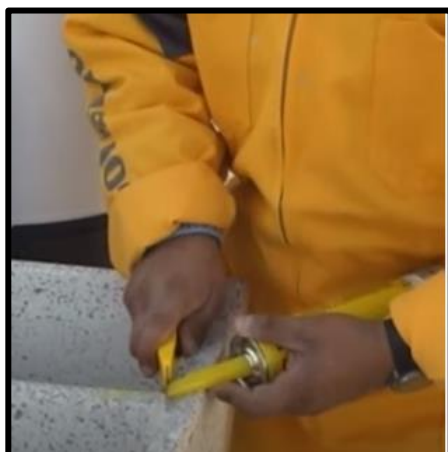
Figura 108. Corte en diagonal de la boquilla del cartucho.
