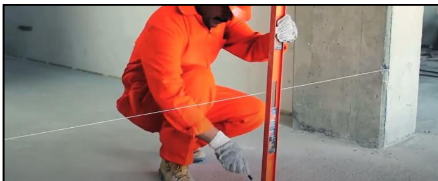
Figura 77. Trazo y plomo para desplante.
