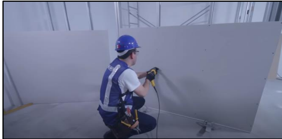
Figura 33. Atornillado de panel de yeso en postes metálicos.
