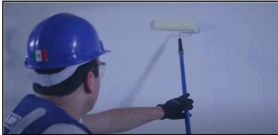
Figura 45. Aplicación de sellador acrílico sobre el muro.
