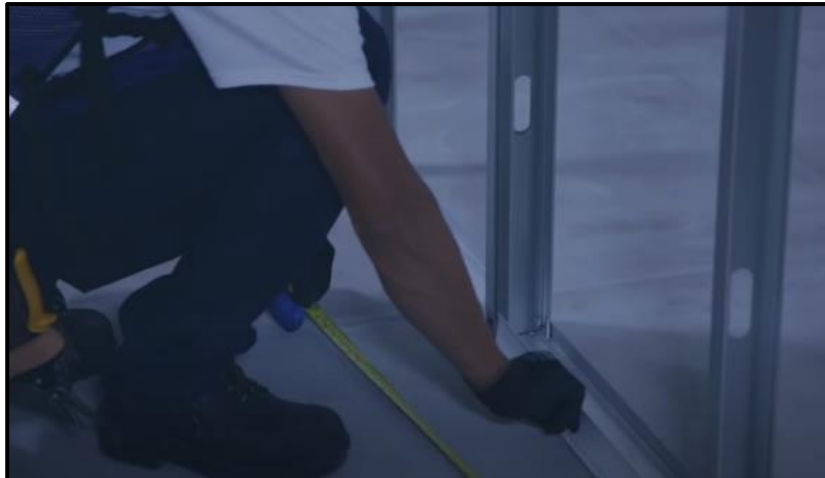
Figura 31. Colocación de reborde J metálico o de PVC.
