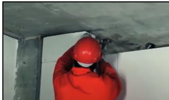
Figura 89. Sujeción de laminilla al block por medio de clavos.
