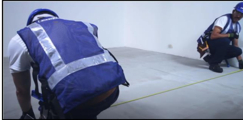
Figura 22. Trazo de líneas para desplante de muro.
