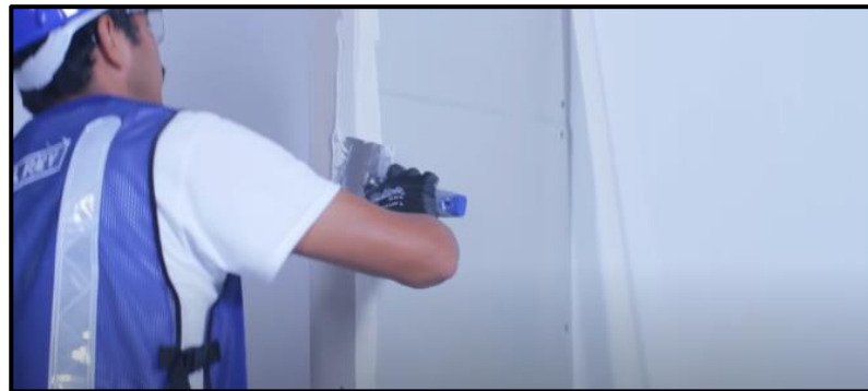
Figura 40. Aplicación de compuesto Ready Mix en ambos lados de la esquina.
