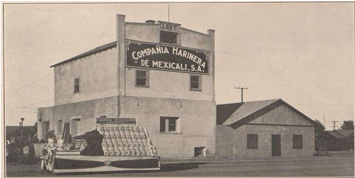
Imagen 12: Edificio de la “Compañía Harinera de Mexicali”, S. A.
