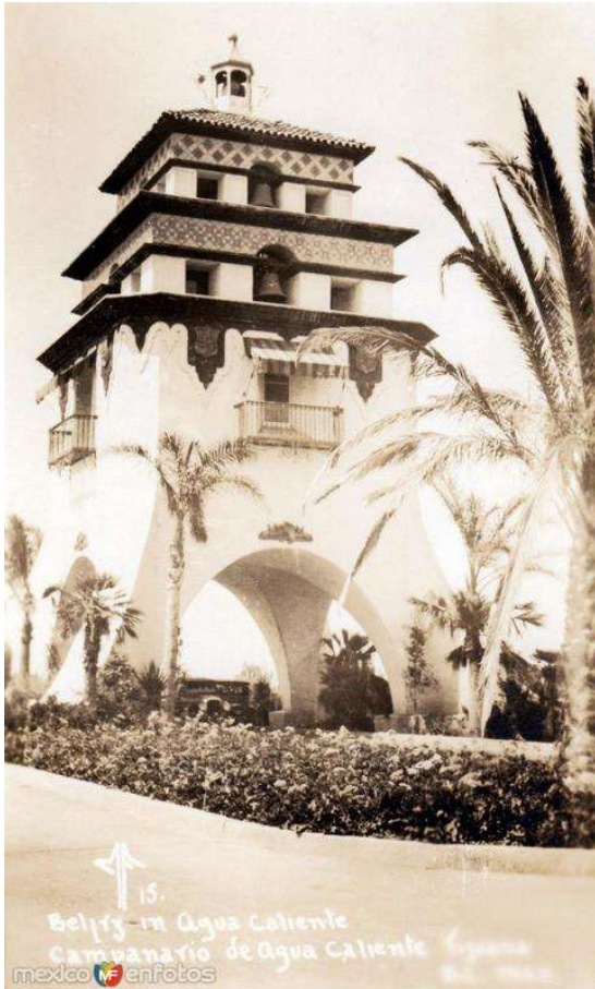
Imagen 20: Detalle de la torre campanario del club Agua Caliente, destacan los detalles en herrería de los balcones, las guardamalletas en la parte superior del primer cuerpo, los acabados en azulejo del segundo y tercer cuerpos, además de la teja en las techumbres inclinadas.
