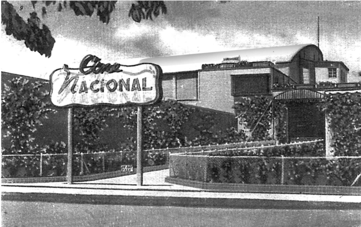
Imagen 56: Vista exterior del acceso del Cine Nacional sobre la calle Sonora, se observa la cubierta que se construyó posteriormente para cubrir el espacio de exposición.
