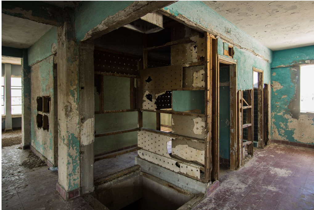
Imagen 92: Detalle de la estructura de concreto, ductos de instalaciones y bastidores de madera del hotel Laval. Fuente: Luis Valle, “Hotel Laval”, en Luis Valle . Flickr (27 de noviembre, 2016) [En línea]: https://www.flickr.com/photos/conquerde/30909867420/in/album-72157673171625683/ [Consulta: 31 de octubre, 2021].
