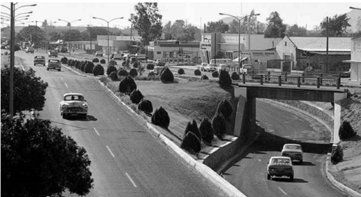
Imagen 141: A la derecha se observa el paso a desnivel sobre el bulevar Luis Encinas y calle Veracruz, desarrollado durante los años 60.
