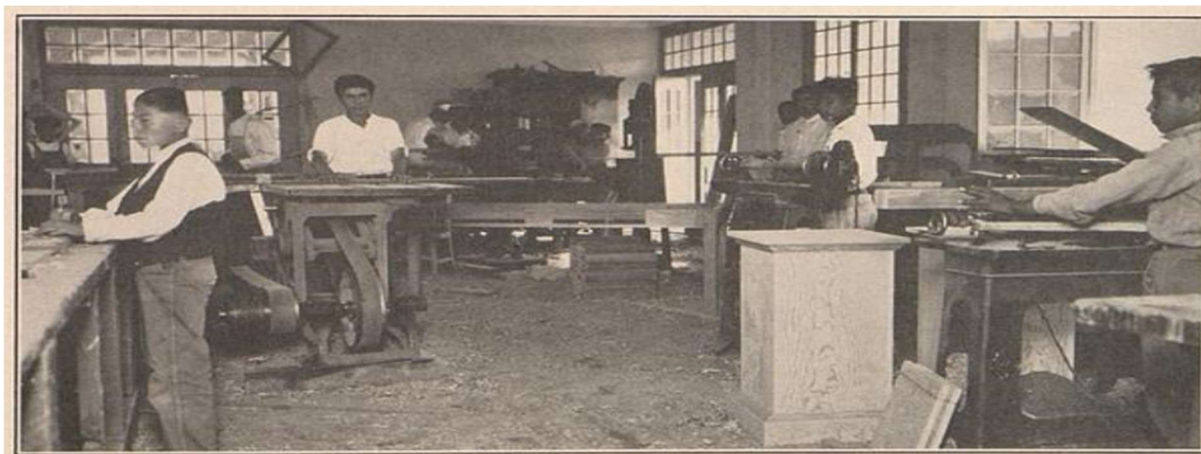
Imagen 8: Taller de Carpintería de la Escuela Industrial de Mexicali, construida entre 1926 y 1927. Fachada de los Talleres. Fuente: Abelardo Rodríguez Luján, Memoria administrativa del Gobierno del Distrito Norte de la Baja California, 1924-1927 . s.e., s.l., 1928, p. 61.
