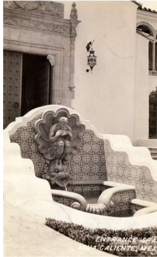
Imagen 21: Detalle de la fuente en el acceso al spa del club Agua Caliente, destaca su acabado en azulejo. Al fondo se observa el acabado en cantera del acceso al spa.
