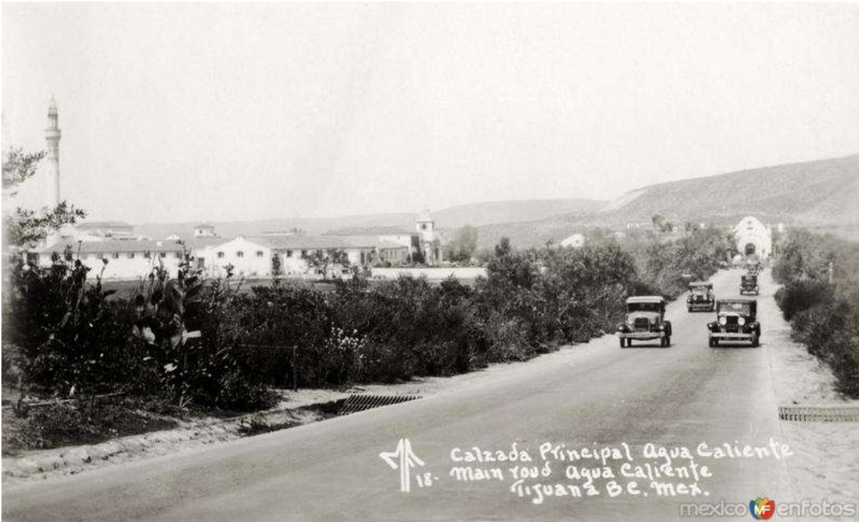
Imagen 22: Vista de la calzada de acceso del club Agua Caliente, a la izquierda se observa el minarete. Fuente: México en fotos [En línea]: https://www.mexicoenfotos.com/antiguas/baja-california/tijuana/calzada-principal-de-agua-caliente-MX16393385970031/2 [Consulta: 04 de febrero, 2023].
