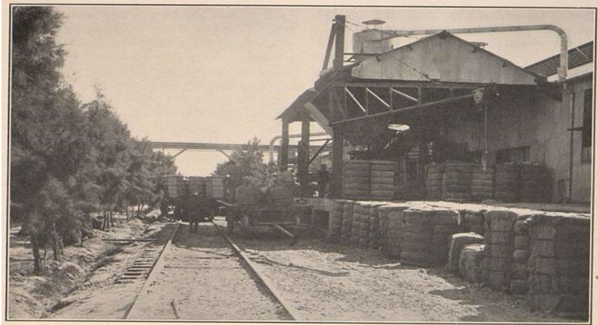
Imagen 9: “Compañía Industrial Jabonera del Pacífico”, S. C. L. Sección de embarque de la planta productora de borra. Fuente: Abelardo Rodríguez Luján, Memoria administrativa del Gobierno del Distrito Norte de la Baja California, 1924-1927 . s.e., s.l., 1928, p. 195.
