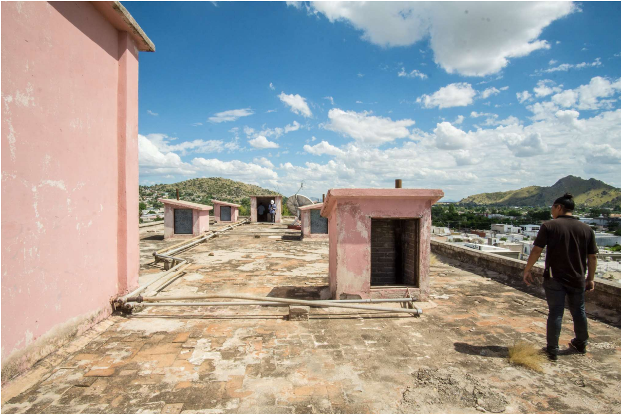
Imagen 94: Vista de la salida de los ductos en la azotea, hacia la izquierda se observa parte del cubo del elevador del hotel Laval. Fuente: Luis Valle, "Hotel Laval", en Luis Valle . Flickr (27 de noviembre, 2016) [En línea]: https://www.flickr.com/photos/conquerde/31162898791/in/album-72157673171625683/ [Consulta: 31 de octubre, 2021].
