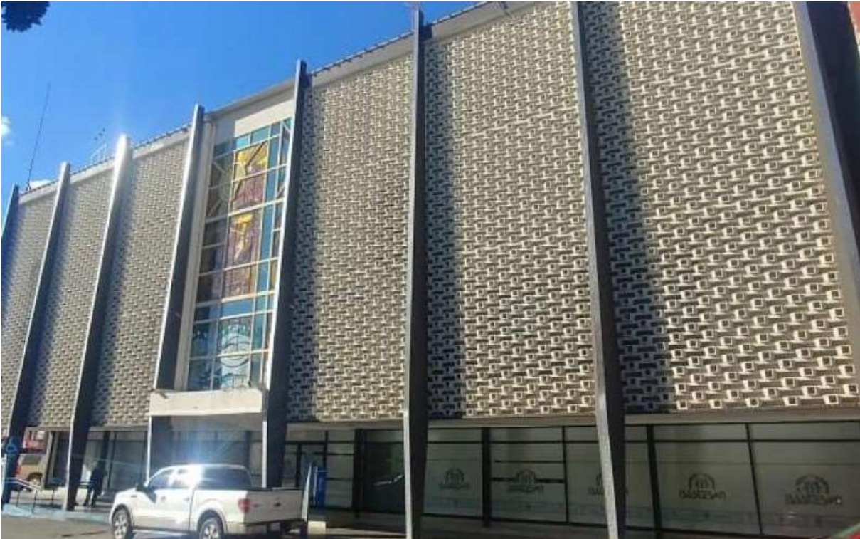
Imagen 126: Fachada principal de las Oficinas del ISSSTESON (1965) en el centro de Hermosillo, se observa la celosía que cubre la fachada sur y al centro el vitral como elemento decorativo.
