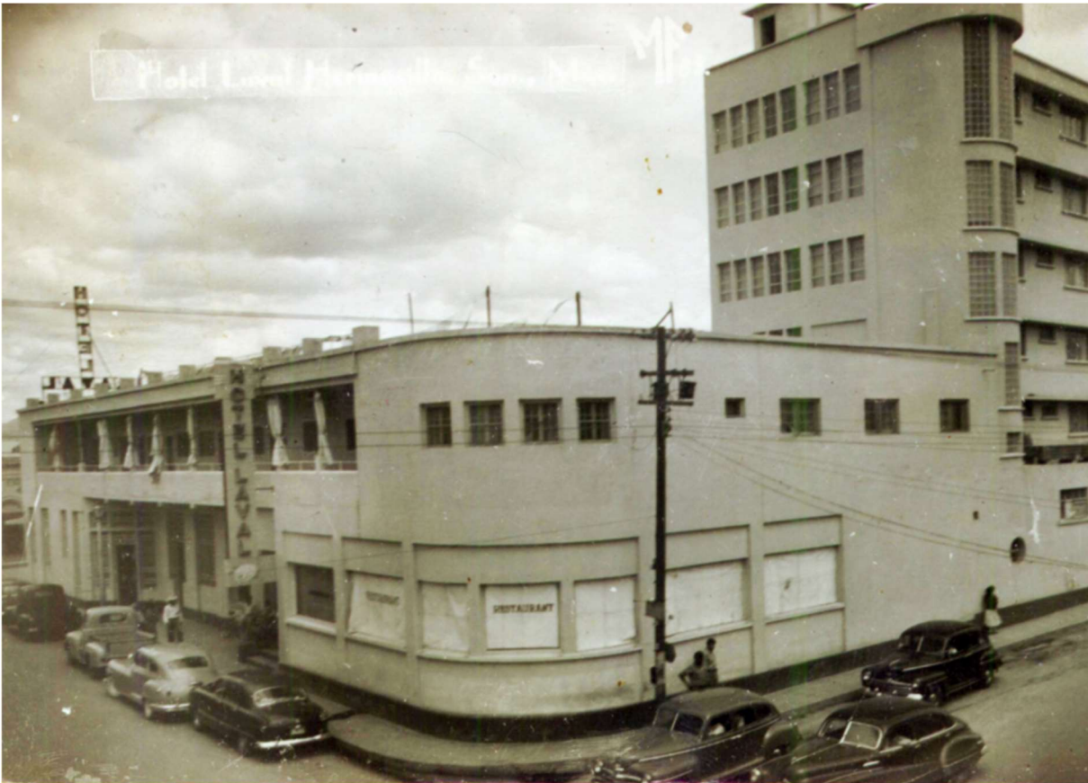
Imagen 86: Vista al frente del volumen que contenía la primera etapa del del hotel Laval de finales de los años 30 y al fondo la torre diseñada por el arquitecto Gustavo Aguilar desarrollada a partir de 1945.
