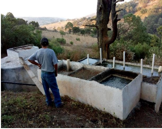
Sistema cuatro, fotografía por Dalia Tinoco. Técnico en construcción revisando el sistema.
