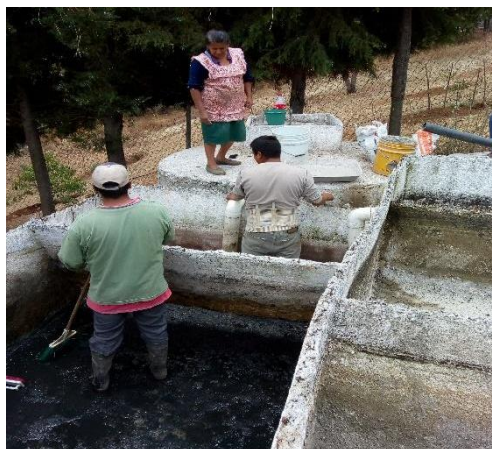
Sistema tres, fotografía por Dalia Tinoco. Usuarios del sistema realizando reparaciones en el biofiltro y trampa de grasas.
