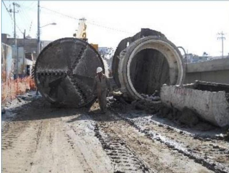
*Figura III.14 Desmonte de la tuneladora en la superficie.*
