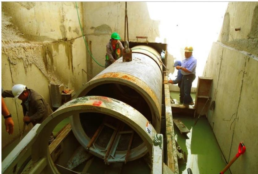
*Figura III.11 Colocación del tubo de concreto mediante grúa de izaje.*
