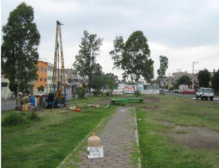
*Fotografía A.5 Imagen del sondeo mixto (SM-3) realizado, se aprecian las maniobras para la ejecución del sondeo.*
