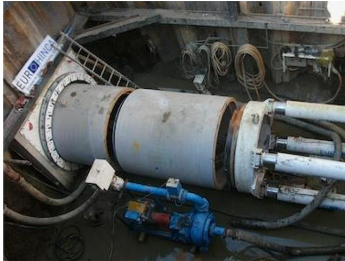
*Figura III.15 fijación de los cilindros hidráulicos.*
