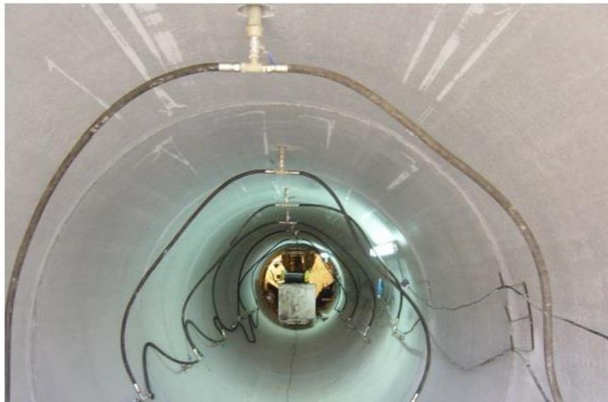
*Figura III.22 Sistema de inyección de bentonita.*
