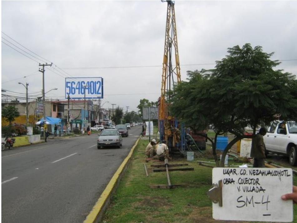
*Fotografía A.7 Imagen del sondeo mixto (SM-4) realizado, dicho sondeo se realizó sobre el camellón en la Av. Vicente Villada.*
