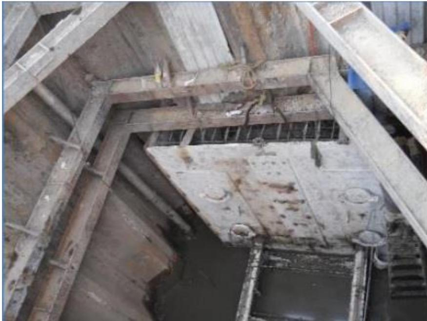
*Figura III.9 Muro de reacción.*
