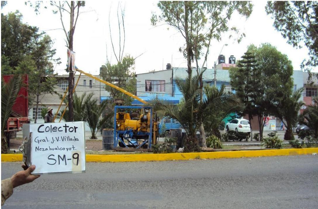
*Fotografía A.15 Imagen del sondeo mixto (SM-9) realizado, al igual que en varios de los trabajos, este sondeo se hizo en el camellón, se puede ver la disminución de su ancho.*
