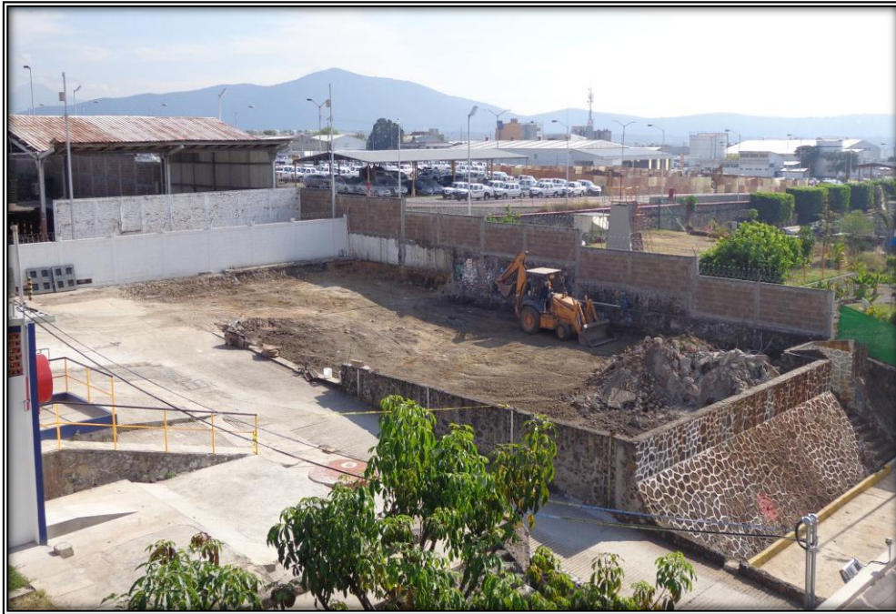
Figura 13. Foto de terreno. Se aprecia el terreno ya limpio, ya sin tanques ni bases. Foto emitida por el cliente como avance de obra.
