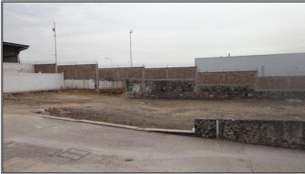
Figura 15. Foto de terreno. Vista frontal ampliada del terreno; se aprecia la pendiente del 7.5 % y la vialidad interna existente. Foto emitida por el cliente como avance de obra.
