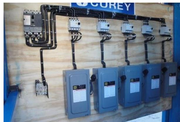
Fig. 4.24 Alambrado del gabinete eléctrico.
