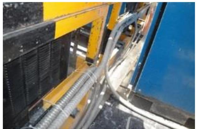
Fig. 4.25 y fig. 4.26 Cable eléctrico Stabiloy tetrapolar 3/0 AWG canalizado, instalado en forma temporal.
