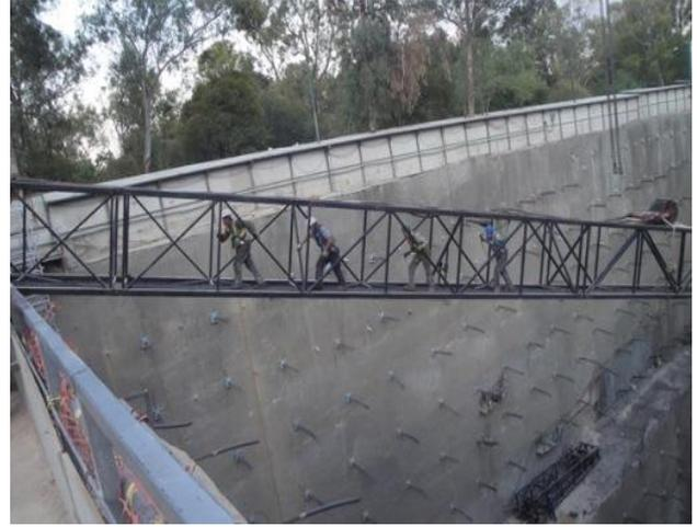
Fig. 2.9 Pluma en proceso de montaje.
