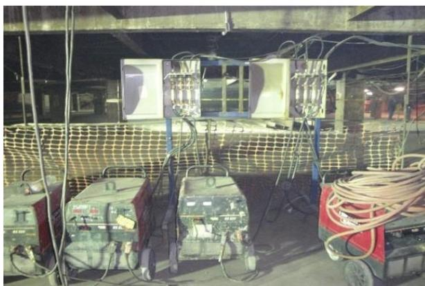
Fig. 4.21 Rack de interruptores típico de obra.
