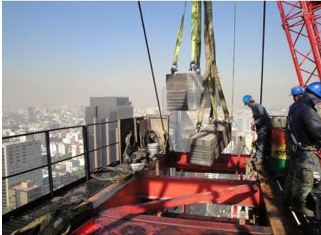
Fig. 2.14 Instalando bloque de contrapesos fijos.
