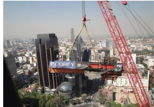
Fig. 2.11 Contrapluma izada con grúa derrick.
