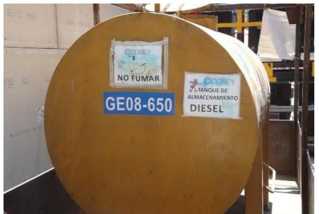
Fig. 4.19 Depósito de combustible fuera del gabinete.
