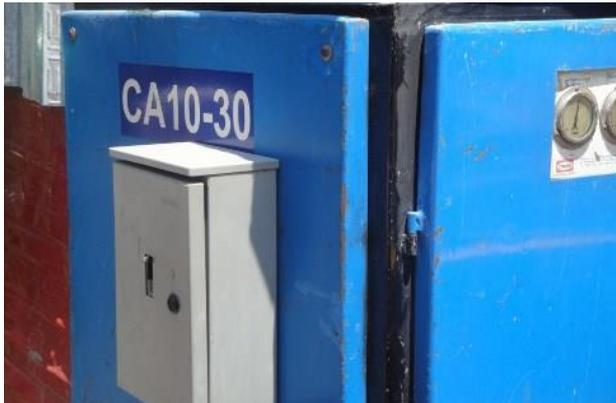
Fig. 4.27 Compresor de 30 hp en gabinete acústico.
