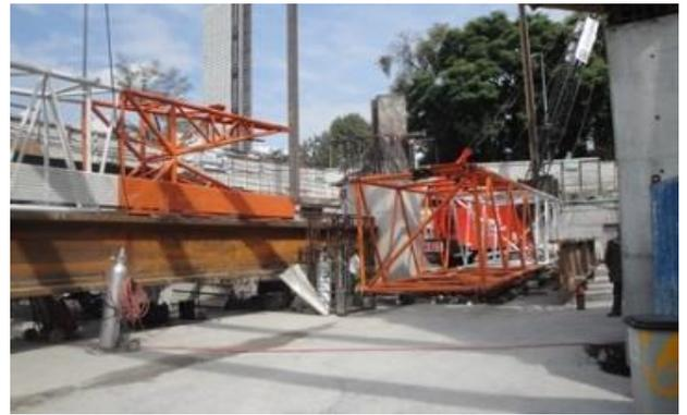
Fig. 4.32 Módulos de pluma dentro de la obra.
