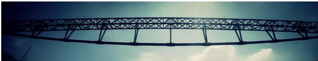
Fig. 4.6 Viga Brunel (137 metros de longitud y 350 toneladas de peso) proyecto Arena Ciudad de México.
