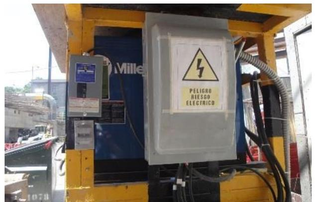
Fig. 4.30 Derivación a 115 V en rack de soldadoras.
