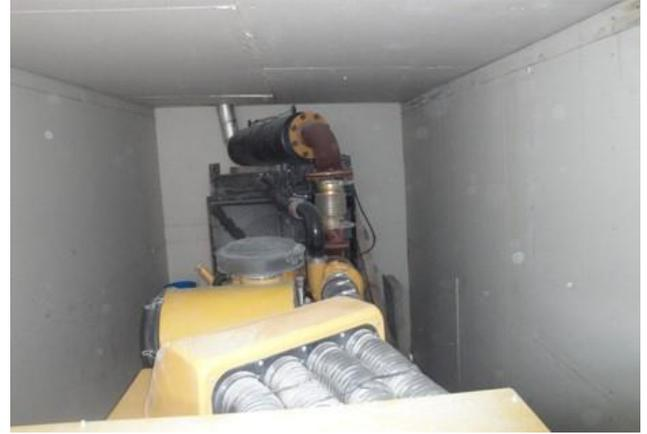
Fig. 4.17 Generador Caterpillar 650kVA dentro del gabinete acústico.
