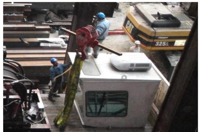
Fig. 2.16 Izaje de la cabina de operación.
