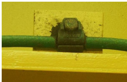
Imagen III.4.1. Conector Mecánico Atornillable
