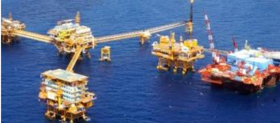
Imagen II.5. Plataforma de Tratamiento y Bombeo
