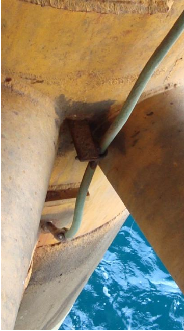
Imagen III.4.2. Bajada a Electrodo de Puesta a Tierra.
