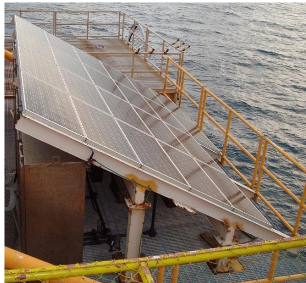
Imagen III.1.11. Localización del Banco de Baterías.
